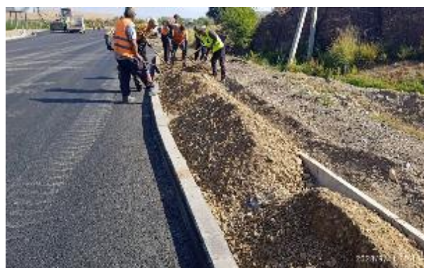
Фото 22. Устройство тратуара. Сентябрь.
