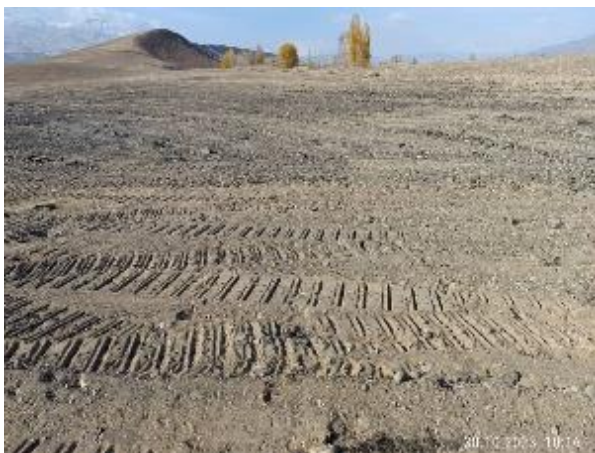
Фото 93. Отвал старого асфальта км. 70+180 LHS после рекультивации. Октябрь
