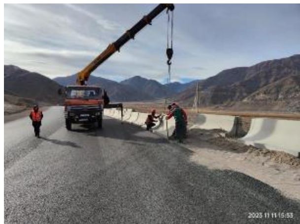
Фото 29. Установка парапетов на 40+700-40+870 RHS.Ноябрь
