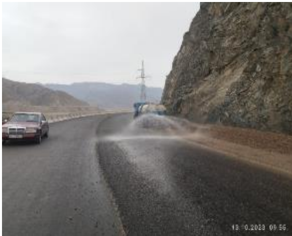
Фото 75. Гидроорошение дороги км. 12+700. Октябрь
