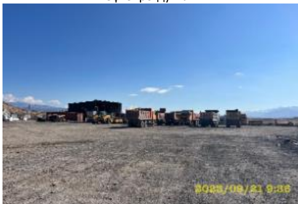
Фото 87. Сентябрь. Санитарное состояние территории стоянки строительной техники – удовлетворительное.
