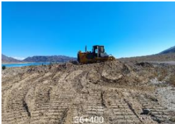
Фото 71. Планировка отвала непригодного грунта км.36+400. Сентябрь
