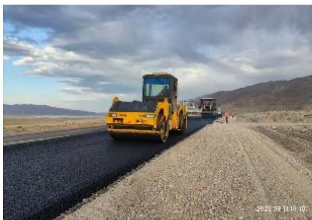
Фото 15. Укладка ЩМА на 39+424-40+545 LHS. Сентябрь.
