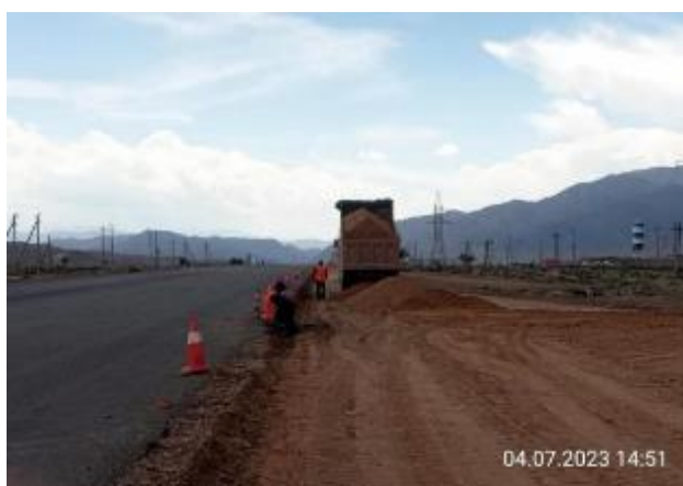
Фото 7. Лот 1. Отсыпка саббейс материала на съезде в сторону южного берега 0+020-0+180 RHS.Июль
