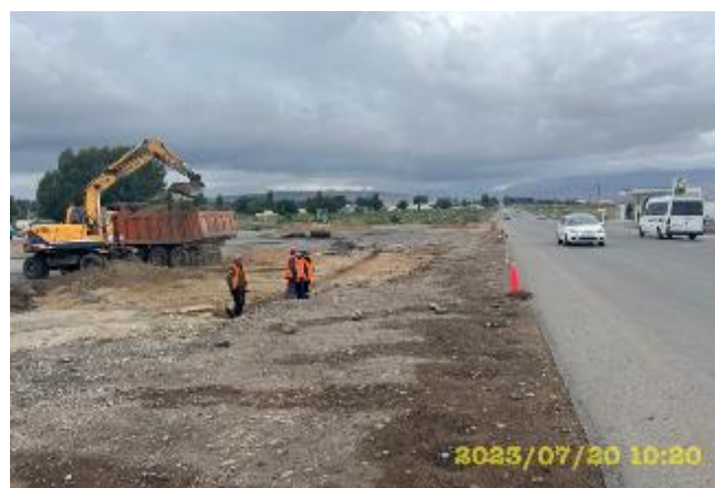
Фото 8. Лот 1. Устройство съезда на км.2+680 LHS. Июль.
