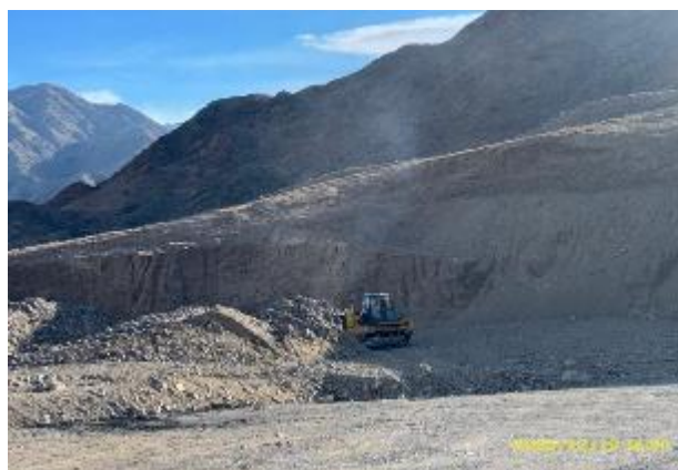
Фото 66. Техническая планировка карьера км 34+240 и приведение откосов борта карьера в безопасное состояние. Декабрь
