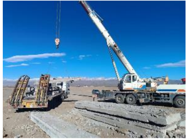
Фото 98. Вывоз демонтированных частей временного моста объездной дороги на км 62+500
