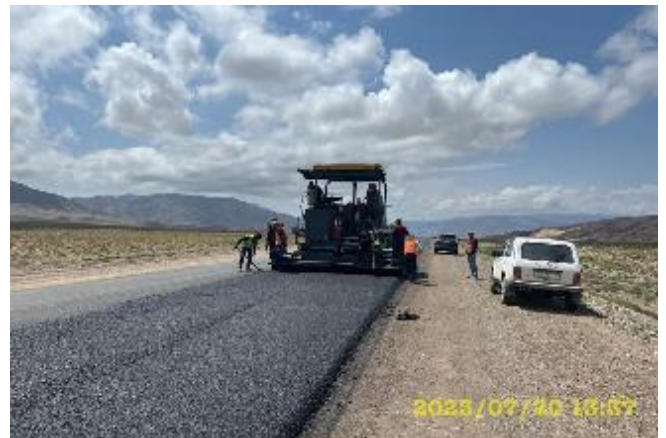
Фото 10. Укладка ЩМА. ПК 27-824--25+005 RHS. Июль
