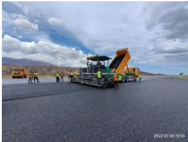
Фото 11. Лот 1. Укладка ЩМА-20 на 31+000-31+120 LHS (стоянка). Июль
