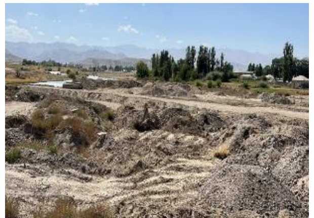
Фото 94. Отвал на км. 62+520 LHS до рекультивации
