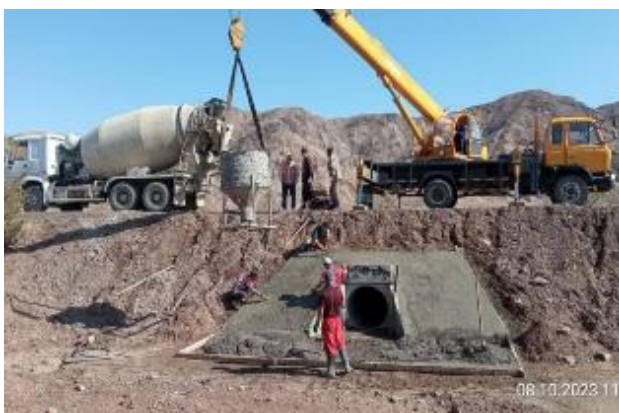
Фото 27. Укрепление входа и выхода бетонном водопропускной трубы на 18+326BS. Октябрь
