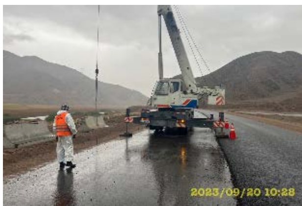
Фото 17. Монтаж бордюра на км.42+000-43+000 Сентябрь
