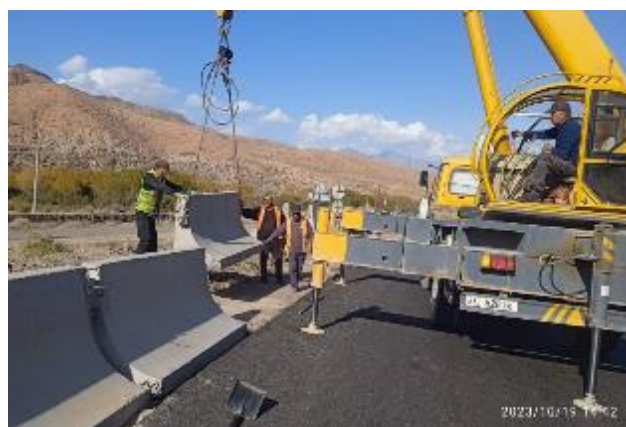
Фото 24. Монтаж бордюра на км.11+200. Октябрь
