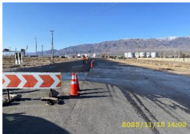
Фото 30. Подготовка к укладке асфальта на съезде км. 2+680 LHS. Ноябрь
