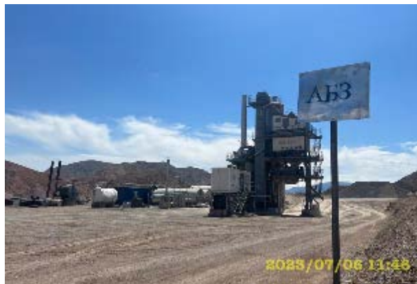
Фото 62. Производственная база АБЗ. Санитарное состояние территории удовлетворительное. Июль.
