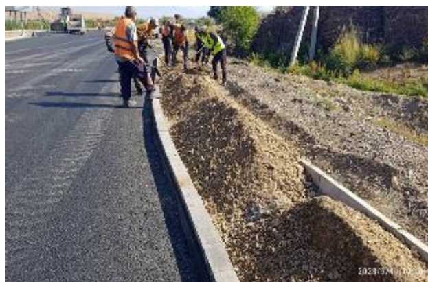
Фото 20. Устройство тратуара. Сентябрь.
