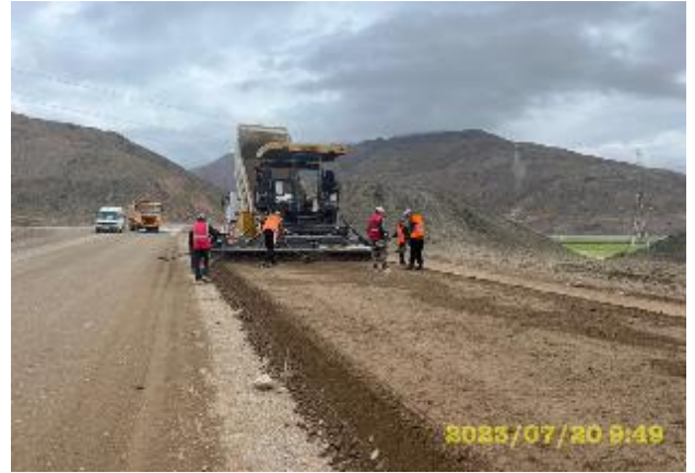
Фото 10. Лот 1. Зем. работы на км. 42+000-43+000. Июль
