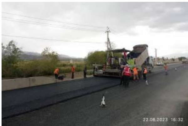
Фото 37. Устройство ЩМА на участке км 67+945-68+915 RHS. Август.
