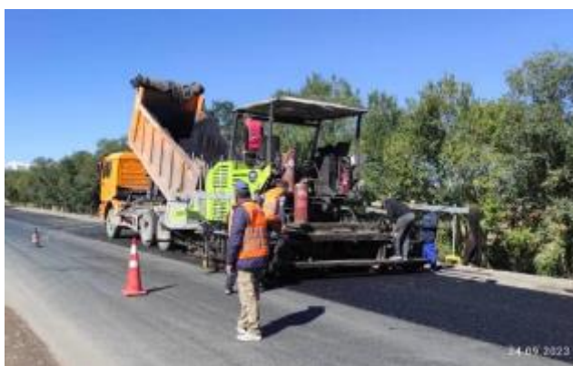
Фото 39. Устройство ЩМА км 85+500-87+000 RHS. Сентябрь
