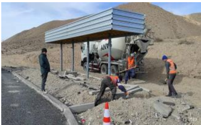
Фото 43. Установка бордюров на остановке км 89+161. Ноябрь.
