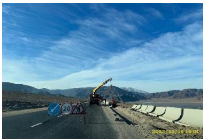
Фото 32. Устройство парапетов на км. 32+000-34+000. Декабрь
