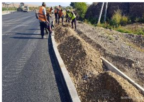
Фото 40. Устройство тратура. Сентябрь
