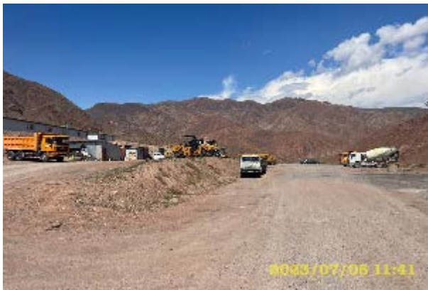
Фото 61. Санитарное состояние территории стоянки строительной техники удовлетворительное. Июль
