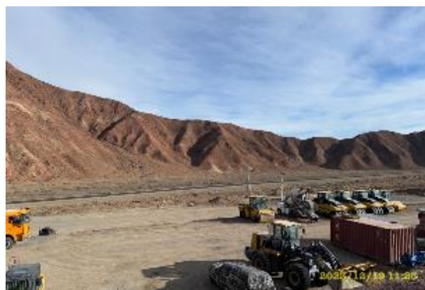
Фото 64. Санитарное состояние территории стоянки строительной техники удовлетворительное. Декабрь.
