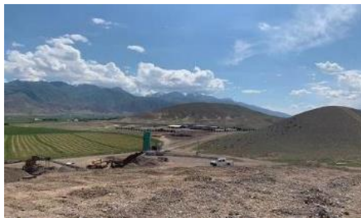
Лот 2 территория объекта с камнедробильной установкой на переднем плане и лагерем Подрядчика на заднем плане.
