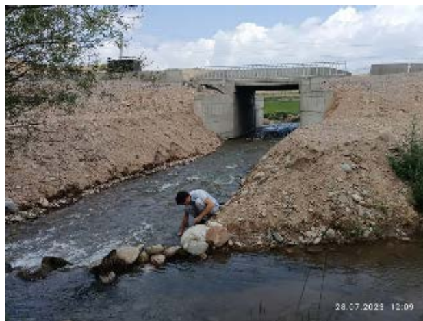
Фото 122. Лот 2. Км 88+795.река Жар-Корунду. Июль
