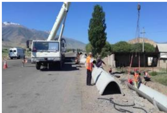
Фото 34. Установка лотков км 87-459-87+650 RHS. Июль
