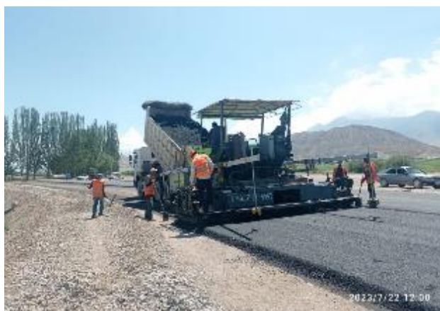
Фото 35. Укладка нижнего слоя а/б покрытия (кольцевая развязка). Июль.
