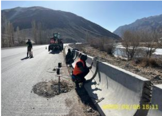
Фото 9. Лот 1. Монтаж установленных парапетов с км 14+000-15+000. Февраль
