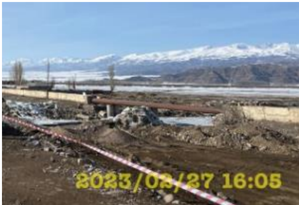
Фото 99. Отвал на км. 65+520 RHS до рекультивации
