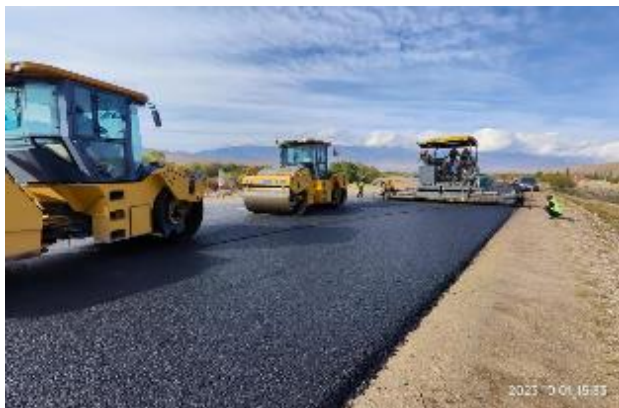
Фото 25. Укладка ЩМА на 9+700-10+600 LHS. Октябрь.
