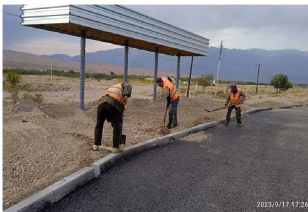
Фото 19. Зем.работы по устройству остановки с.Таш-Сарай. Сентябрь.
