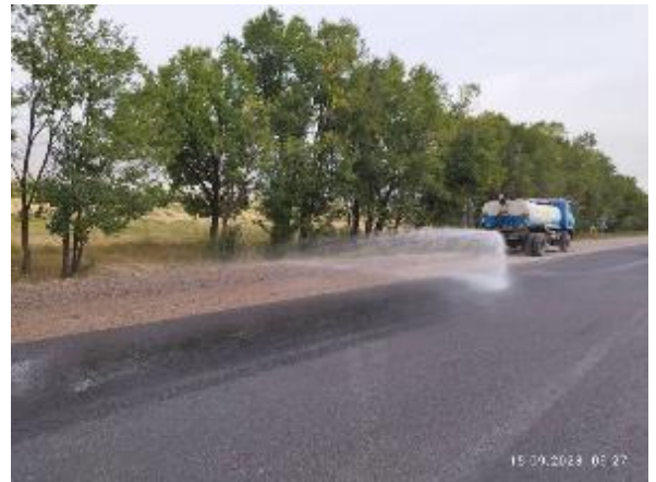
Фото 110. Гидроорошение дороги км. 66+200. Сентябрь
