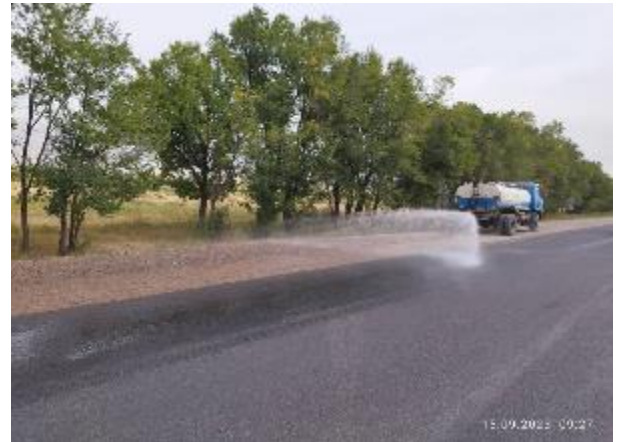
Фото 74. Гидроорошение дороги км. 66+200. Сентябрь
