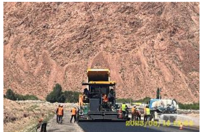
Фото 12. Укладка ЩМА. ПК 15+100 LHS. Август.
