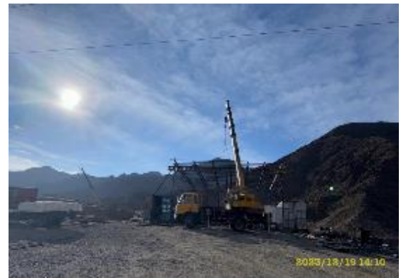
Фото 70. Производственная база. Демонтаж ремонтно-механического блока
