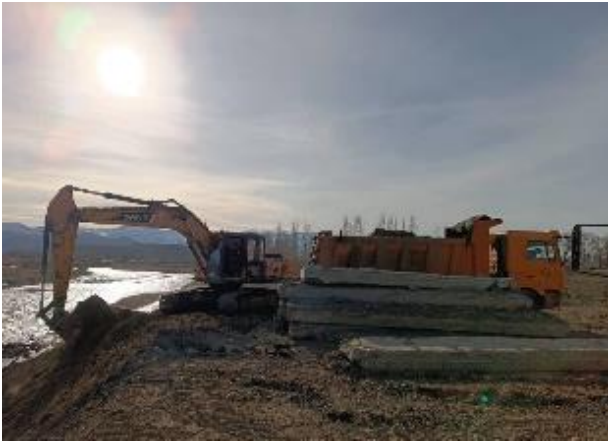
Фото 97. Демонтаж временного моста объездной дороги на км 62+500
