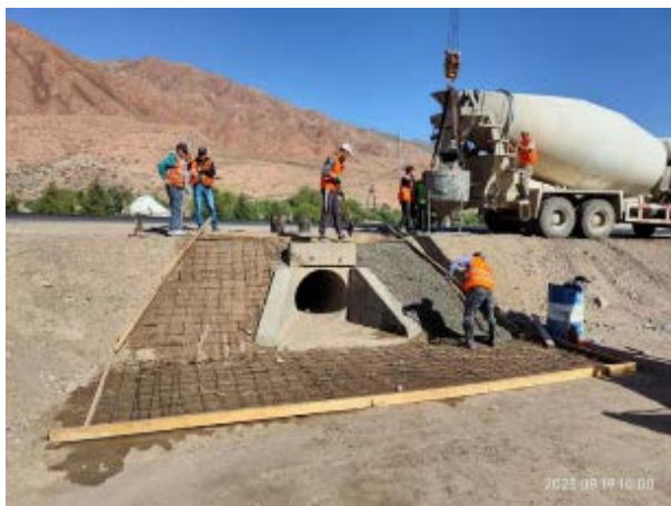
Фото 13. Укрепление входа и выхода бетоном водопропускной трубы на 13+763 BS. Август
