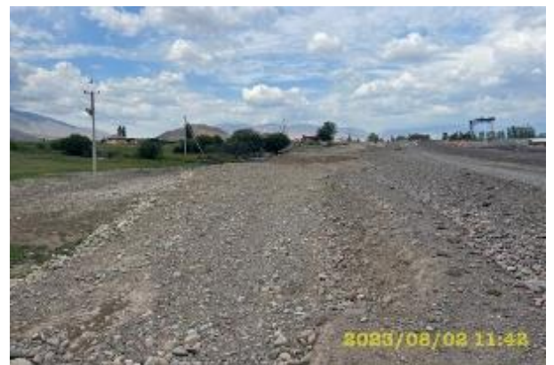
Фото 114. Участок объездной дороги, после рекультивации и осушения прилегающего затопленного участка.
