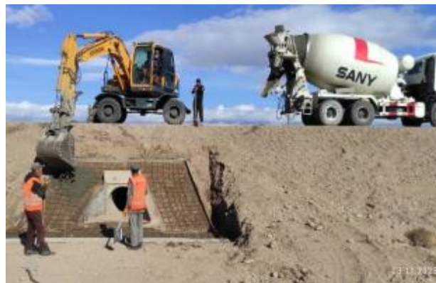
Фото 44. Укрепление откосов на входе водопропускной трубы км 71+800 LHS. Ноябрь.
