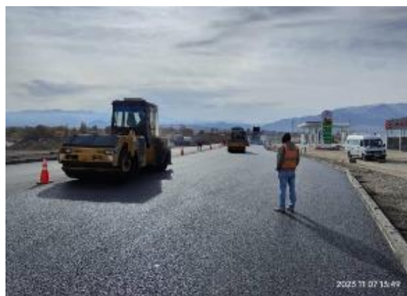
Фото 28. Укладка ЩМА на 0+600+0+840 RHS. Ноябрь
