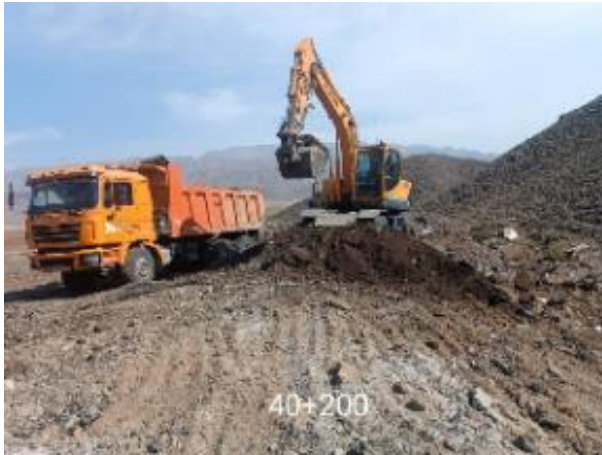
Фото 73. Планировка отвала старого асфальтакм. 40+200. Сентябрь
