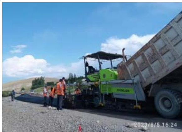
Фото 38. Укладка нижнего слоя а/б покрытия на км 85+900-86+500 RHS. Август.
