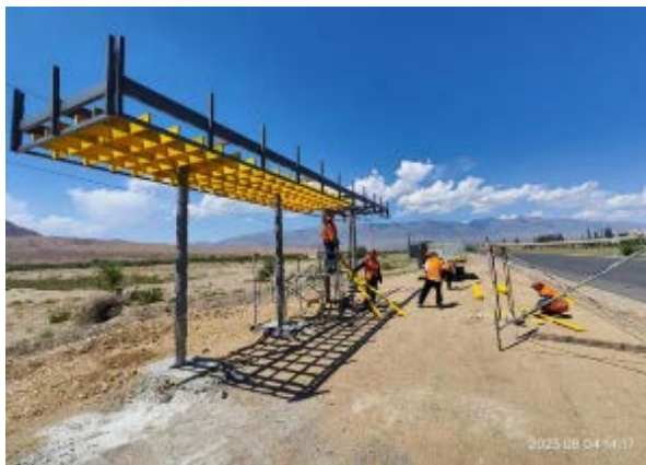
Фото 11. Лот 1. Строительство остановочного навеса на 9+070 RHS. Август
