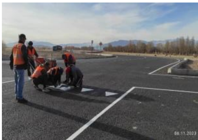
Фото 42. Нанесение дорожной разметки на кольцевой развязке. Ноябрь
