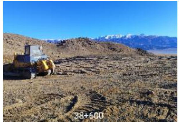
Фото 72. Планировка отвала старого асфальта км. 38+600. Сентябрь
