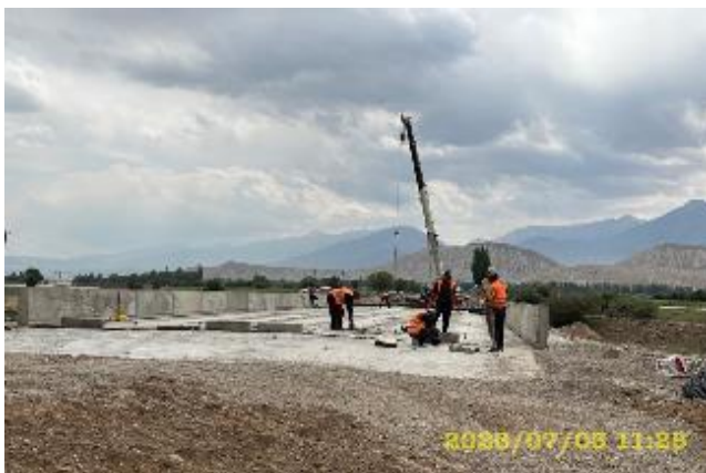
Фото 33. Монтаж мост на км. 65+410. Июль
