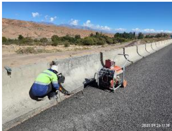
Фото 14. Сварка связующих арматур парапетов 13+240-13+480 RHS. Сентябрь.
