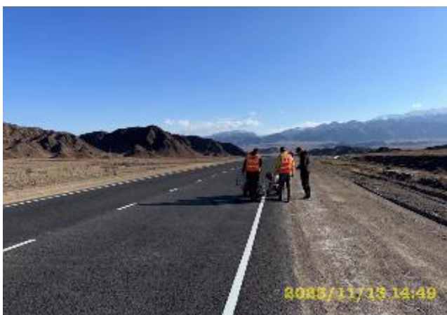
Фото 31. Разметка дороги на участке км. 18+000-20+000. Ноябрь
