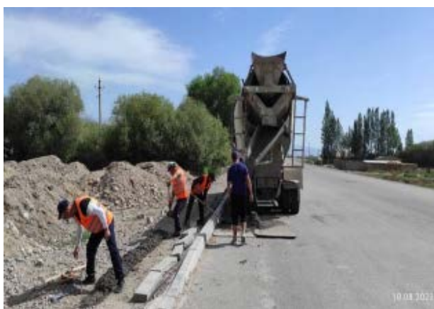
Фото 36. Установка тротуарных бордюров км 86+500-87+000 RHS. Август.
