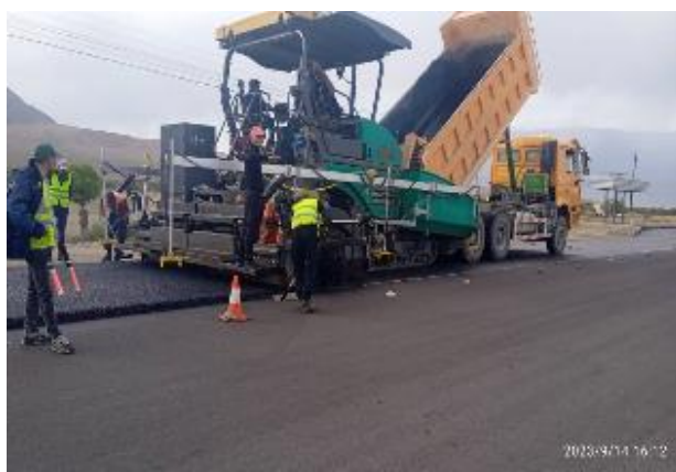
Фото 16. Укладка ЩМА, с.Таш-Сарай. Сентябрь.
