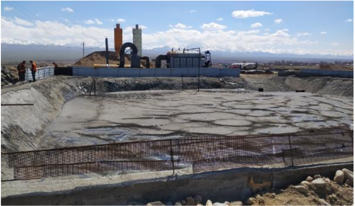
Рисунок 10: Битумная яма. Битумная яма обустроена железобетонными стенами и дном, для предотвращения проникновения нефтепродуктов в почву.
