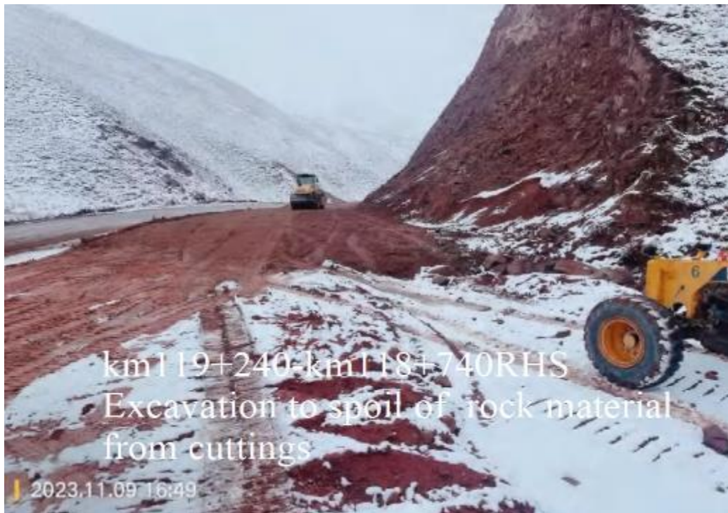
Рисунок 5: Работы на строительном участке
