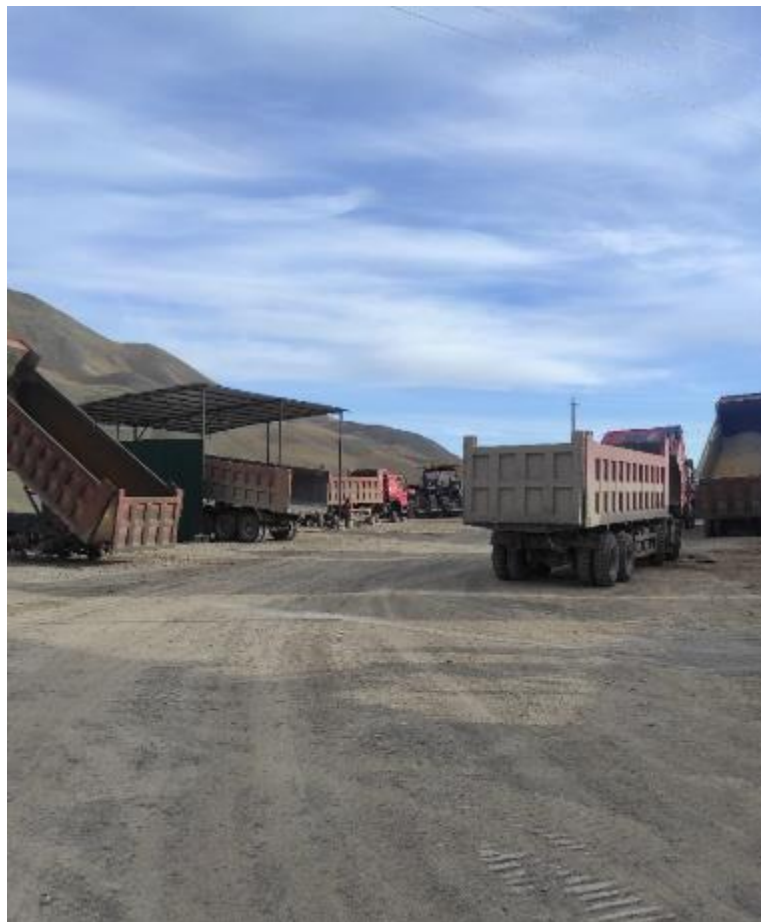
Рисунок 13: Территория дополнительного строительного лагеря (км 106+300)
