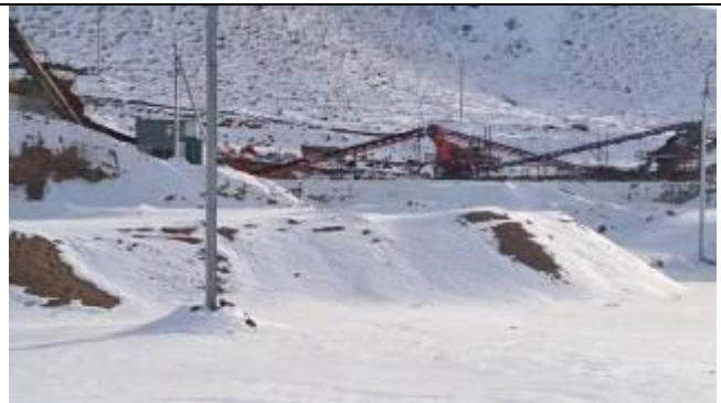
Photo 47. Production site, CSP, km 202+220 RHS
