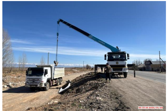
Фото 58 Вывоз демонтированных частей водопропускного сооружения на км. 194
