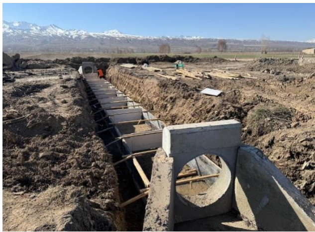
Фото 15. Км 212+611, монтаж в/пр сооружения
