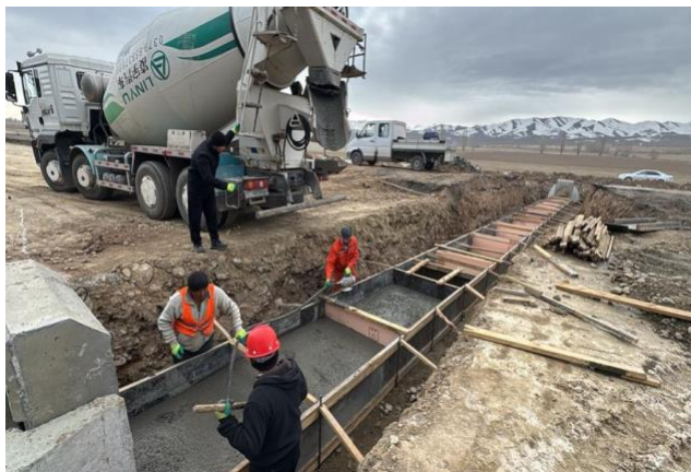
Фото 17. Бетонирование фундамента, 211+191
