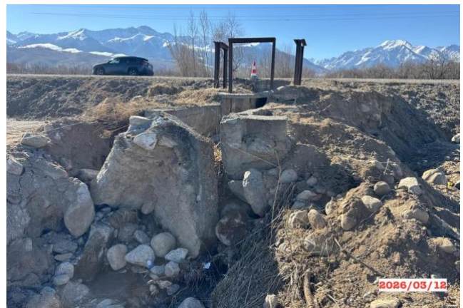
Фото 18. Водопропускная труба, на км.141+140 LHS. Выход
