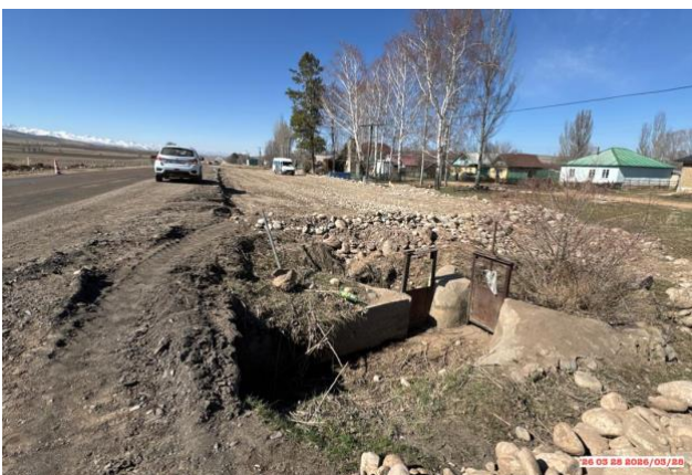
Фото 23. Водопрпускная труба, на км.195+830 LHS, выход.
