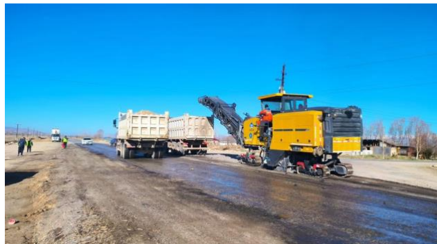
Фото 53. Гидроорошение участков асфальтового покрытия, перед его вскирковкой
