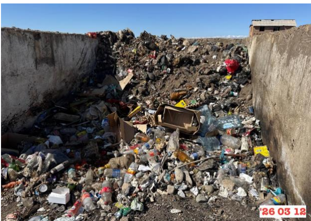
Фото 47. Лагерь строителей в с.Чырак, хранение ТБО не соответствует экологическим и санитарным нормам. 12 марта 2026 г.
