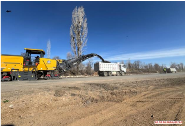
Фото 13. Фрезеровка асфальта км.203+300
