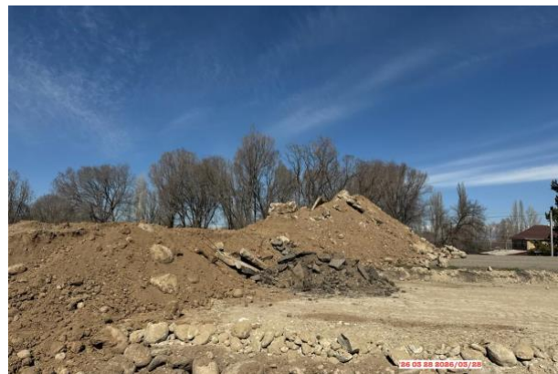
Фото 60. Складирование фрезерованного асфальта на строительных участках
