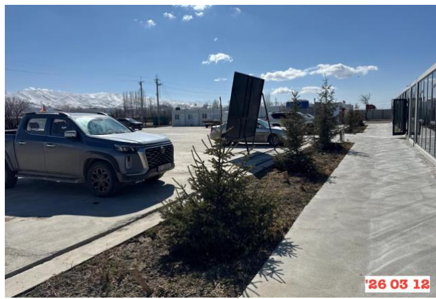
Фото 42. Лагерь строителей и офис в с.Чырак, км. 200+000
