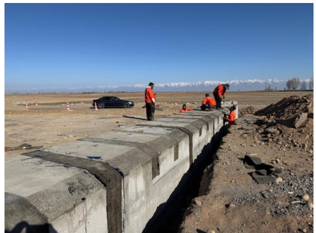
Фото 16. Гидроизоляция швов, км 204+400
