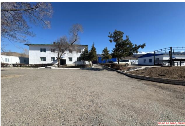
Фото 41. Лагерь строителей и офис в с.Ак-Терек, км. 152+700
