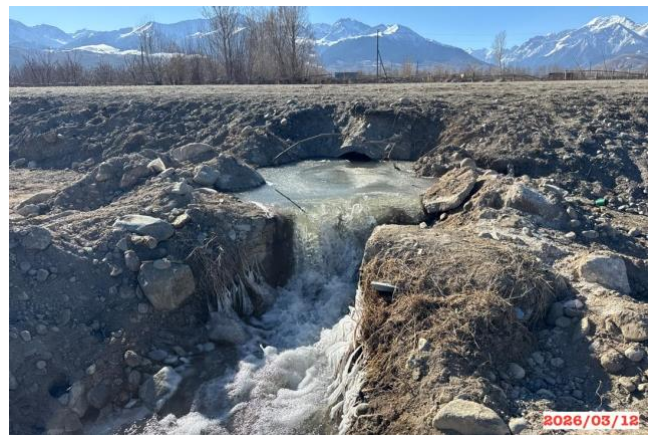
Фото 22. Водопрпускная труба на км 140+760, ВЫХОД
