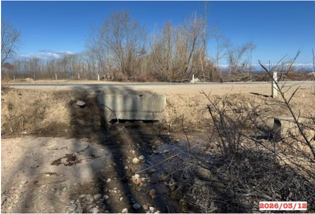
Фото 19. Селепропуск на км.151+020 RHS. ВХОД
