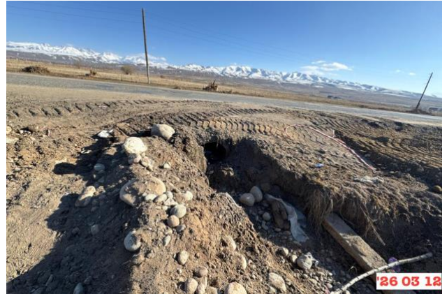
Фото 26. Водопрopusкная труба, на км.198 LHS, выход
