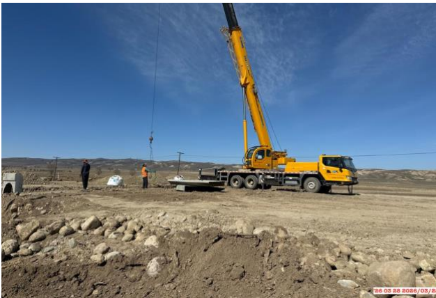
Фото 57. Вывоз демонтированных частей водопропускного сооружения на км. 194
