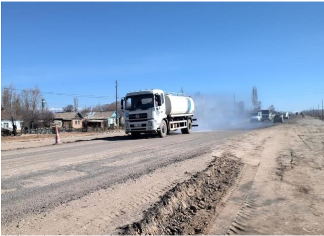
Фото 51. Гидроорошение участков дороги с км.182+860-км.215,8.
