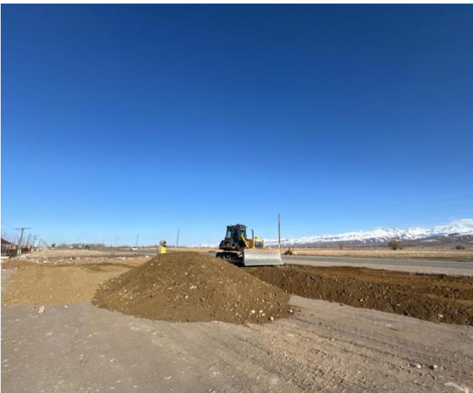
Фото 3. Участок 2. Земляные работы по устройству насыпи 197+400-198+200 LHS
