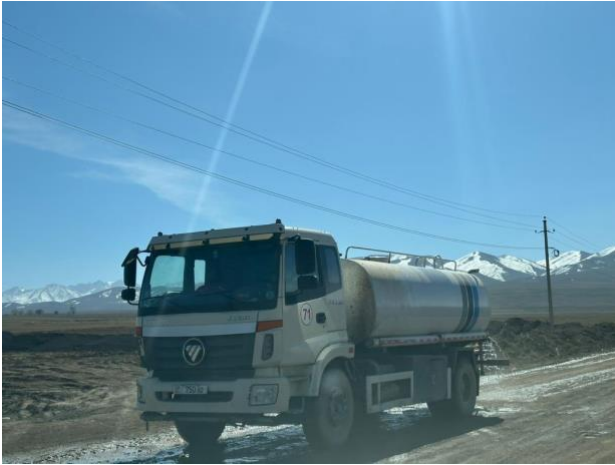
Фото 49. гидроорошение подъездной дороги к карьеру на км 194.
