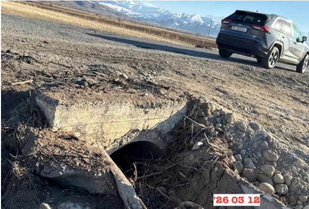
Фото 25. Водопрopusкная труба, на км.188+400 LHS, выход
