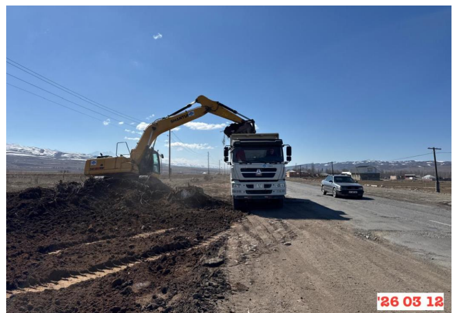
Фото 6. Расчистка и корчевание, км 198+400 LHS
