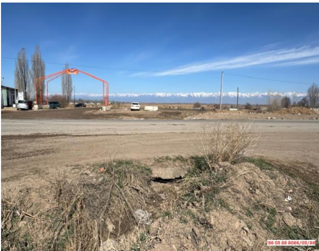
Фото 27. Водопрopusкная труба, на км.200+ RHS. вход
