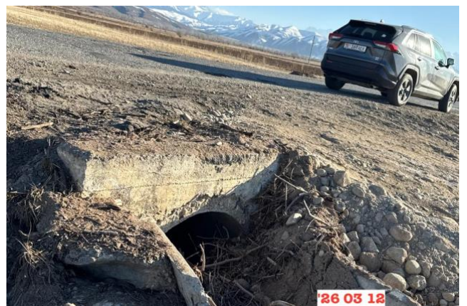
Фото 24. Водопрпускная труба, на км.188+400 LHS, выход
