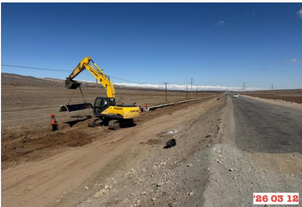
Фото 9. Установка лотков, км 187+460LHS
