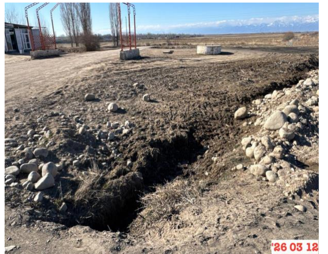
Фото 28. Водопрopusкная труба, на км.200+ RHS. Выход
