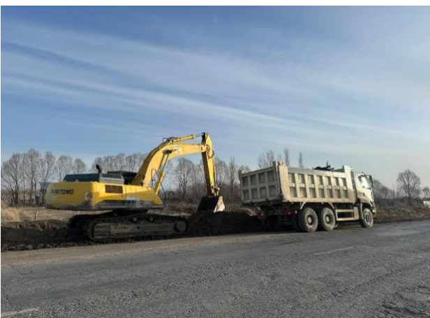
Фото 5. Расчистка и корчевание, км 204+880 LHS
