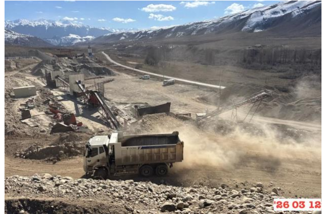
Фото 56. Производственная база, км 202+220 RHS, отсутствие гидроорошения внутрипроизводственных дорог.
