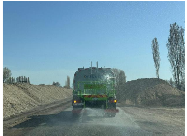
Фото 52. Гидроорошение участков дороги с км.182+860-км.215,8.
