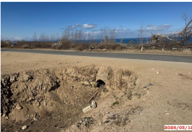
Фото 21. Селепропуск на км.151+260 RHS. ВХОД
