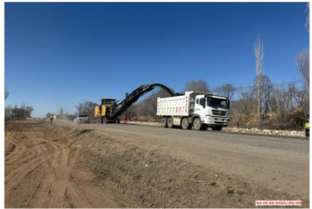
Фото 14. Фрезеровка асфальта км.203+300
