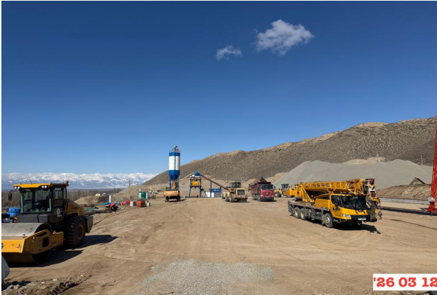
Фото 43. Участок 2, производственная база, на км.202+220
