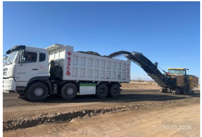
Фото 12. Фрезеровка асфальта, км 200
