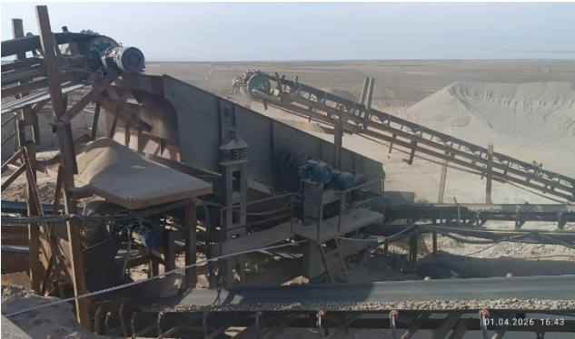
Фото 1. Работа ДСУ на производственной базе на км 167+360
