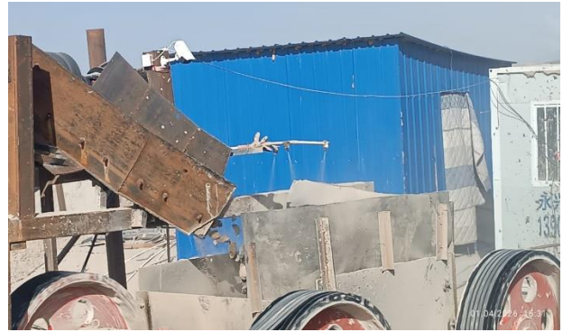
Фото 2. Система гидроорошения на ПГУ установлена в приемном бункере, а также на конвейерных линиях.
