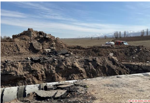
Фото 59. Складирование фрезерованного асфальта на строительных участках.
