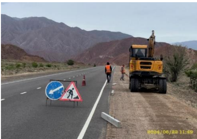
Фото 19. Лот 1. Устройство столбиков на обочине дороги 18+500 RHS Июнь 2024.
