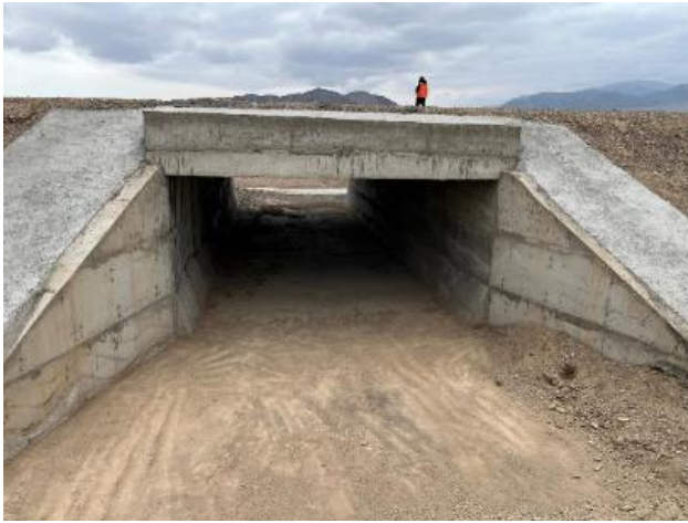
Фото 15. Лот 1, км 22+575, очистка водопропускной трубы. Апрель 2024.
