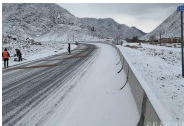
Фото 6. Подсыпка смеси для предотвращения гололеда, км.14+000. Январь 2024.
