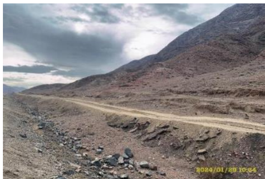
Фото 64. Обьездная дорога км.14+900 RHS. Январь
