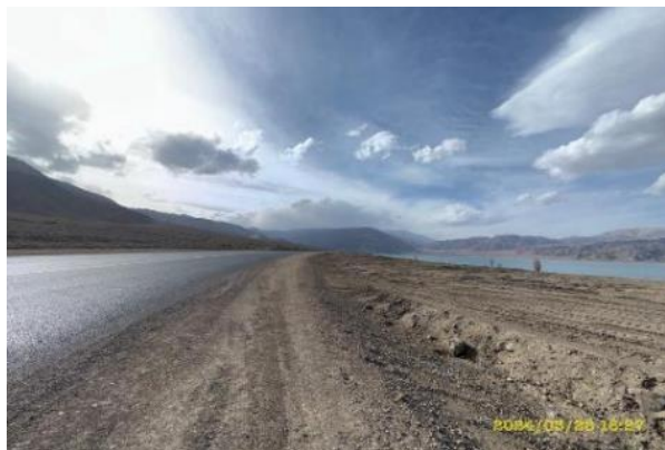
Фото 58. Лот 1. Произведена техническая рекультивация участка обьездной дороги на км.37. Март
