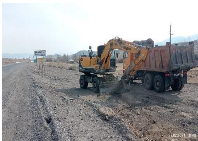
Фото 23. Санитарная очистка проектной дороги км 89+500. Февраль 2024.
