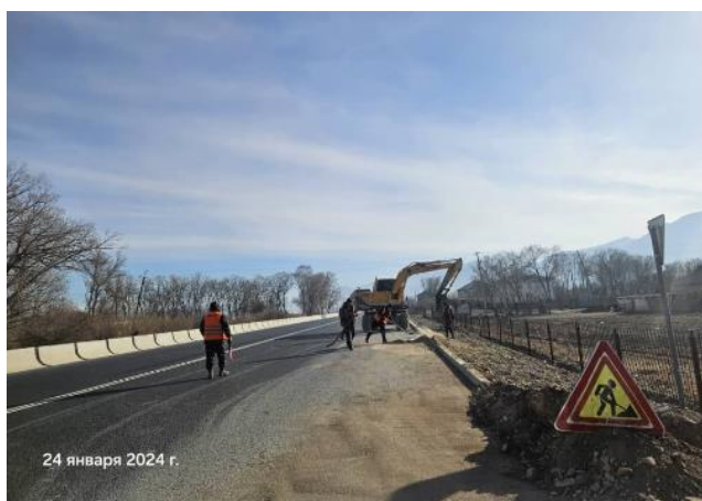
Фото 22. Расчистка проезжей части от материалов, км 66+400. Январь 2024.
