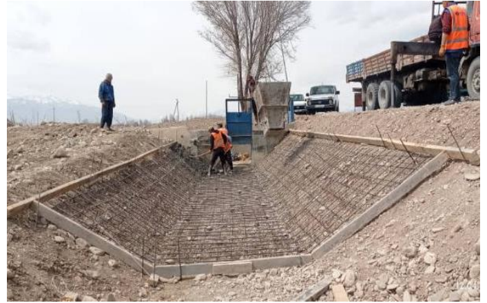
Фото 27. Заливка бетона для укрепления откоса км 64+860. Апрель 2024.
