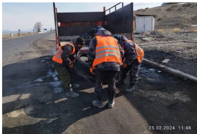
Фото 56. Лот 1. Расчистка проектной дороги.
