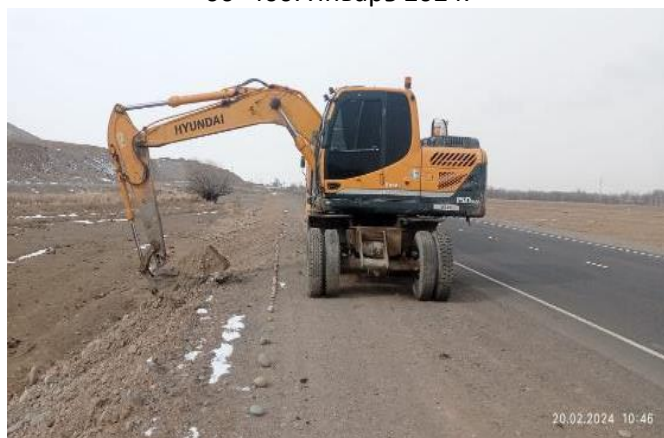
Фото 24. Срезка откосов на км. 80+600 LHS. Февраль 2024.
