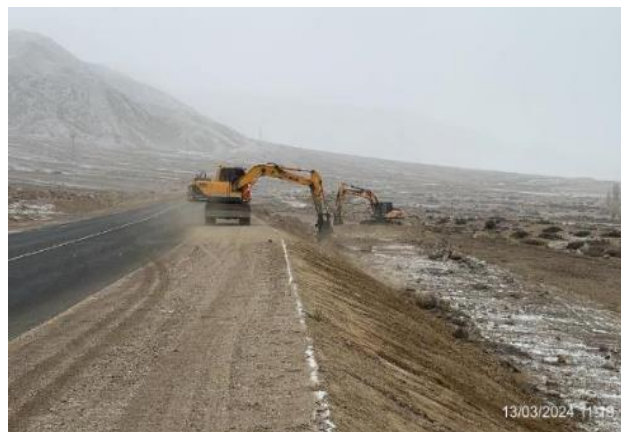
Фото 10. Срезка откосов 36+000-38+000 RHS. Март 2024.
