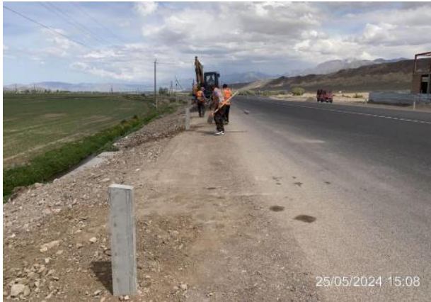
Фото 30. Установка сигнальных столбиков км 73+000-76+000 BS, Май 2024.
