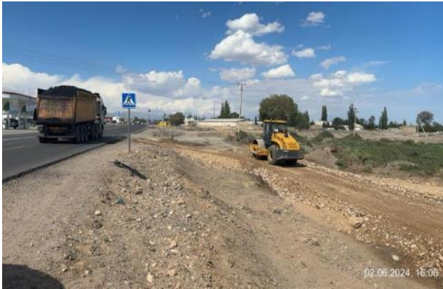
Фото 21. Подготовка насыпи для тротуара км 0+600-0+750 LHS. Июнь 2024.
