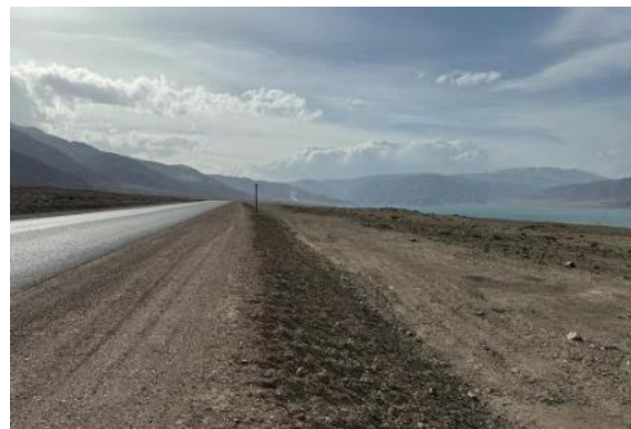
Фото 59. Лот 1. Произведена техническая рекультивация участка обьездной дороги на км.33. Март
