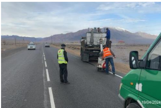
Фото 13. Лот 1. Нанесение дорожной разметки км 3-6. Апрель 2024
