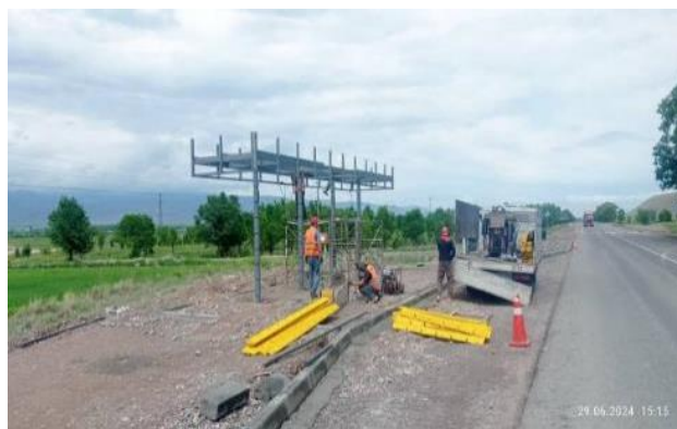
Фото 34. Установка каркаса кровли остановки 78+010 RHS.Июнь 2024.
