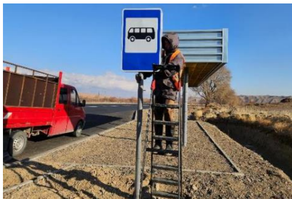
Фото 7. Лот 1. Установка постоянных дорожных знаков, км 11+400. Январь 2024.
