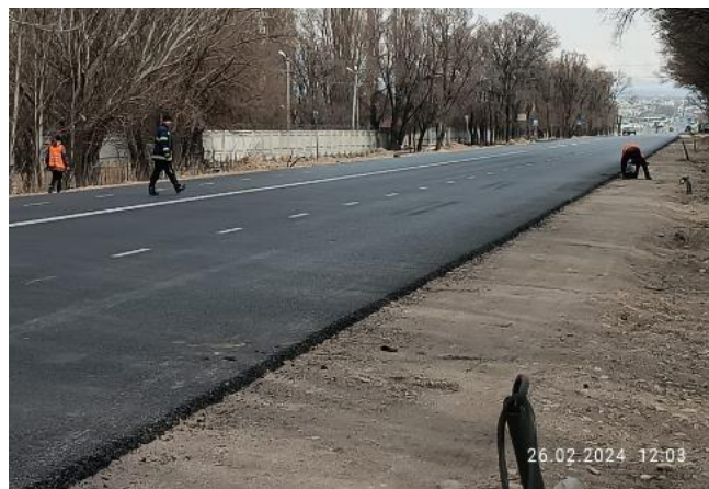
Фото 57. Лот 1. Расчистка проектной дороги
