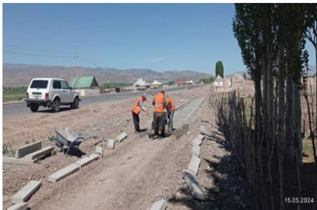
Фото 32. Установка бордюров для тротуара км 69+850-70+000 LHS. Май 2024.
