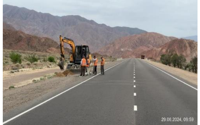
Фото 22. Установка сигнальных столбов на км 14+000-19+000 BS Июнь 2024.
