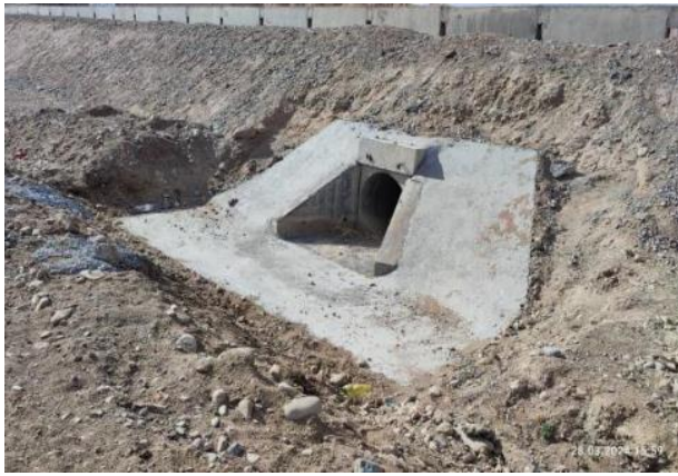
Фото 26. Строительство укрепления на входе трубы, км.88+692. Март 2024.
