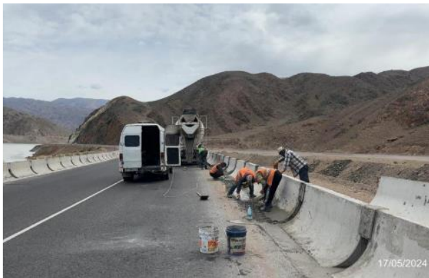
Фото 17 . Бетонирование стыков парапетов на 41+920-42+095 LHS. Май 2024.
