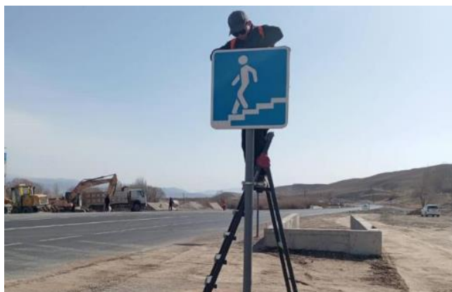
Фото 25. Установка дор знака км 86+410 LHS. Март 2024.
