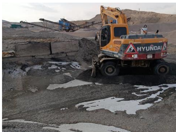
Фото 67. Лот 1. Территория производственной базы. Произведена очистка от мусора. Февраль
