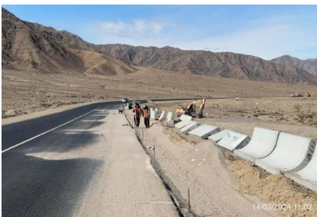
Фото 11. Устройство и планировка песчанной подушки 36+530-36+820 RHS. Март 2024.
