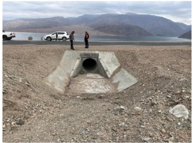
Фото 16. Очистка водопропускной трубы, км 33+869, Апрель 2024
