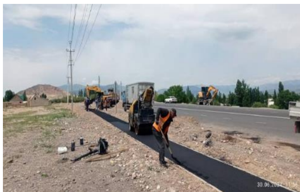
Фото 35. Укладка а/б покрытия тротуара на км 86+570-87+000 LHS. Июнь 2024.
