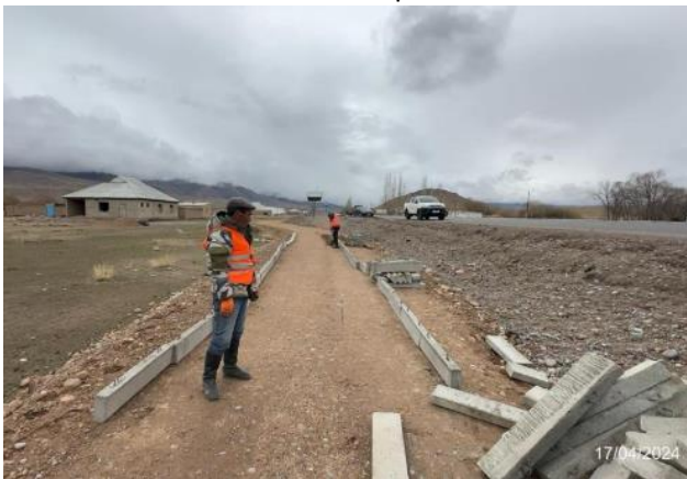
Фото 28. Установка бордюров для тротуаров, км. 86-87. Апрель 2024.
