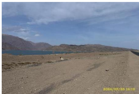
Фото 60. Лот 1. Произведена техническая рекультивация участка обьездной дороги на км.34+646. Март
