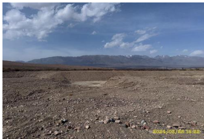
Фото 53. Лот 1. Карьер км. 16+600 откосы борта карьера приведены в безопасное состояние. Март
