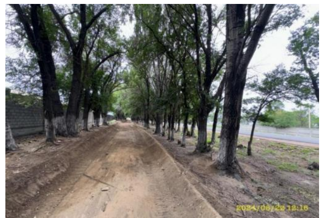
Фото 20. Лот 1. Тротуар. Земляные работы, км. 2+500 LHS. Июнь 2024.
