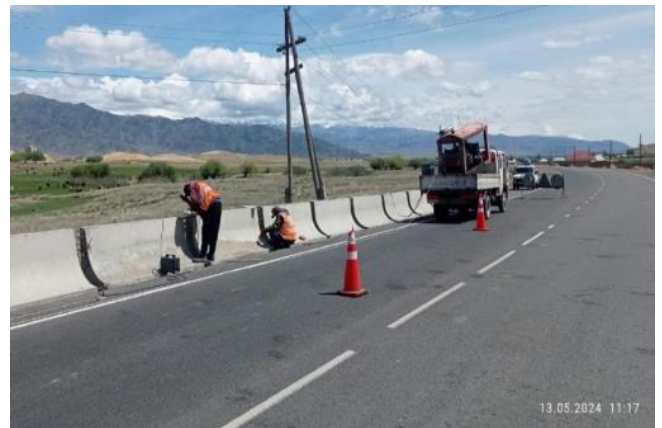
Фото 31. Сварочное соединение парапетов км 88+860-88+790 RHS. Май 2024.
