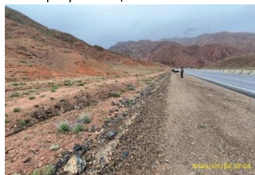
Фото 65. Обьездная дорога км.14+900 RHS. Июнь
