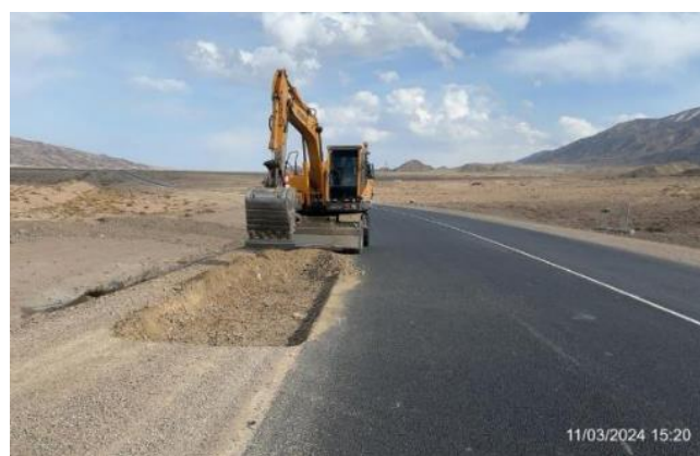
Фото 12. Устройство основания парапетов 34+680-34+905 RHS. Март 2024.
