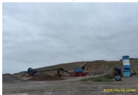
Фото 61. Лот 2. Производственная база ДСУ. Июнь
