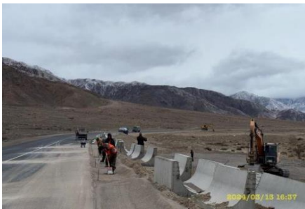
Фото 9. Лот 1. Установка парапетов на км. 37+540. Март 2024.
