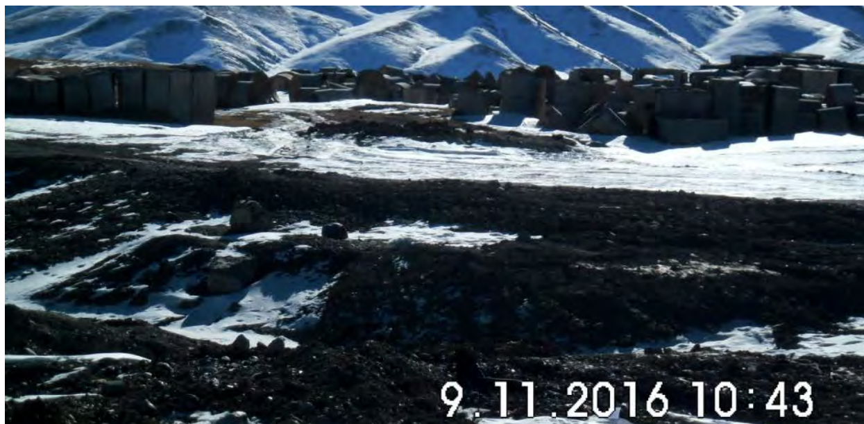
Рисунок 4: Целые звенья труб и неиспользованные готовые бетонные изделия предеаны МТид. Поворот на лагерь на км 501
