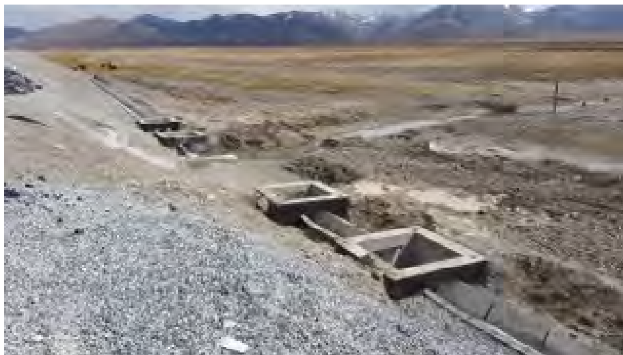
Рисунок 12: Идет строительство маслоуловительной системы (июнь 2016)
