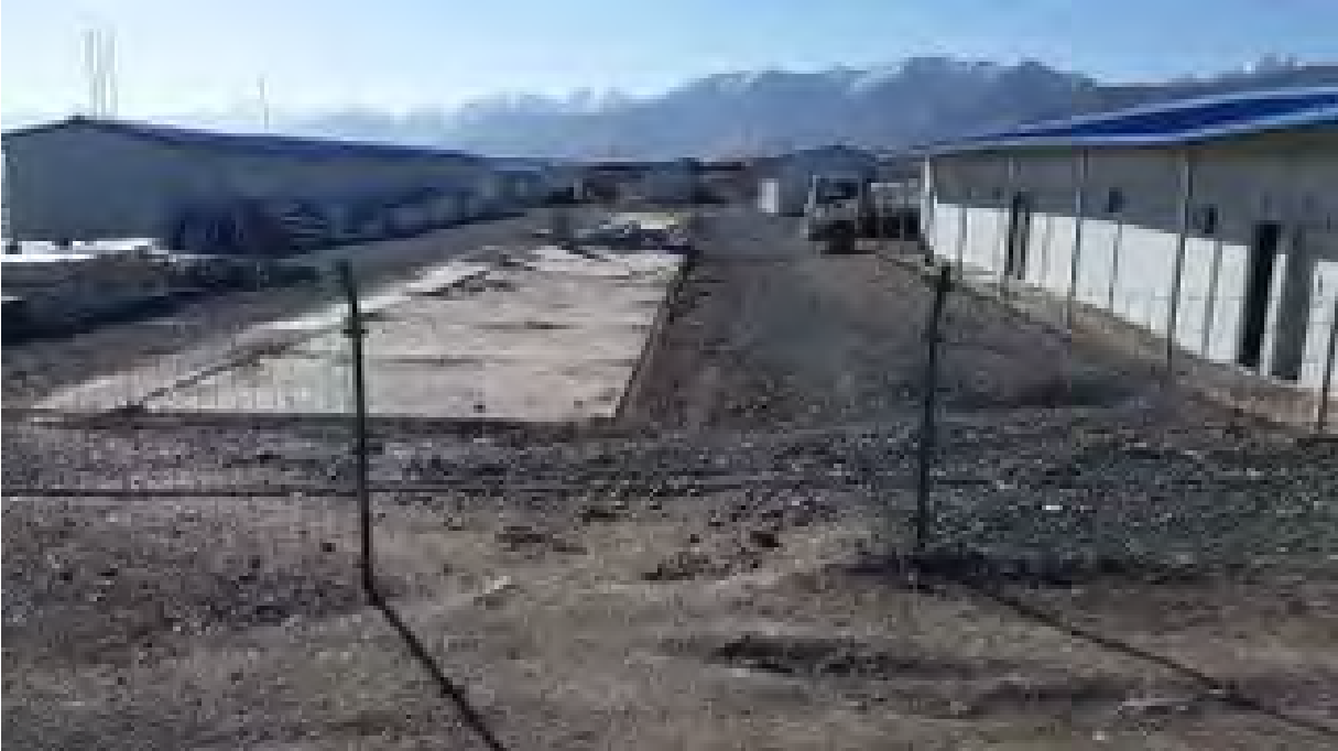
Рисунок 2: Демонтаж жилых помещений (23-сентября 2016)
