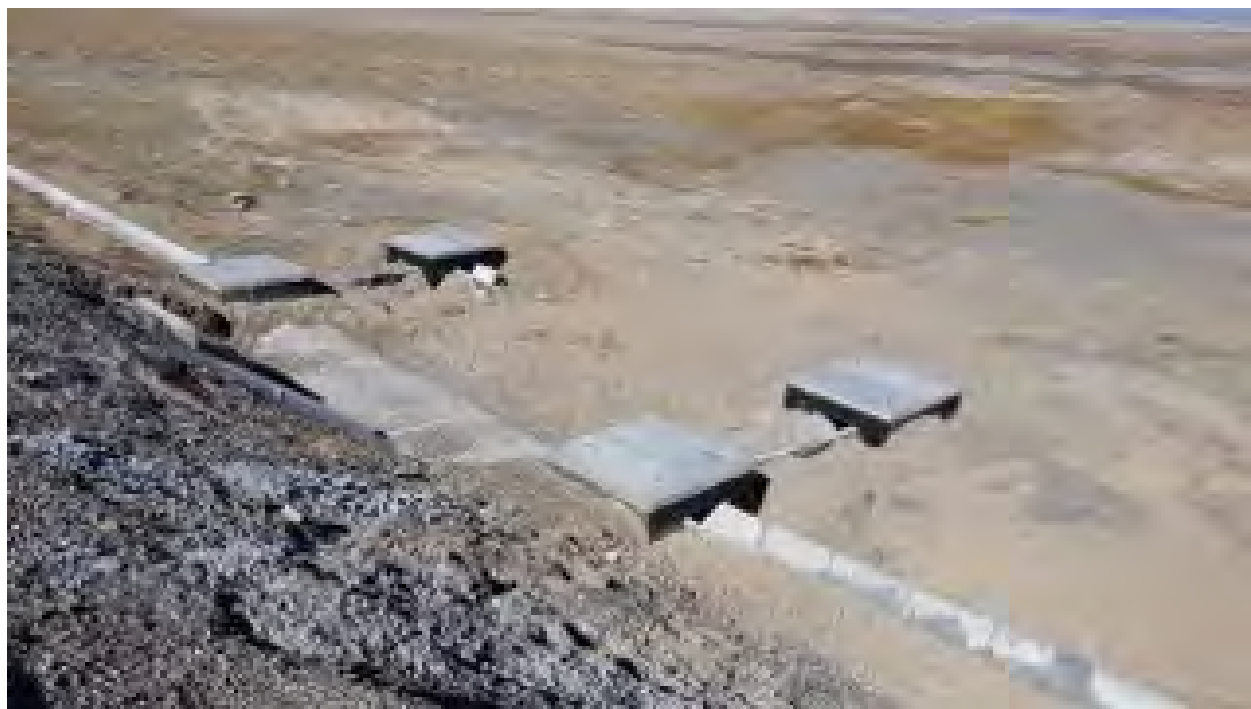
Рисунок 13: Завершено строительство маслоуловительной системы (сентябрь 2016)
