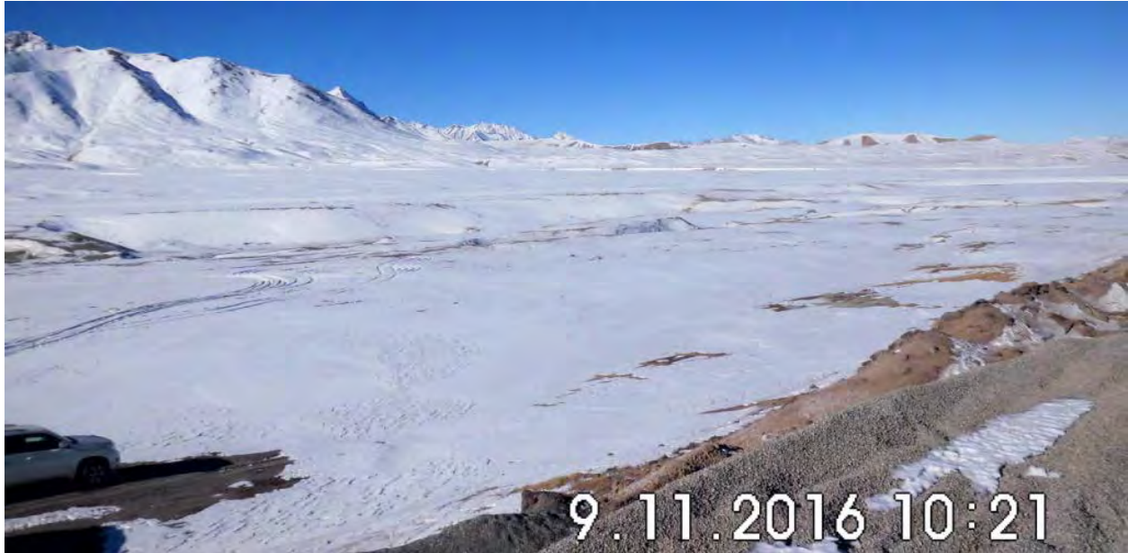
Рисунок 6: Производственный участок демонтирован. Вид полигона изготовления готовых бетонных изделий.
