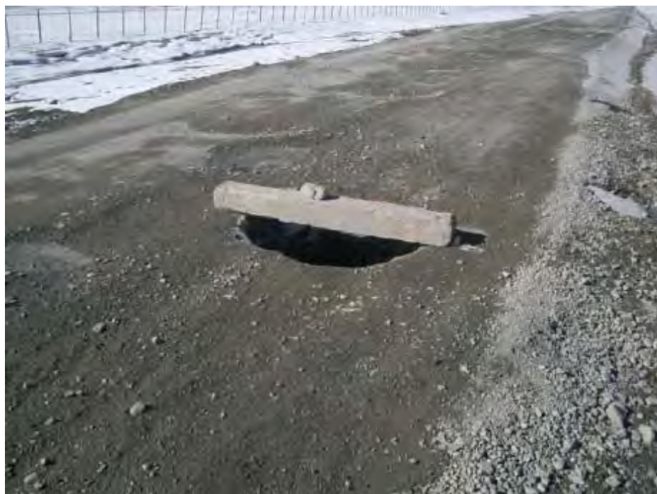
Кульверт (водопропускная труба) прямоугольного сечения, не имеющая крышки (16 октября 2009 г.)
