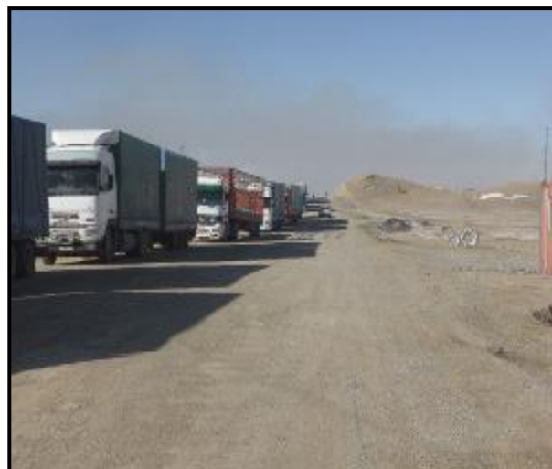
Фотография 6 Вид на таможенный пост «Торугарт» вагоны и грузовики, стоящие в очереди с северо-запада (вид юго-восток)
