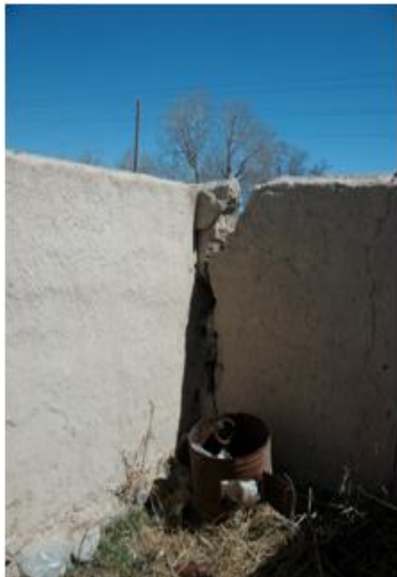
Фотографии сделанные в 2010 г. до начала строительных работ
