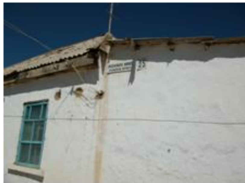
Фотографии сделанные в 2010 г. до начала строительных работ
