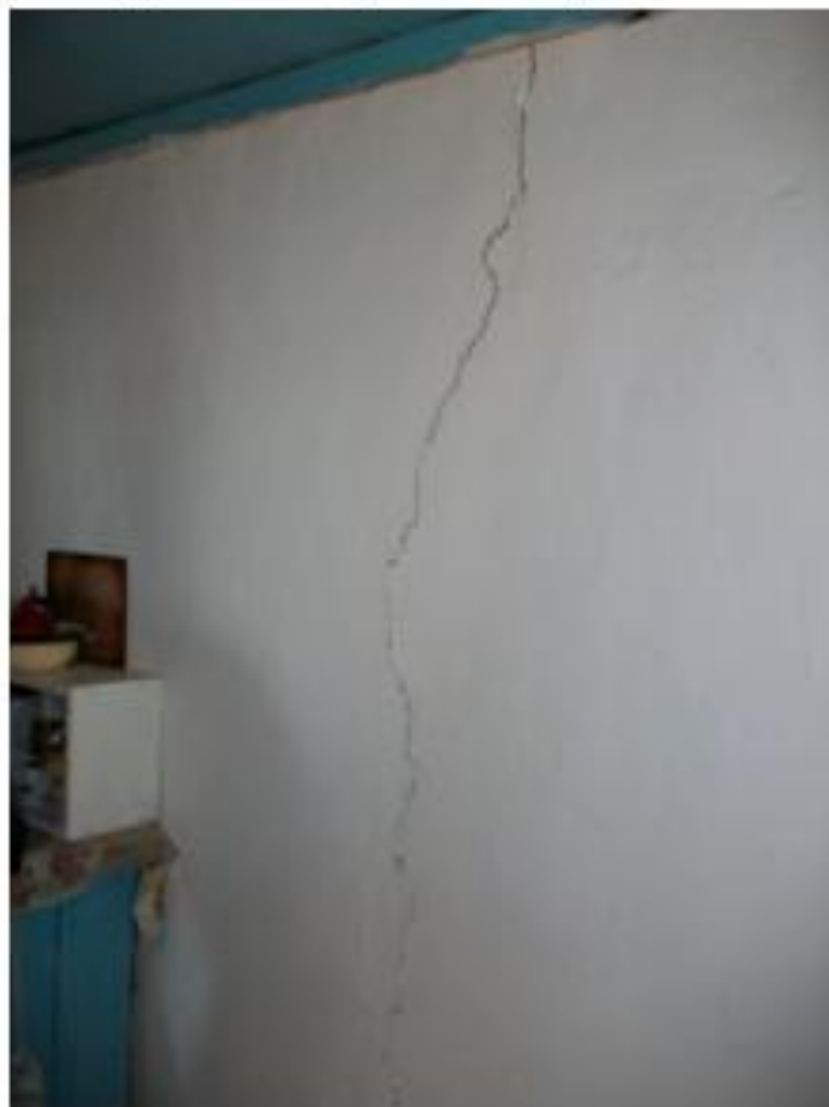
Фотографии сделанные в 2010 г. до начала строительных работ
