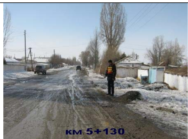
Рис. 39 и 40 Слева и справа от дороги на том же пикете видны состояния тротуаров, заваленные сугробами и местами разрушенные. Глинобитный дувал слева находится на расстоянии 2 м от края дороги.
