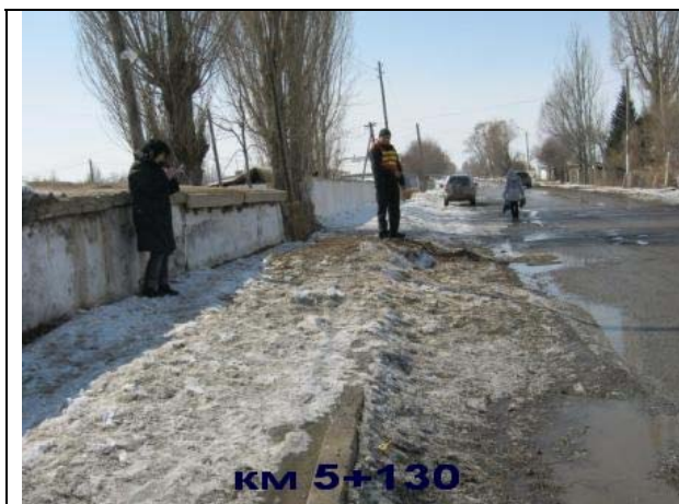
Рис. 39 и 40 Слева и справа от дороги на том же пикете видны состояния тротуаров, заваленные сугробами и местами разрушенные. Глинобитный дувал слева находится на расстоянии 2 м от края дороги.
