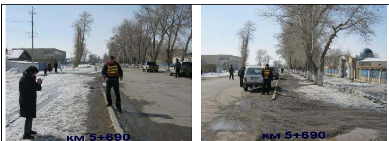
Рис. 49 и 50 Слева от края дороги до ограды и жилых зданий расстояние от 5 до 8 м. Справа от края дороги ситуация такая же. Слева и справа видны бордюры, ряды зеленых насаждений, водосливные кюветы и широкие тротуары
