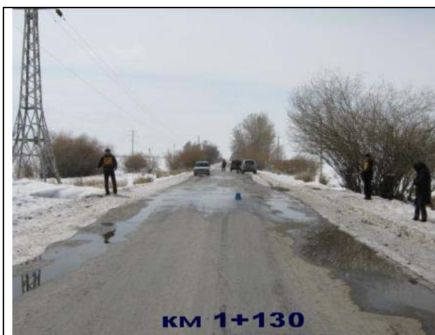
Рис. 13 и 14 Древесные насаждения вдоль дороги. На пикете справа отдельно стоящий кустарник на расстоянии около 1 м от края дороги. Опора высоковольтной ЛЭП слева на расстоянии 10 м от края дороги
