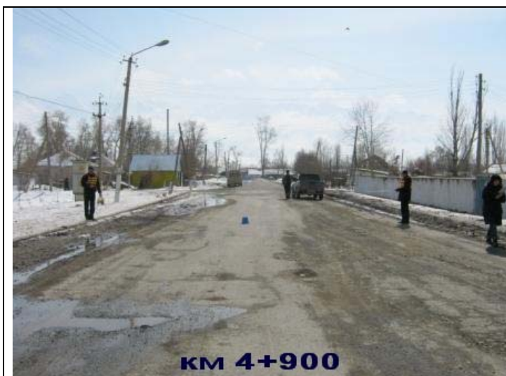
Рис. 31 Ширина проезжей части (10 м) ограничена с двух сторон бетонными бордюрами
