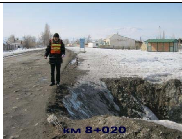
Рис. 76 и 77 На фотографии слева и справа показано пересечение дороги с дренажным каналом, где происходит некоторое сужение проезжей части дороги (до 8,5 м)
