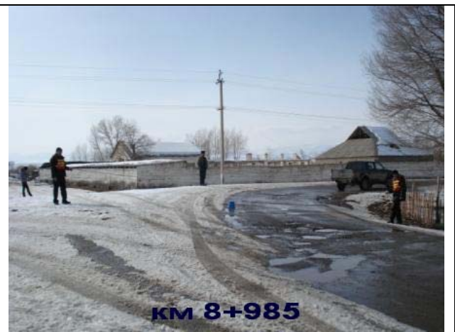
Рис. 92 и 93 Поворот с улицы Н.Жанузак вправо на улицу, ведущую к выезду из села на основную трассу. На фото показаны 10 м ширины дороги и ее ось (синий конус). Слева и справа от края дороги находятся тротуары и далее ограды жилых домов и административного здания (Районный отдел лесного хозяйства)
