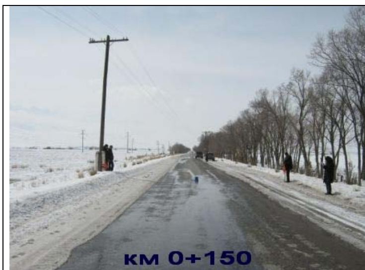
Рис. 2 Телеграфный столб слева на отметке 5 м от осевой линии
