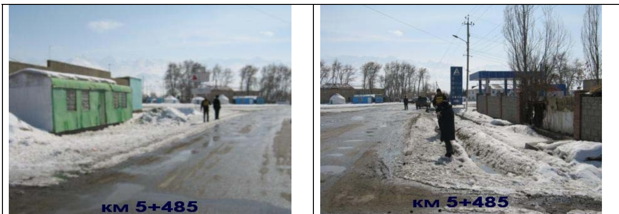
Рис. 45 и 46 Слева расположен старый строительный вагончик на расстоянии 4 м. Справа указано расположение ограды жилых домов от края дороги – около 5 м
