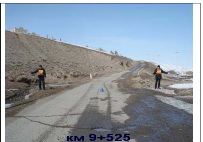
Рис. 96 Выезд из села. Справа от края дороги на расстоянии 4 м бетонная опора ЛЭП и в 5 м ограда хозяйственных помещений. Фото перед мостом и кладбищем. Рис. 97 Замеры на мосту. Ширина проезжей части 8 м.
