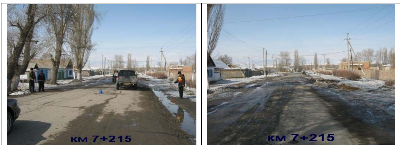
Рис. 66 и 67 Фотография вдоль улицы Мааткабыла Салымбекова. Слева видны деревья на расстоянии 2 м от края дороги и 7 м от дороги – дома. На правом снимке показана перспектива улицы.
