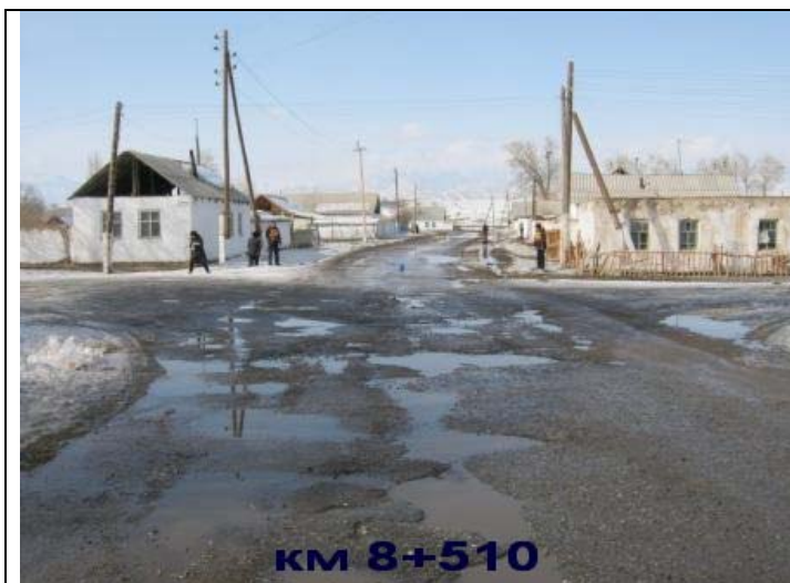
Рис. 82 Фото на пересечении улиц Босбая и Жаркынбаева Акмата. Показаны 10 м ширины дороги и ее ось (синий конус)
