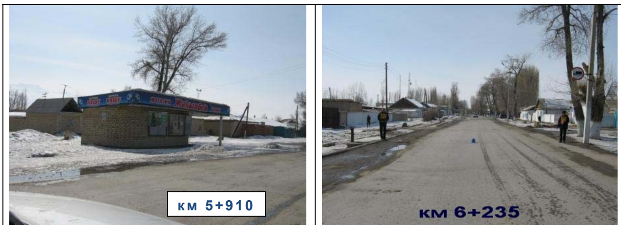
Рис. 51 На пикете км 5+910 расположен магазин-киоск капитальной постройки на расстоянии 3 м от края дороги слева. Рис. 52 Показана ось дороги (синий цилиндр) и ширина дороги. Слева от дороги на расстоянии 1 м расположен водопроводный колодец.
