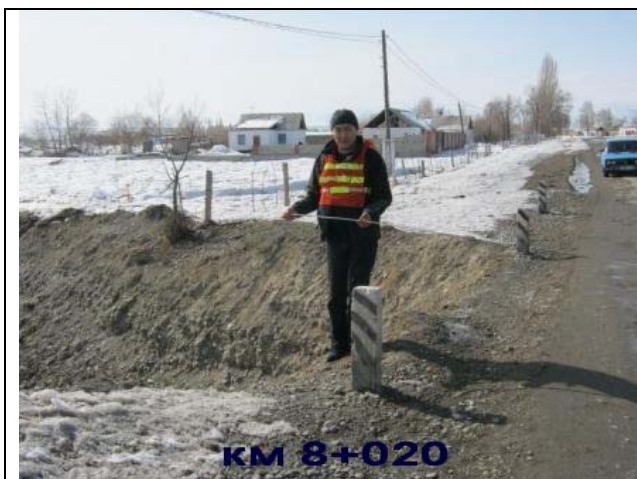
Рис. 76 и 77 На фотографии слева и справа показано пересечение дороги с дренажным каналом, где происходит некоторое сужение проезжей части дороги (до 8,5 м)
