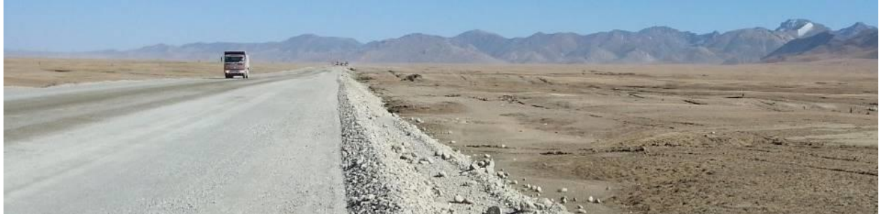
Рисунок 4: Вид основания проектной дороги после завершения работы (около 502 км)
