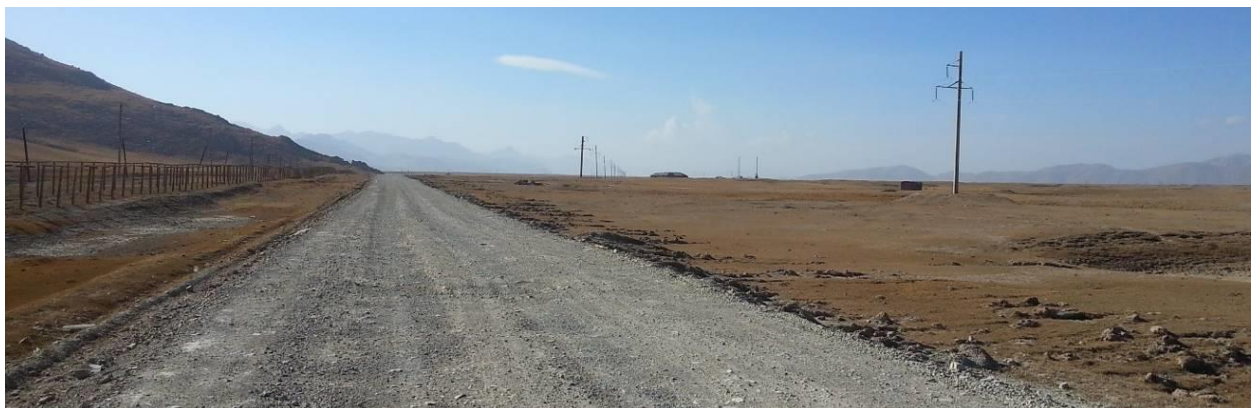
Рисунок 3: Вид проектной дороги до начала работы (около 520 км)
