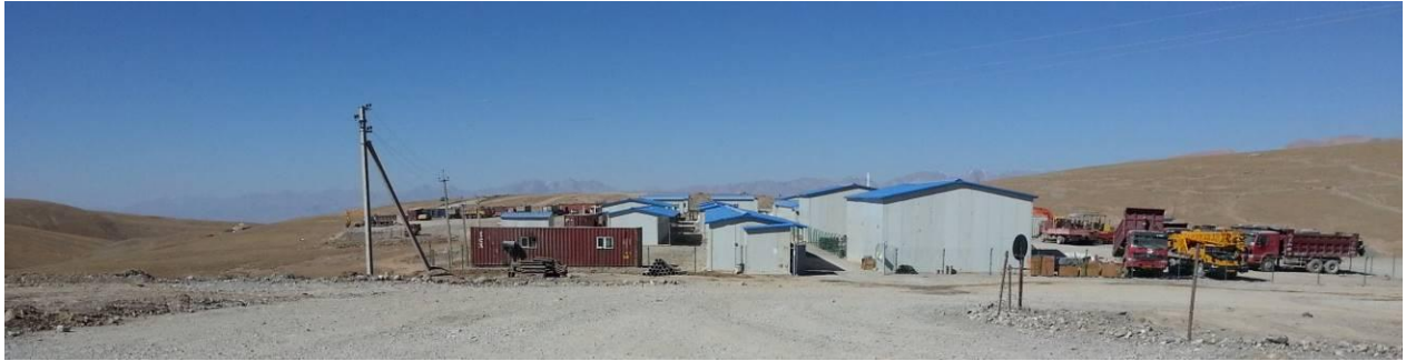
Рисунок 2: Строительный лагерь на 500 км - северная сторона от площадки технического обслуживания
