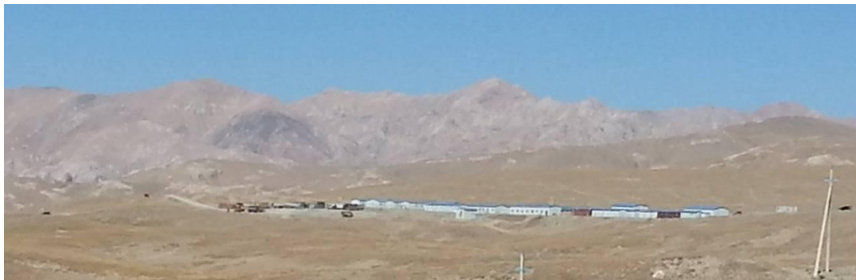
Рисунок 1: Строительный лагерь на 500 км – восточная сторона к объездной дороге АБЗ
