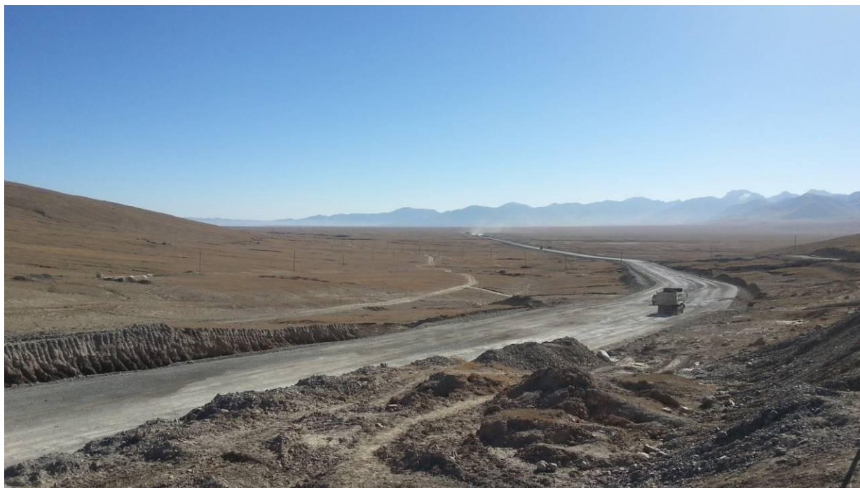
Рисунок 13: Вид в сторону КЖГЗ от лагеря на км500 (октябрь 2013)
