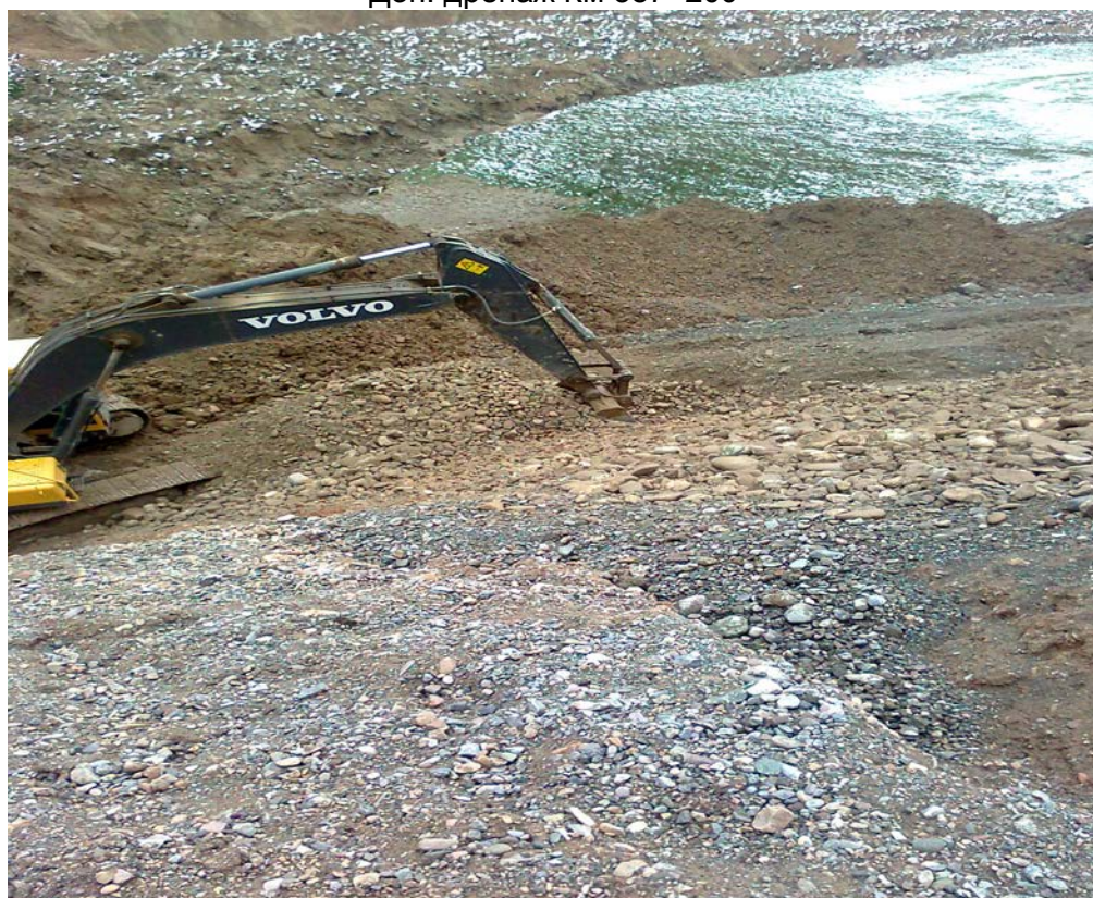
Км 368 укрепление откосов от эрозии
