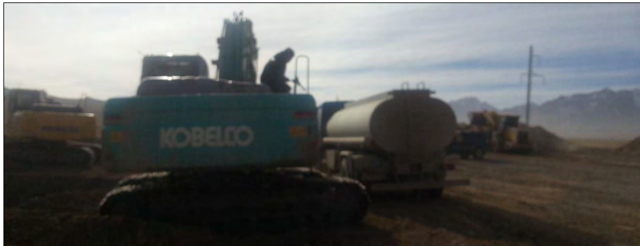
Рисунок 32: Дозаправка техники на участке работы специальным автозаправщиком
