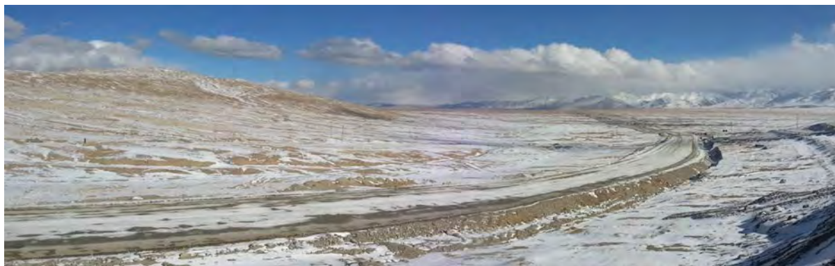
Рисунок 23: Вид из лагеря 29-октября 2014 – Конец строительного сезона 2014, Снег на земле
