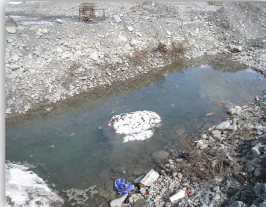
Рисунок 2. Водный резервуар для подавления пыли содержит мусор. (Группа 1)
