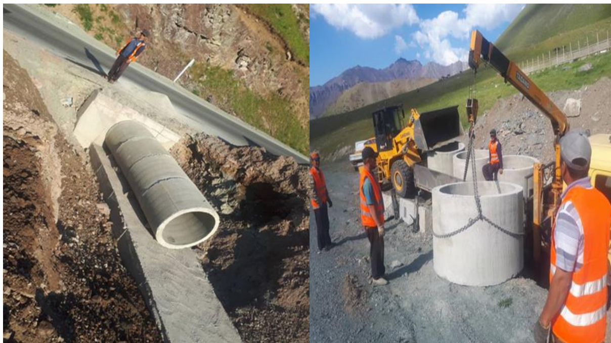
Замена водопропускной трубы
