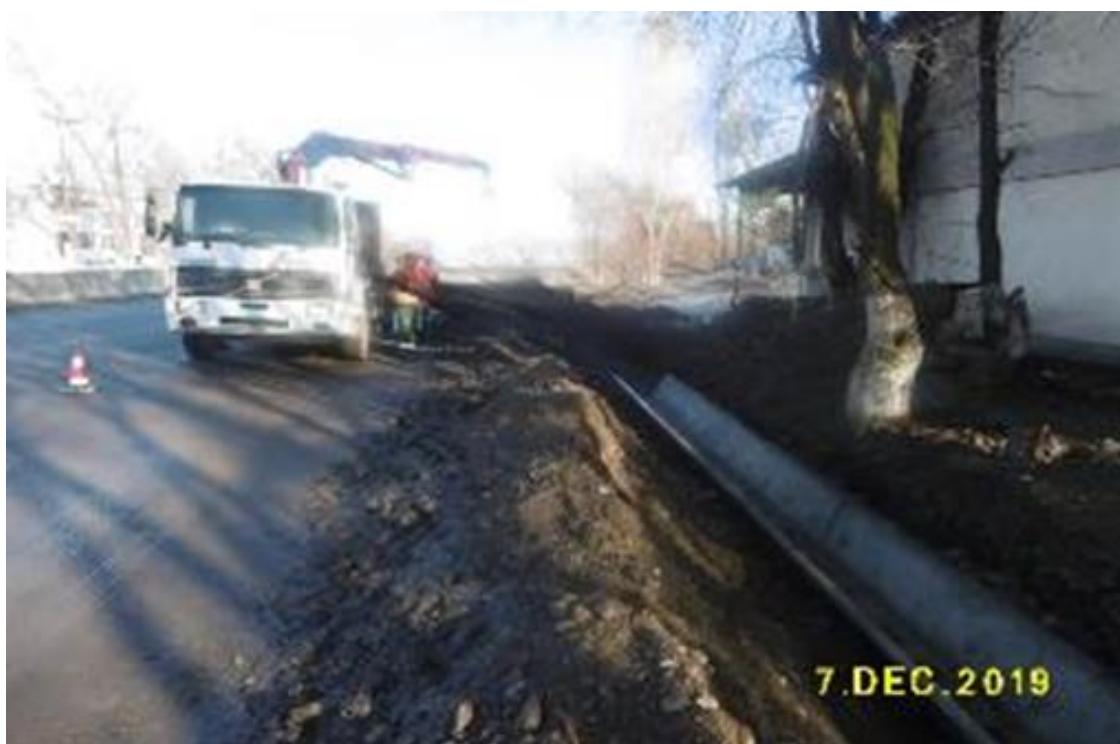
Установка ирригационных каналов
