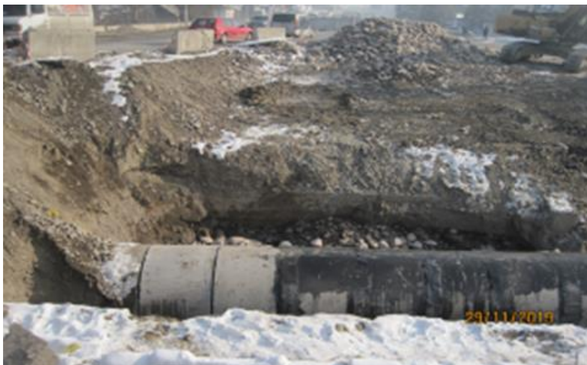
Перенос подземных линий и установка водопропускных труб
