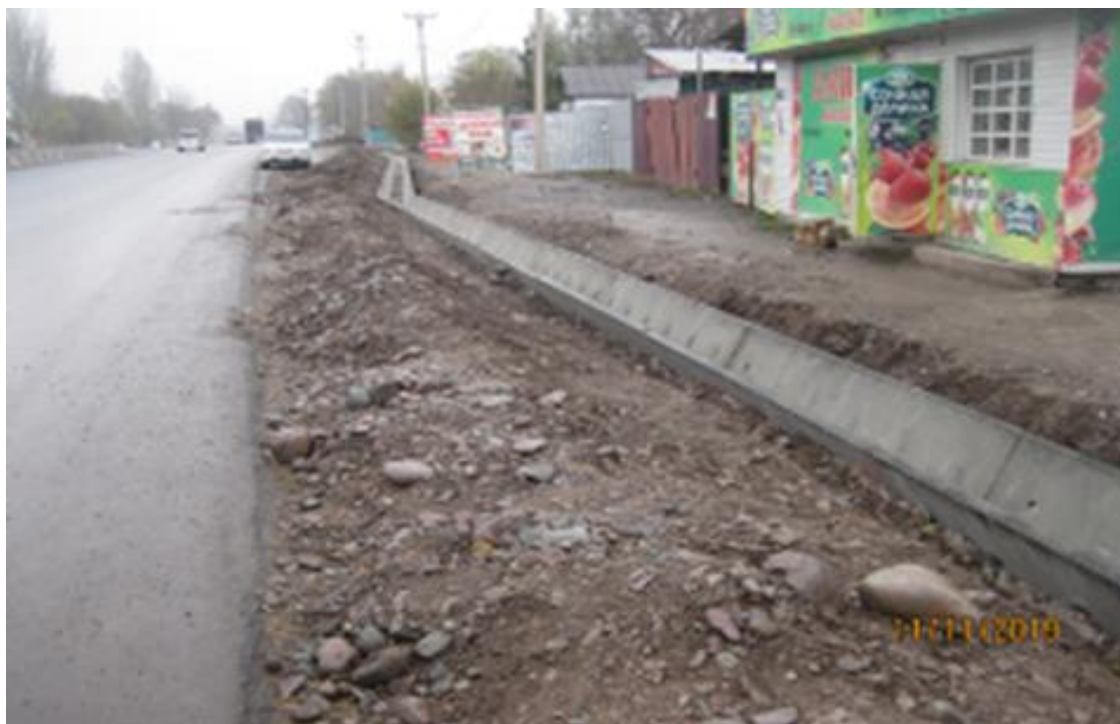
Установка ирригационных каналов
