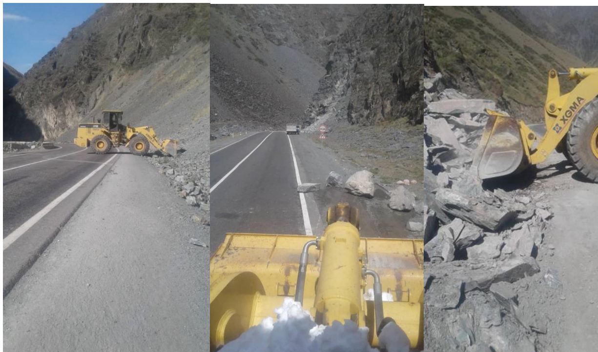
Очистка дорог от мусора и камнепадов
