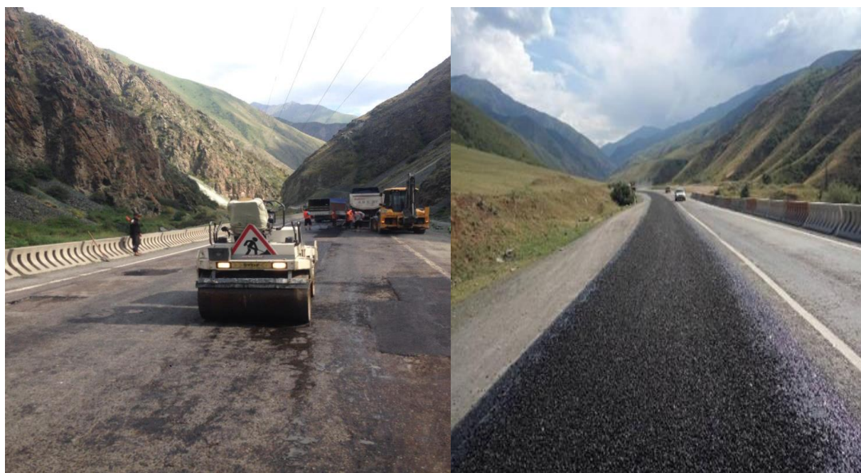
Текущий ремонт дорожной одежды
