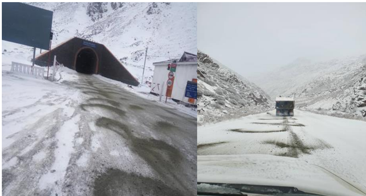
Подсыпка дороги песком
