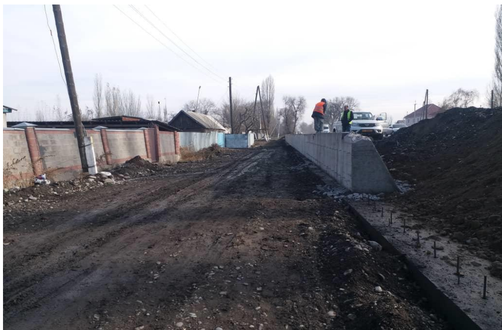
Фотография 3 Подпорная стена в селе Петровка (км 45+419)
