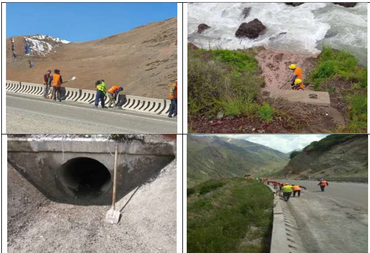
Рисунок 6. Очистка водопропускных труб, вдоль парапетов
