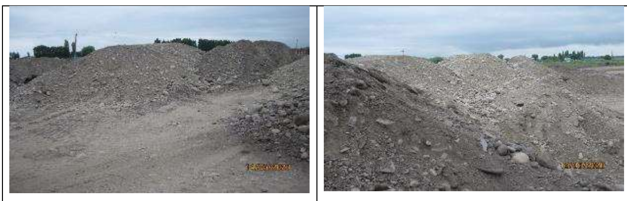
Рисунок 25 Складирование непригодного грунта для дальнейшего использования
