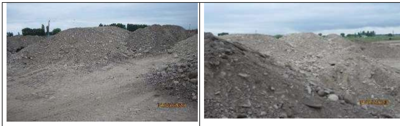
Рисунок 54 Сладирование непригодного грунта для дальнейшего использования
