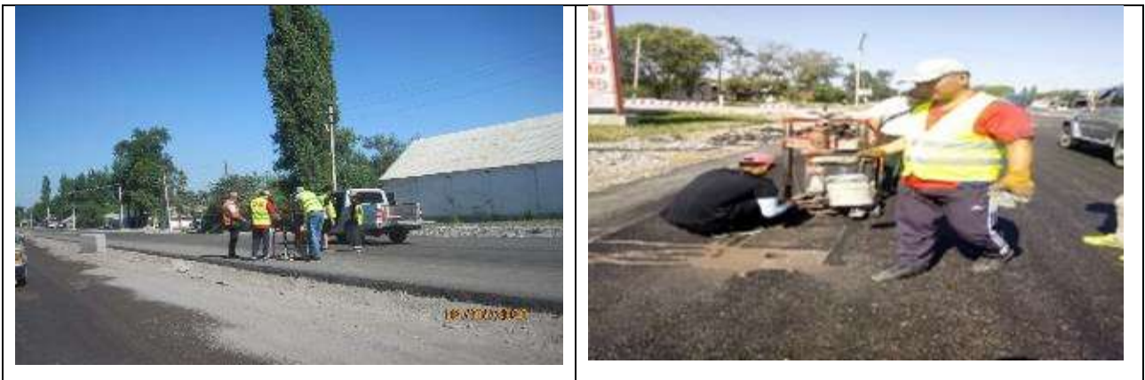
Рисунок 6 Проведение работ по отбору проб для контроля качества асфальта
