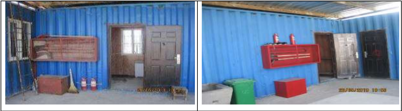
Рисунок 22 Противопожарные щиты на территории лагеря
