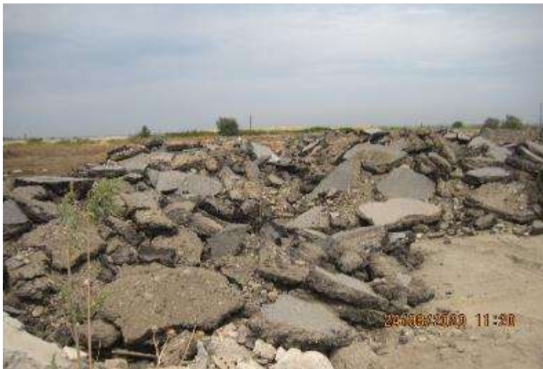
Рисунок 72 Складирование старого асфальта в отвалы
