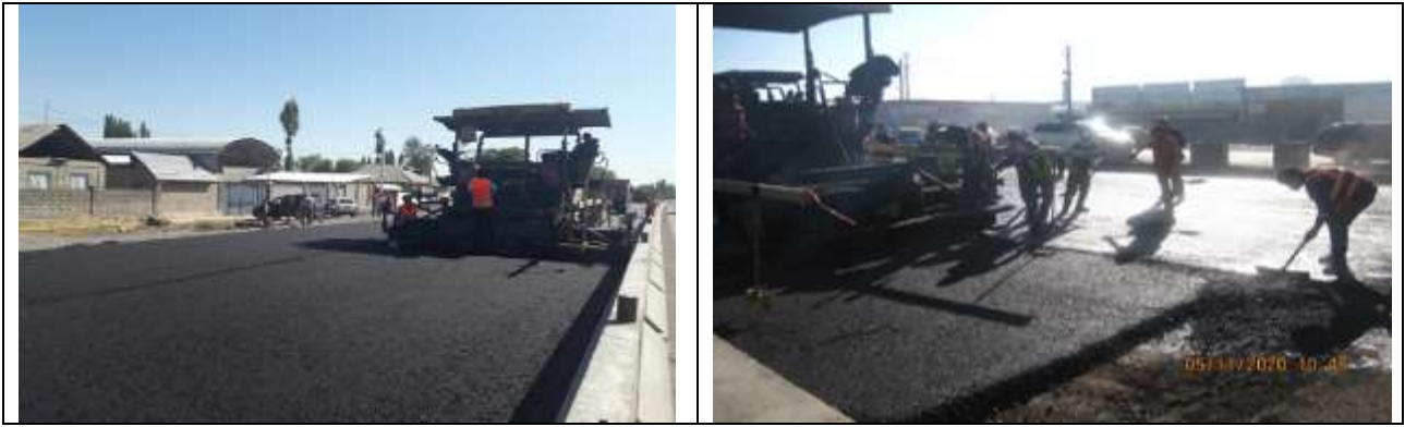
Рисунок 5 Укладка асфальта
