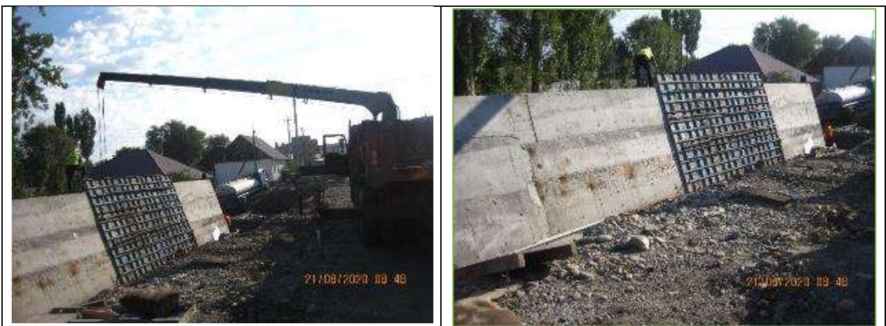
Рисунок 37 Строительство подпорной стены на км 26+500
