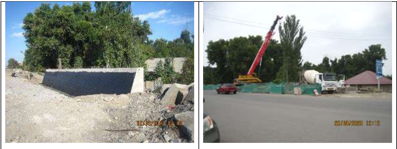
Рисунок 37 Строительство подпорной стены на км 26+500
