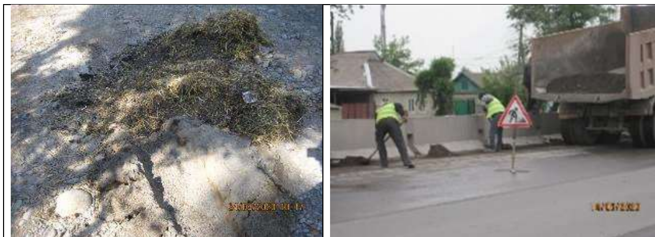
Рисунок 35 Асфальтные и растительные отходы на обочине дороги образованные при укреплении парапетов
