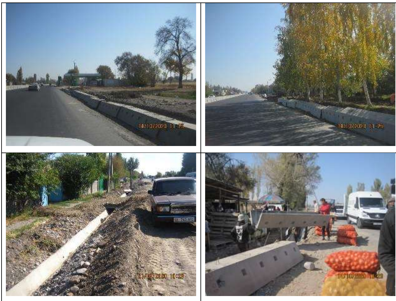
Рисунок 32 Установка водопропускных лотков
