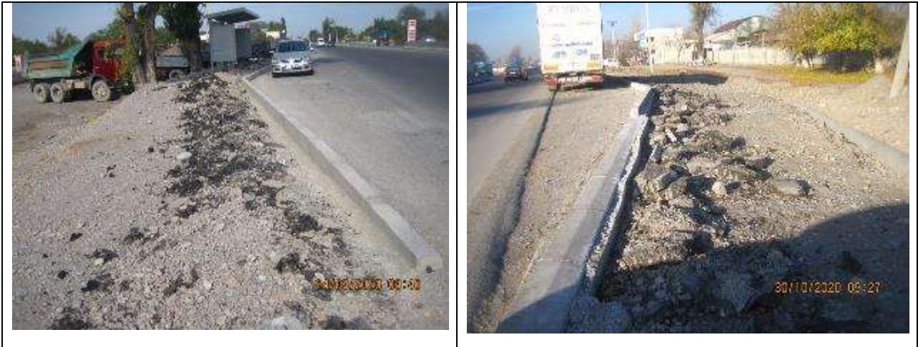
Рисунок 36 Очистка остановок от асфальтовых обрезков
