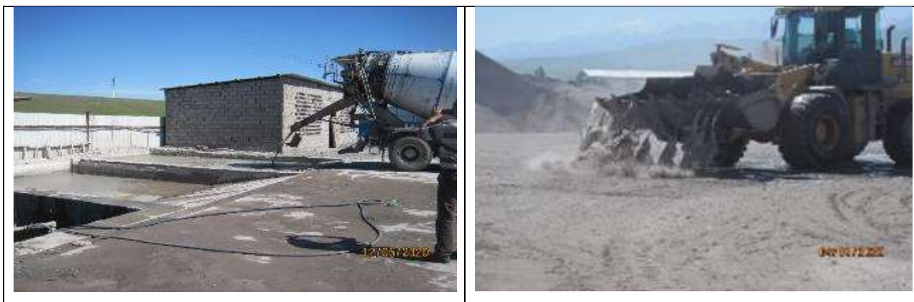
Рисунок 45 Промывка автобетоносмесителей. Орошение территории промплощадки промывочными водами
