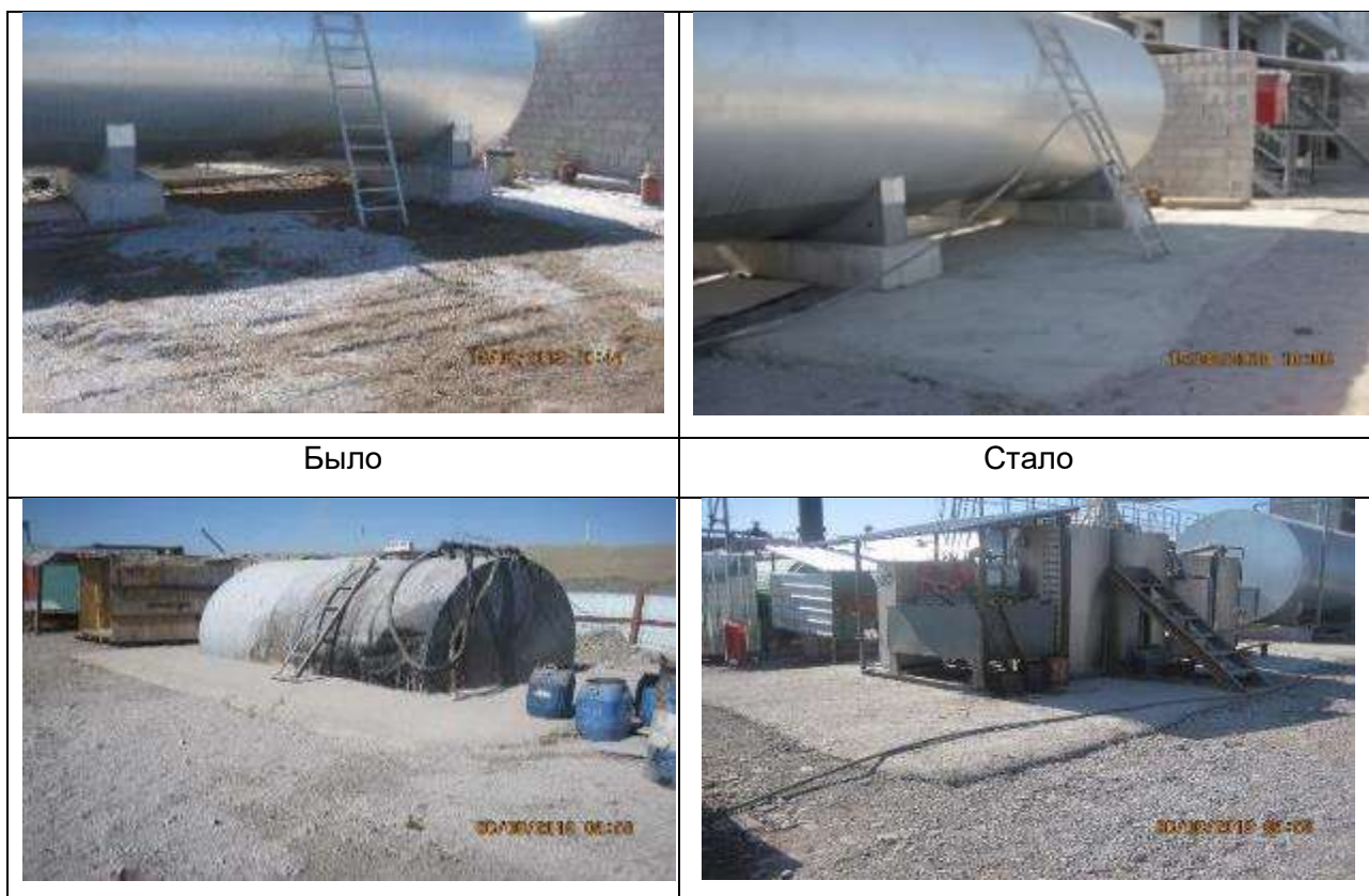
Рисунок 43 Непроницаемое защитное покрытие вокруг емкостей с химическими веществами
