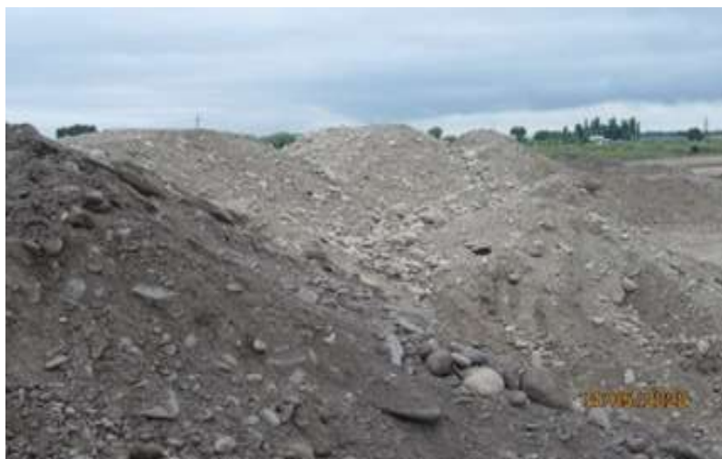
Рисунок 73 Складирование непригодного грунта в отвалы
