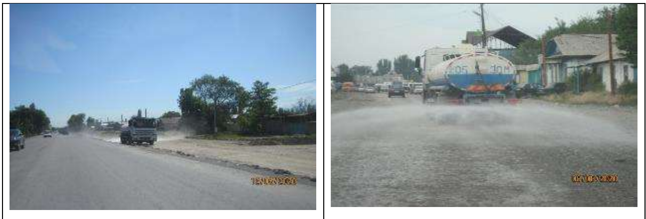
Рисунок 13 Орошение дороги для исключения пыления.
