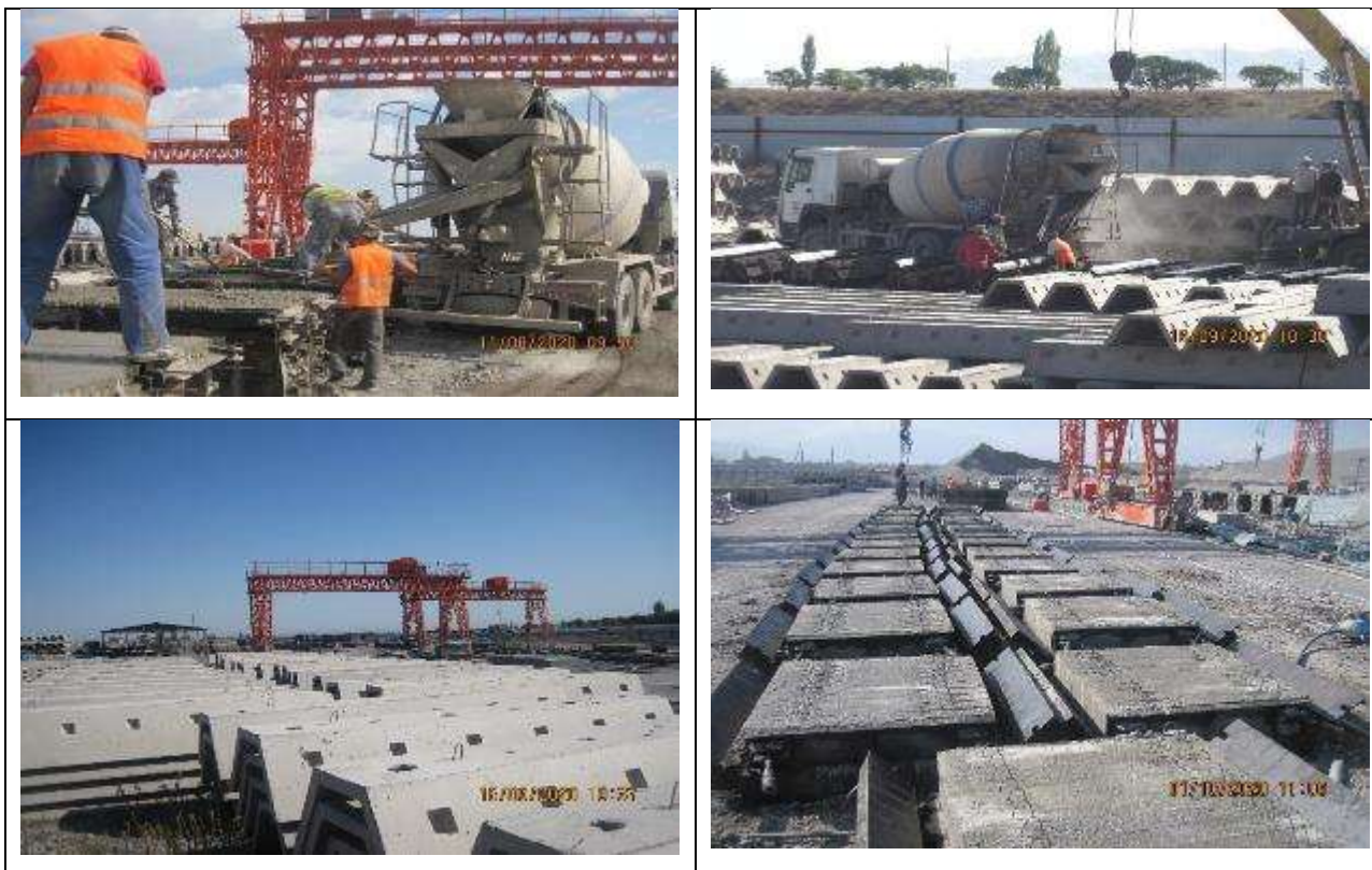
Рисунок 16 Изготовление железобетонных конструкций
