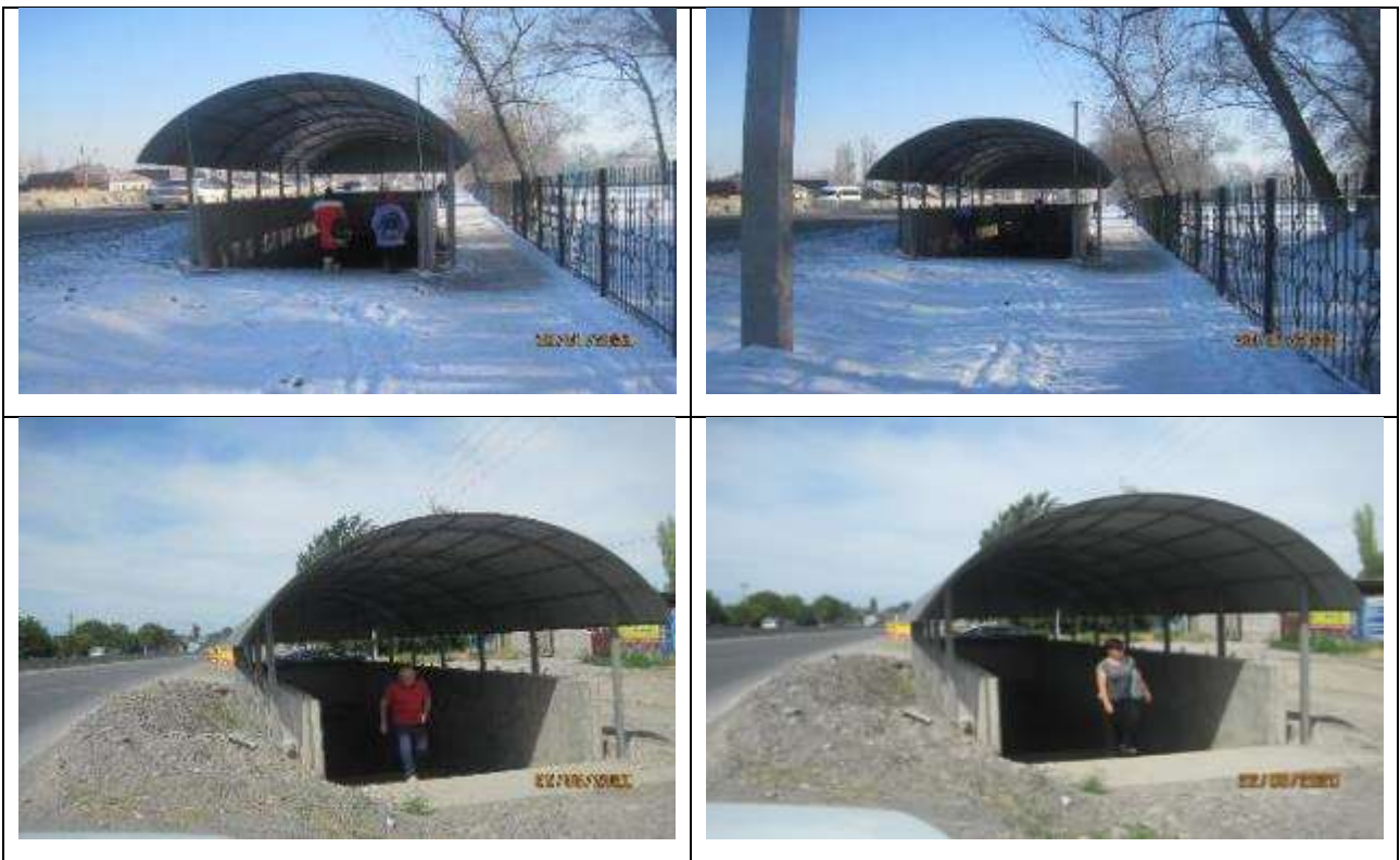
Рисунок 11 Строительство и реабилитация подземных переходов
