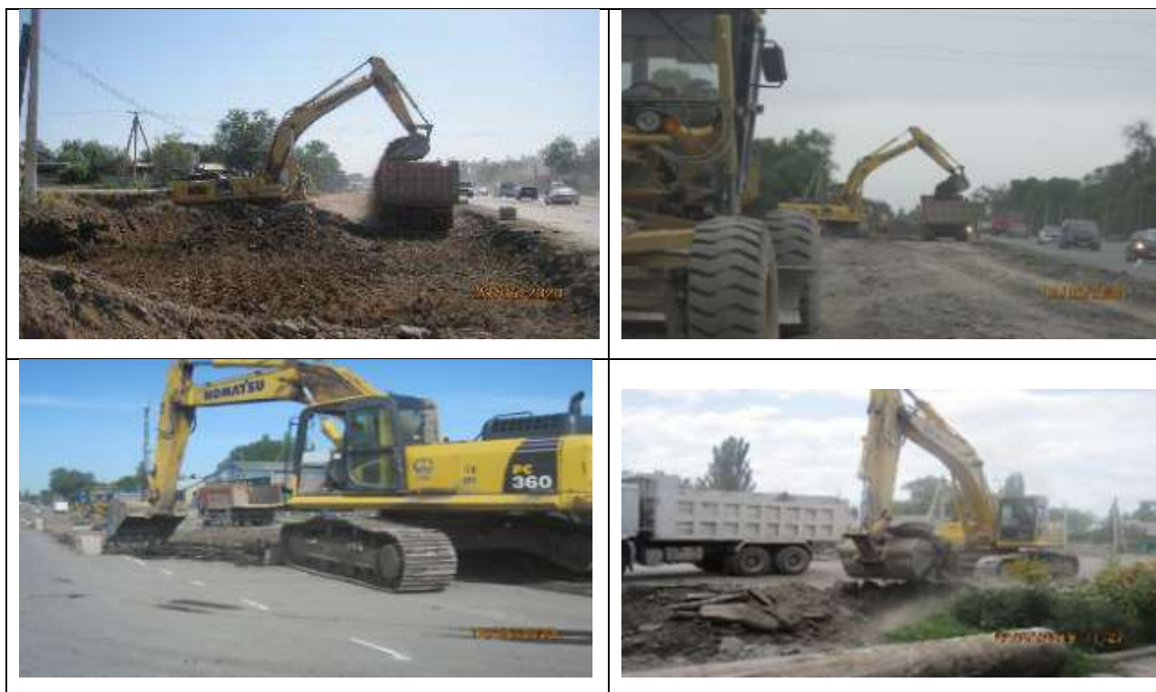
Рисунок 4 Снятие старого асфальта и непригодного грунта
