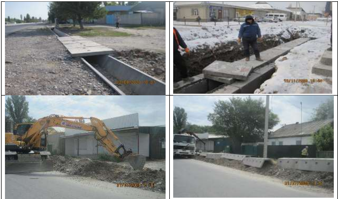
Рисунок 7 Установка придорожных водопропускных лотков и съездов на примыкающие к трассе улицы
