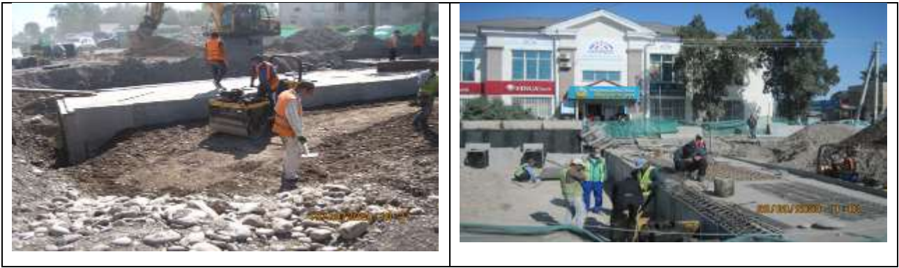
Рисунок 10 Строительство подземного перехода в с. Беловодское
