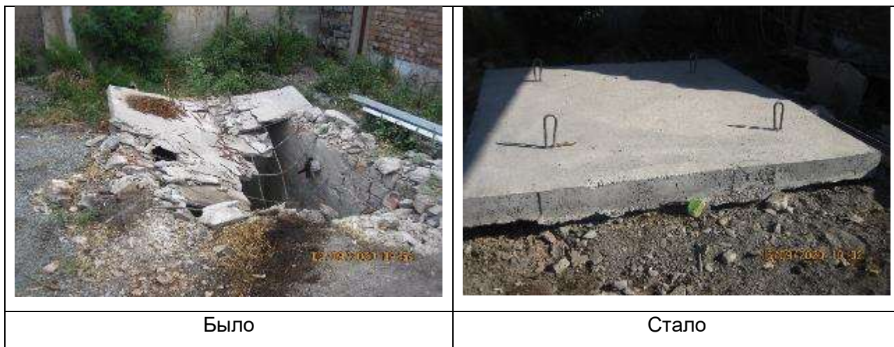
Рисунок 57 Плита перекрытия на сливной яме
