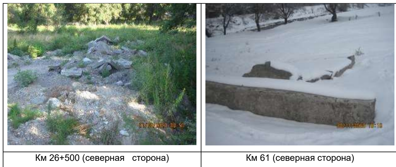
Рисунок 71 Железобетонные отходы на дороге
