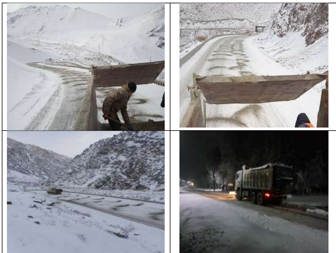
Рисунок 3. Подсыпка автодороги песком
