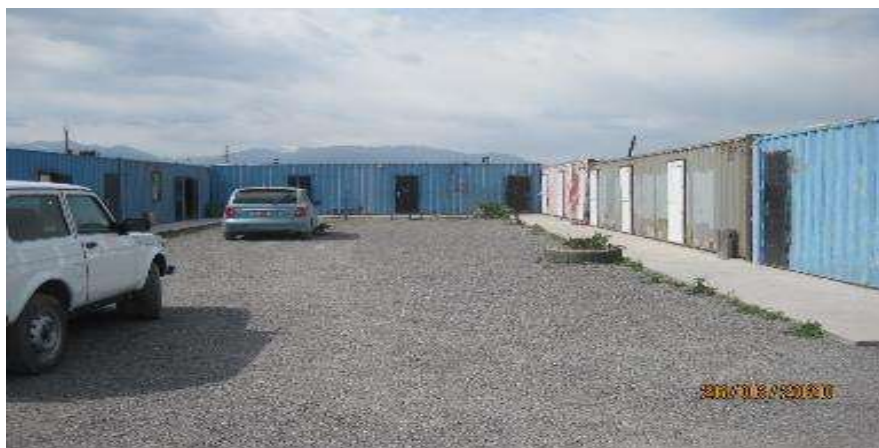
Рисунок 21 Лагерь проживания рабочих на территории промплощадки
