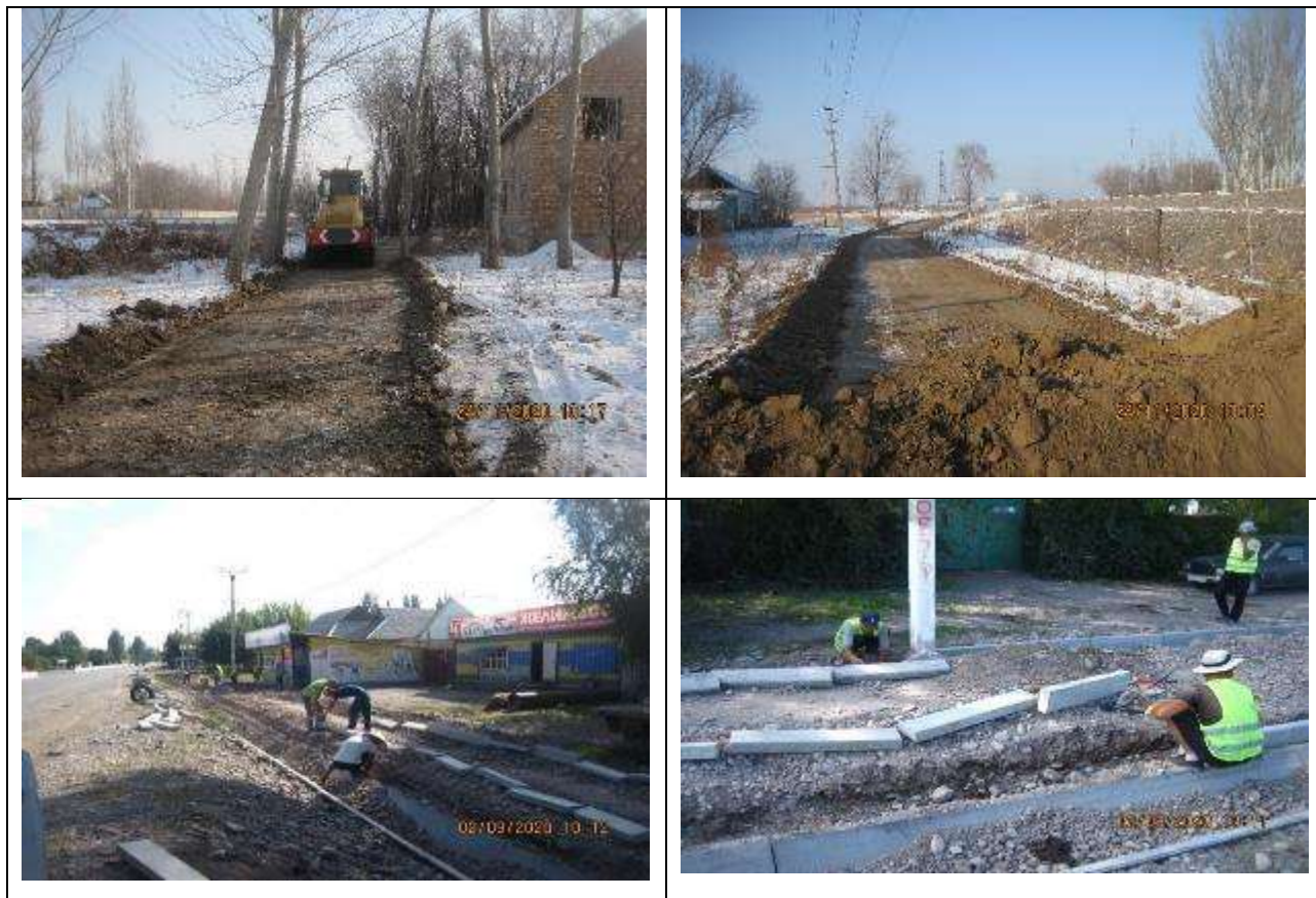
Рисунок 9 Строительство тротуаров на проектной дороге
