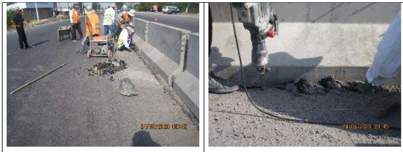
Рисунок 34 Очистка парапетов от накопившегося грунта
