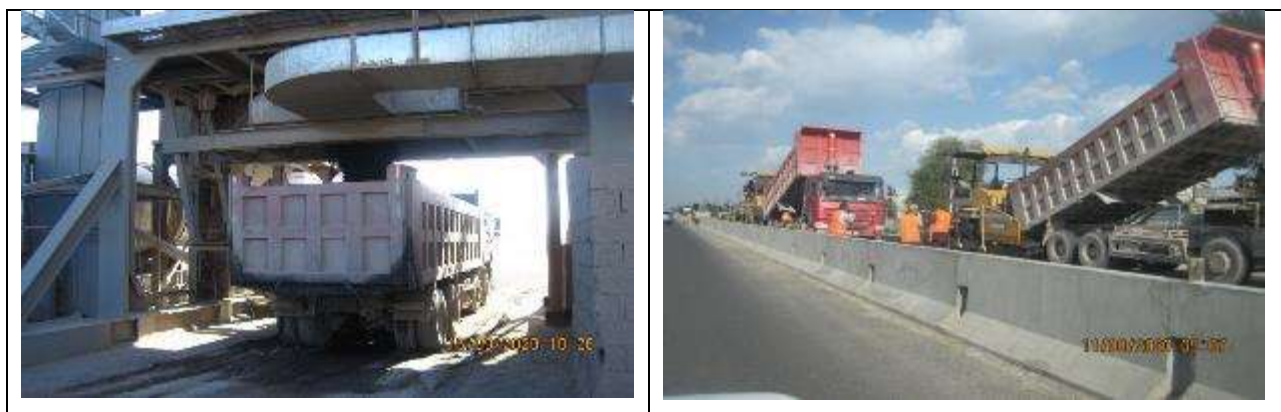
Рисунок 19 Загрузка асфальтовой смеси в самосвалы и выгрузка ее в асфальтоукладчики
