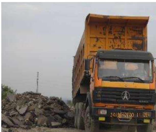
Рисунок 53 Отсыпка старого асфальта на выделенную площадку для дальнейшего использования
