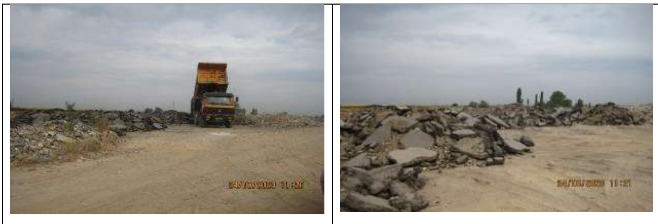
Рисунок 24 Отсыпка старого асфальта на выделенные площадки для дальнейшего использования
