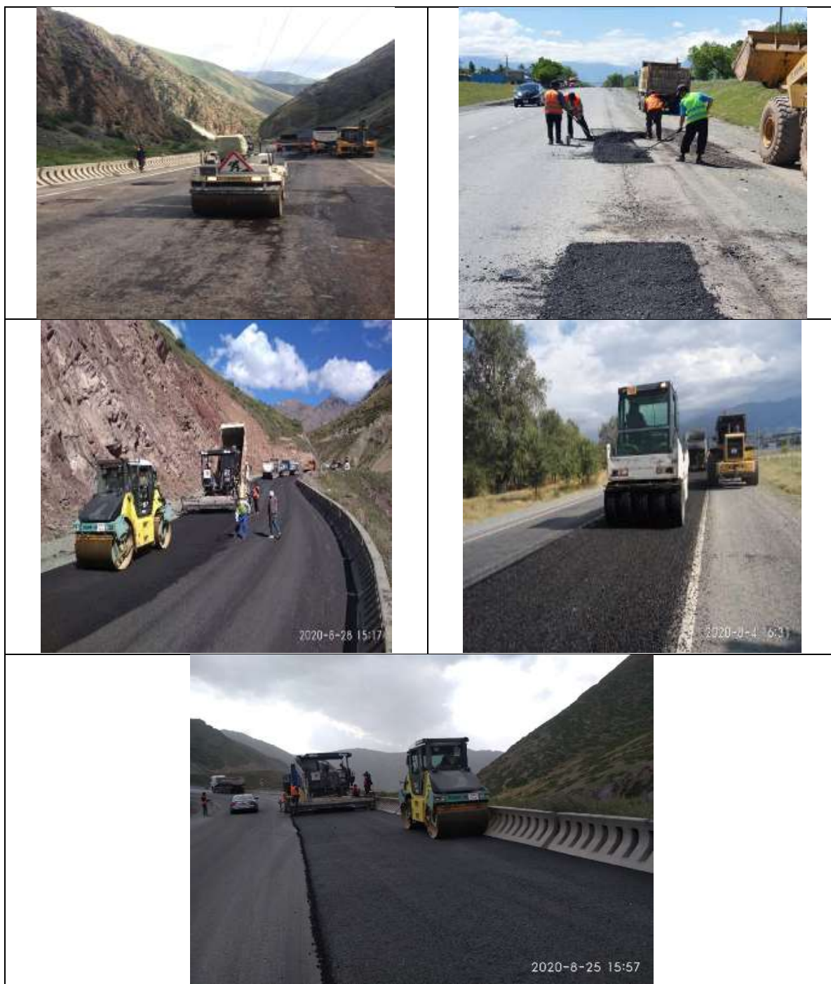
Рисунок 5. Текущий ремонт дороги
