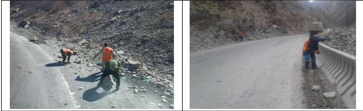
Figure-8. Rockfall hazard
