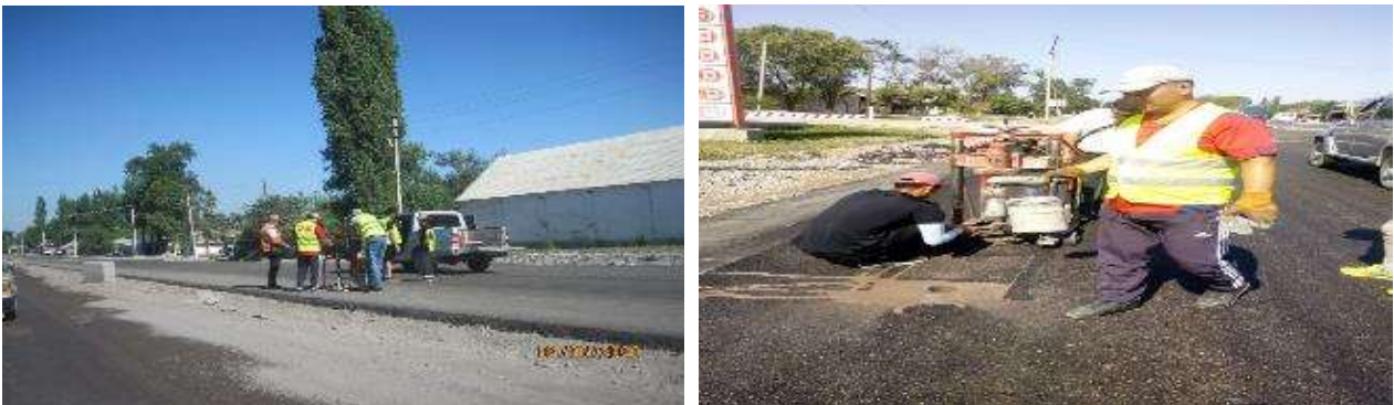
Рисунок 6 Проведение работ по отбору проб для контроля качества асфальта
