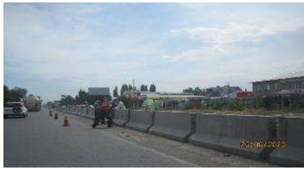
Рисунок 8 Установка разделительных ограждений парапетов типа «Нью Джерси»
