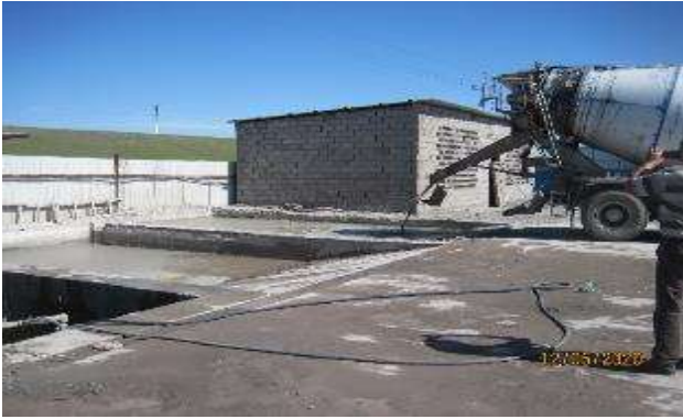
Рисунок 40 Промывка автобетоносмесителей
