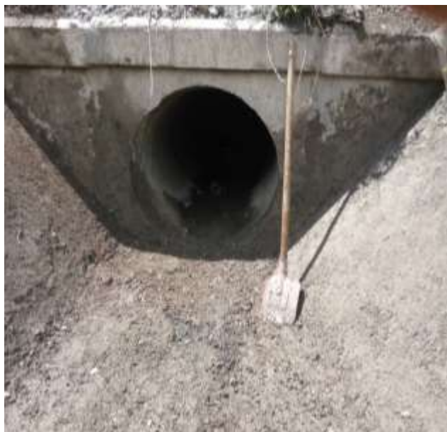
Рисунок – 6. Очистка водопропускных труб, вдоль парапетов
