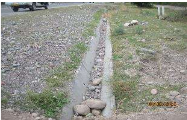
Рисунок 30 Состояние ранее установленных лотков
