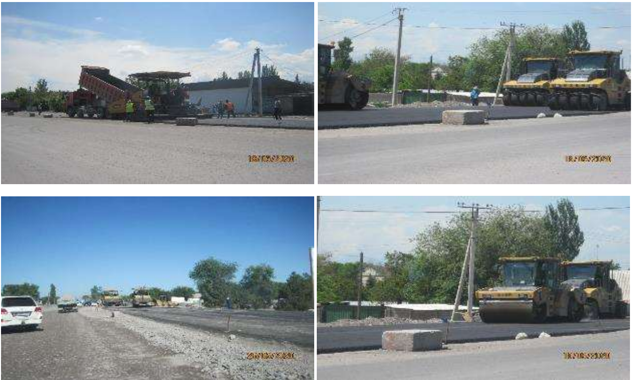
Рисунок 5 Проведение работ по укладке асфальта
