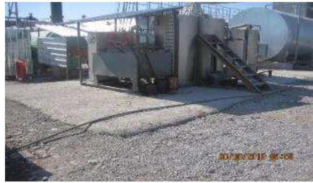
Рисунок 38 Непроницаемое защитное покрытие вокруг емкостей с химическими веществами
