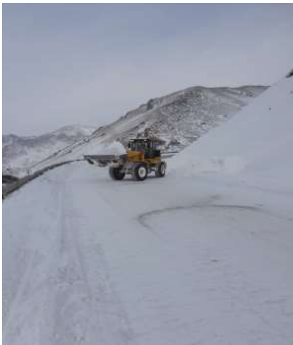
Рисунок - 2. Чистка поверхности дороги в зимнее время года - Подсыпка автодороги песком (мех.способом и вручную) 61-129,5км.
