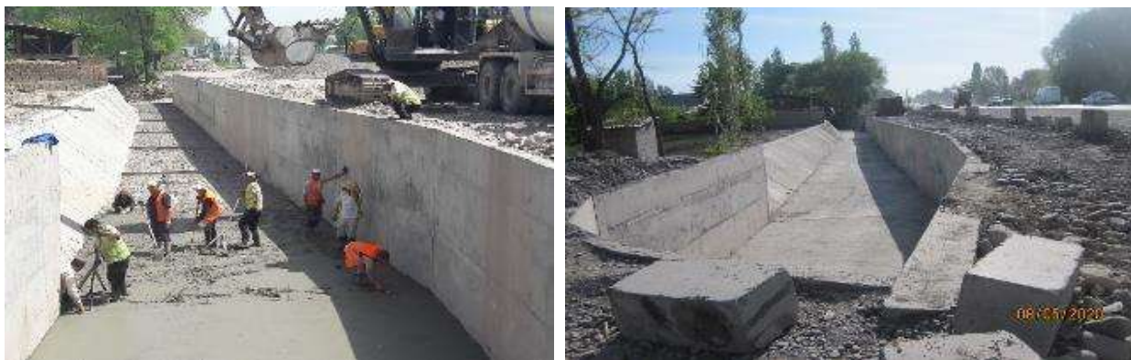
Рисунок 10 Строительство моста на канале Жантай
