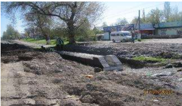
Рисунок 9 Установка водопропускных лотков
