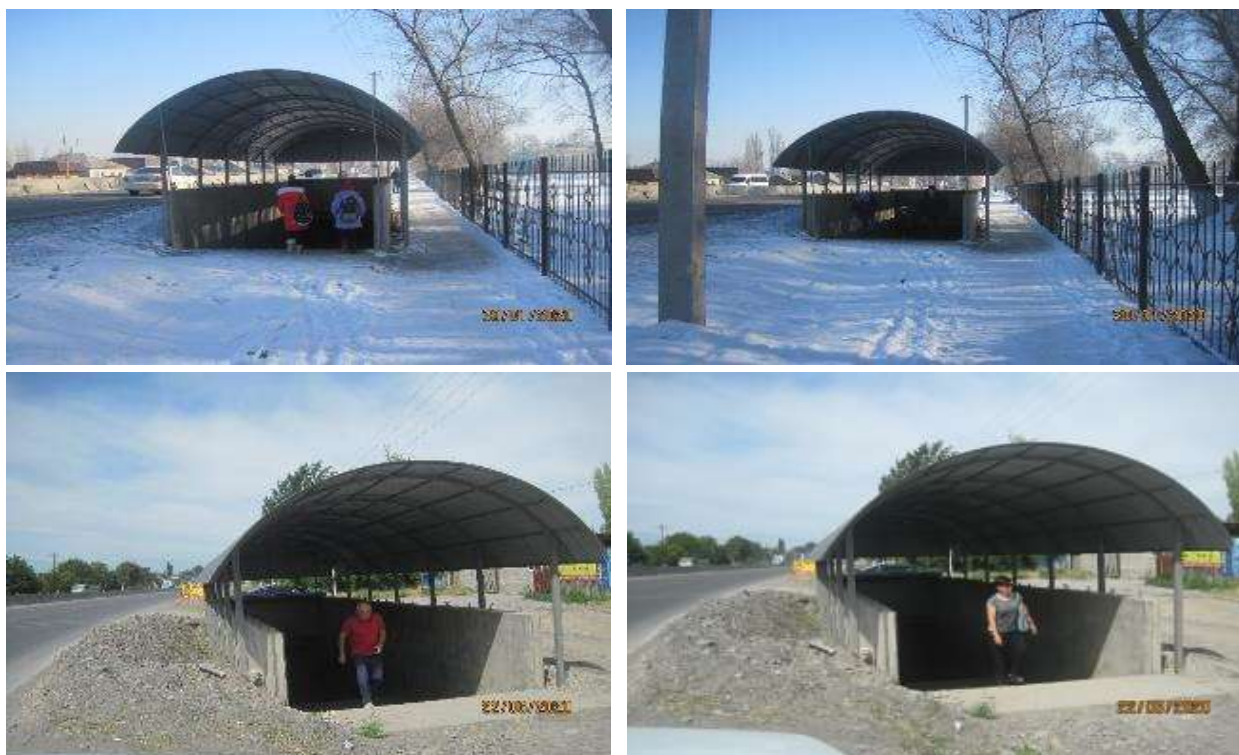
Рисунок 11 Строительство и реабилитация подземных переходов
