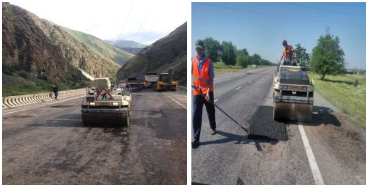
Рисунок -5. Текущий ремонт дороги
