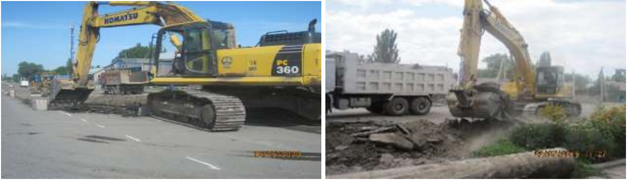
Рисунок 4 Снятие старого асфальта и непригодного грунта
