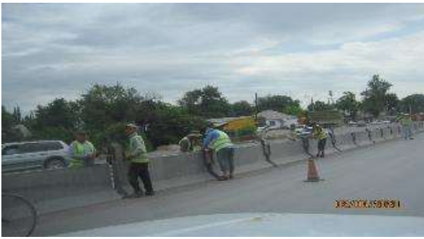
Рисунок 8 Установка разделительных ограждений парапетов типа «Нью Джерси»
