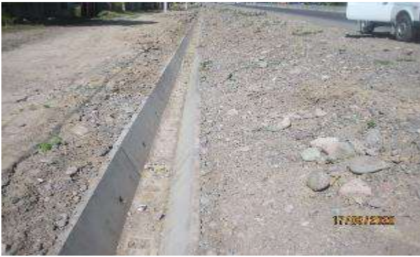
Рисунок 29 Установка водопропускных лотков
