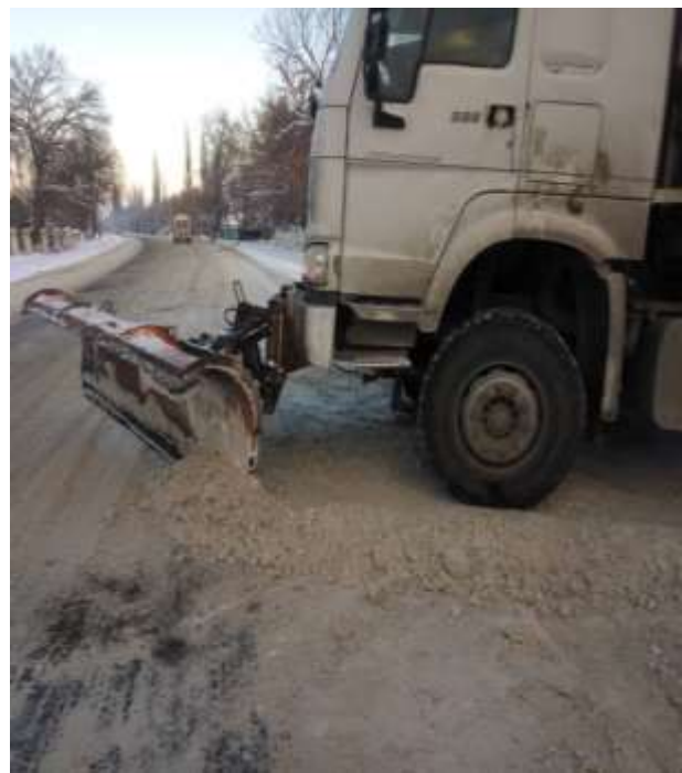
Рисунок - 2. Чистка поверхности дороги в зимнее время года - Подсыпка автодороги песком (мех.способом и вручную) 61-129,5км.
