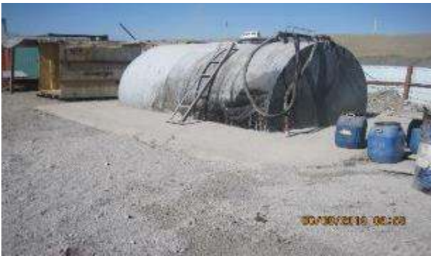
Рисунок 38 Непроницаемое защитное покрытие вокруг емкостей с химическими веществами
