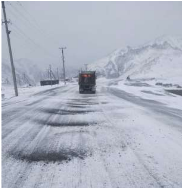
Рисунок - 3. Подсыпка автодороги песком
