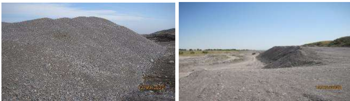
Рисунок 12 Проведение работ на карьере Ак-Суу2
