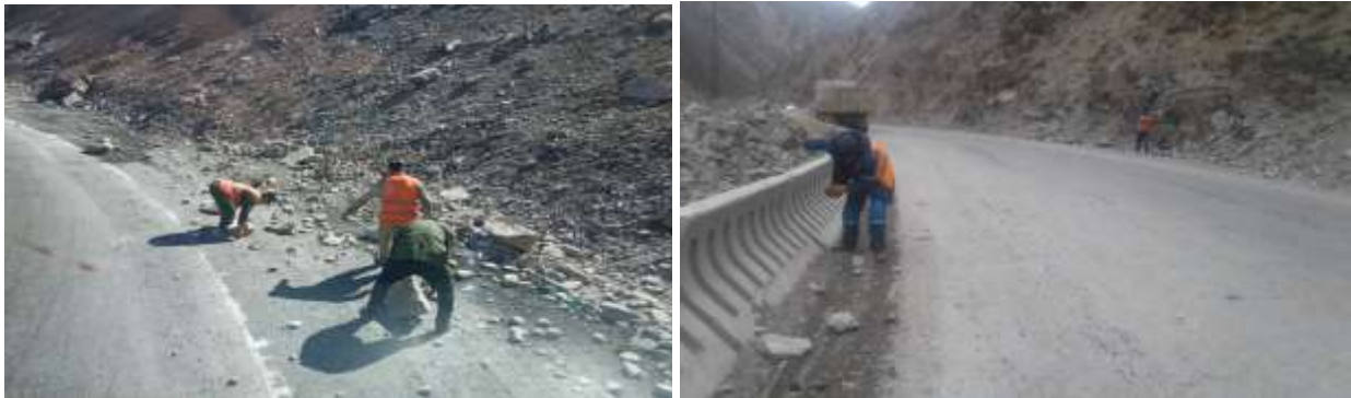
Figure-8. Rockfall hazard
