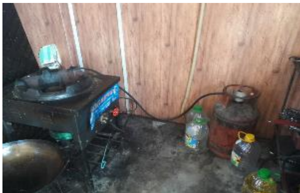
Рисунок 17. Размещение баллонов с пропаном вблизи открытого огня
