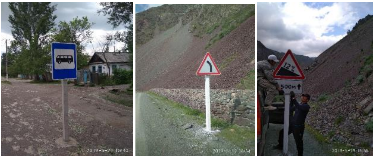
Рисунок 7 Установка дорожных знаков
