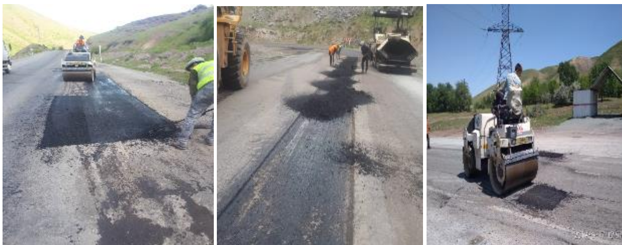
Рисунок - 5. Текущий ремонт дорожной одежды
