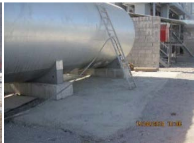
После химикатов с бетонной площадкой, обеспечивающей легкую очистку
