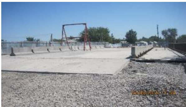
Рисунок 7. Строительство моста на реке Сокулук
