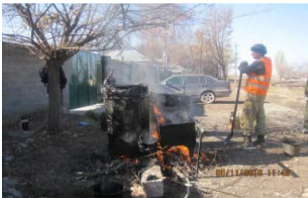
Рисунок 27. Сжигание битума для нагрева битума при гидроизоляции водопропускных труб
