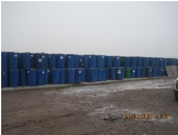
Рисунок 36 Битум в металлических бочках, заскладированный на специально подготовленной площадке
