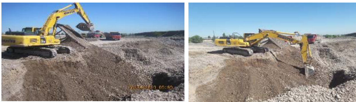
Рисунок 9. Карьер Кара-Балта и превышение экскаватором разрешенной глубины разработки
