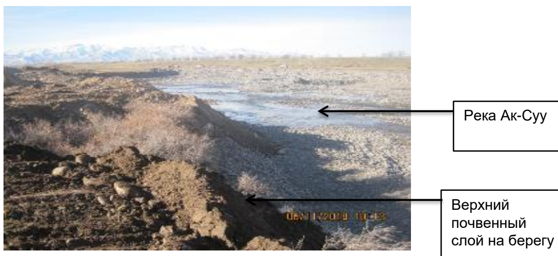
Рисунок 31. Неправильное хранение верхнего почвенного слоя на русле реки
