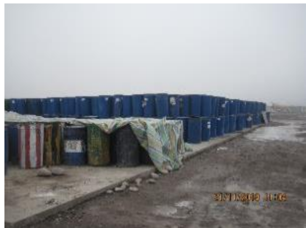
Рисунок 36 Битум в металлических бочках, заскладированный на специально подготовленной площадке
