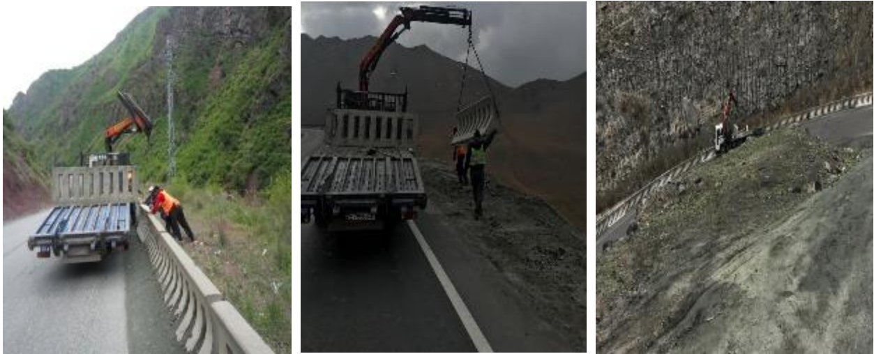
Рисунок 6 - Установка парапетов ББ-3. Заменены непригодные
