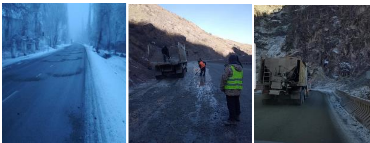
Рисунок-3. Подсыпка автодороги песком
