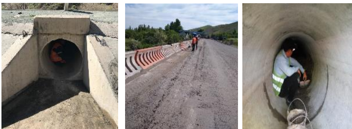
Рисунок - 9. Очистка водопропускных труб
