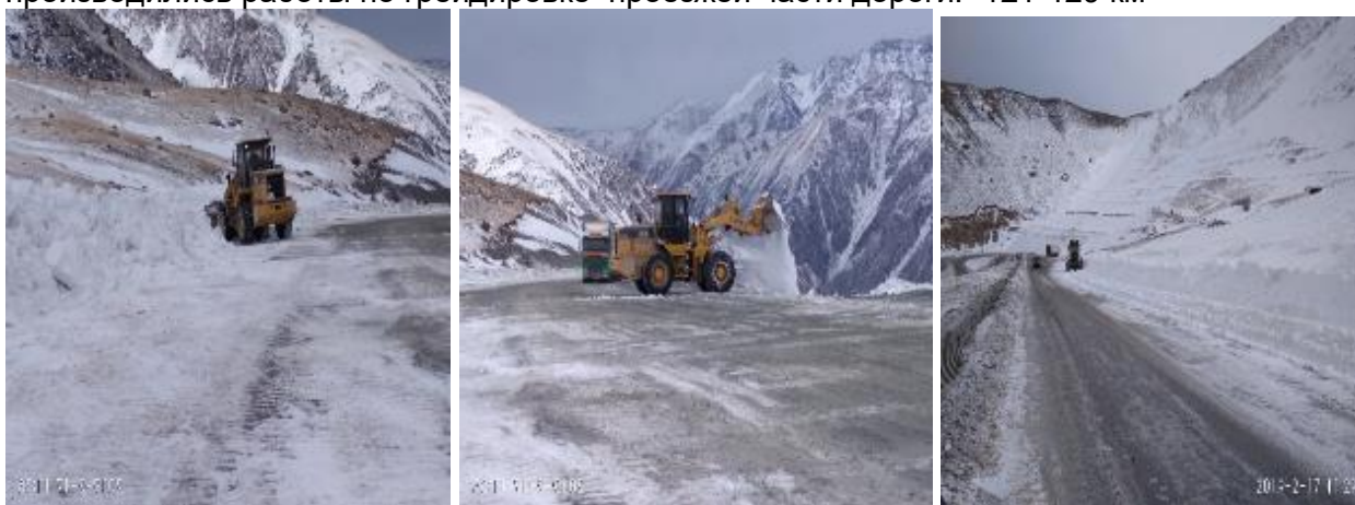
Рисунок - 2. Чистка поверхности дороги в зимнее время года
