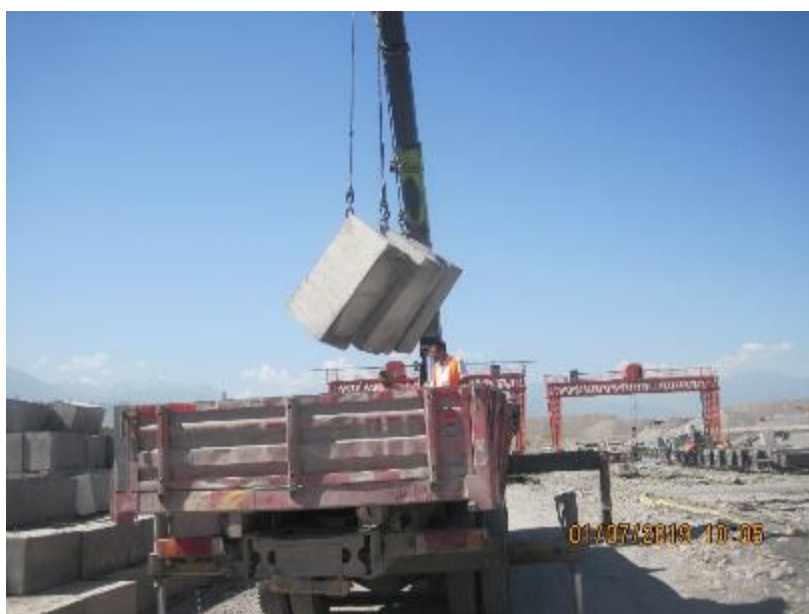
Рисунок 46 Нарушения техники безопасности при производстве работ на полигоне изготовления железобетонных конструкций
