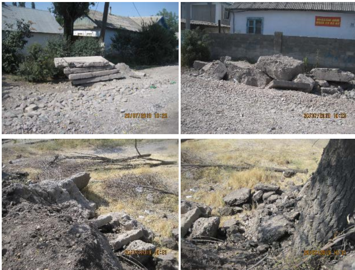
Рисунок 62 Строительные железобетонные отходы
