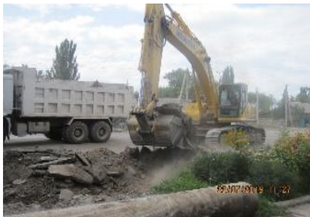
Рисунок 3 Снятие старого асфальта и непригодного грунта
