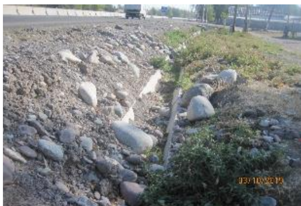
Рисунок 32 Состояние ранее установленных лотков
