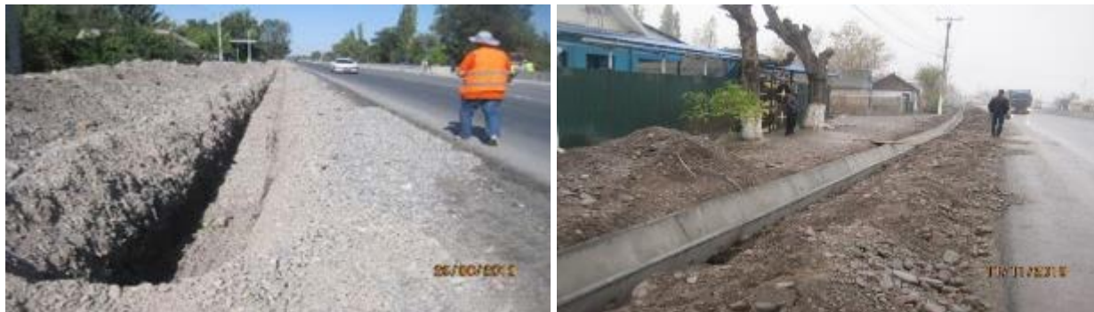
Рисунок 7 Установка водопропускных лотков
