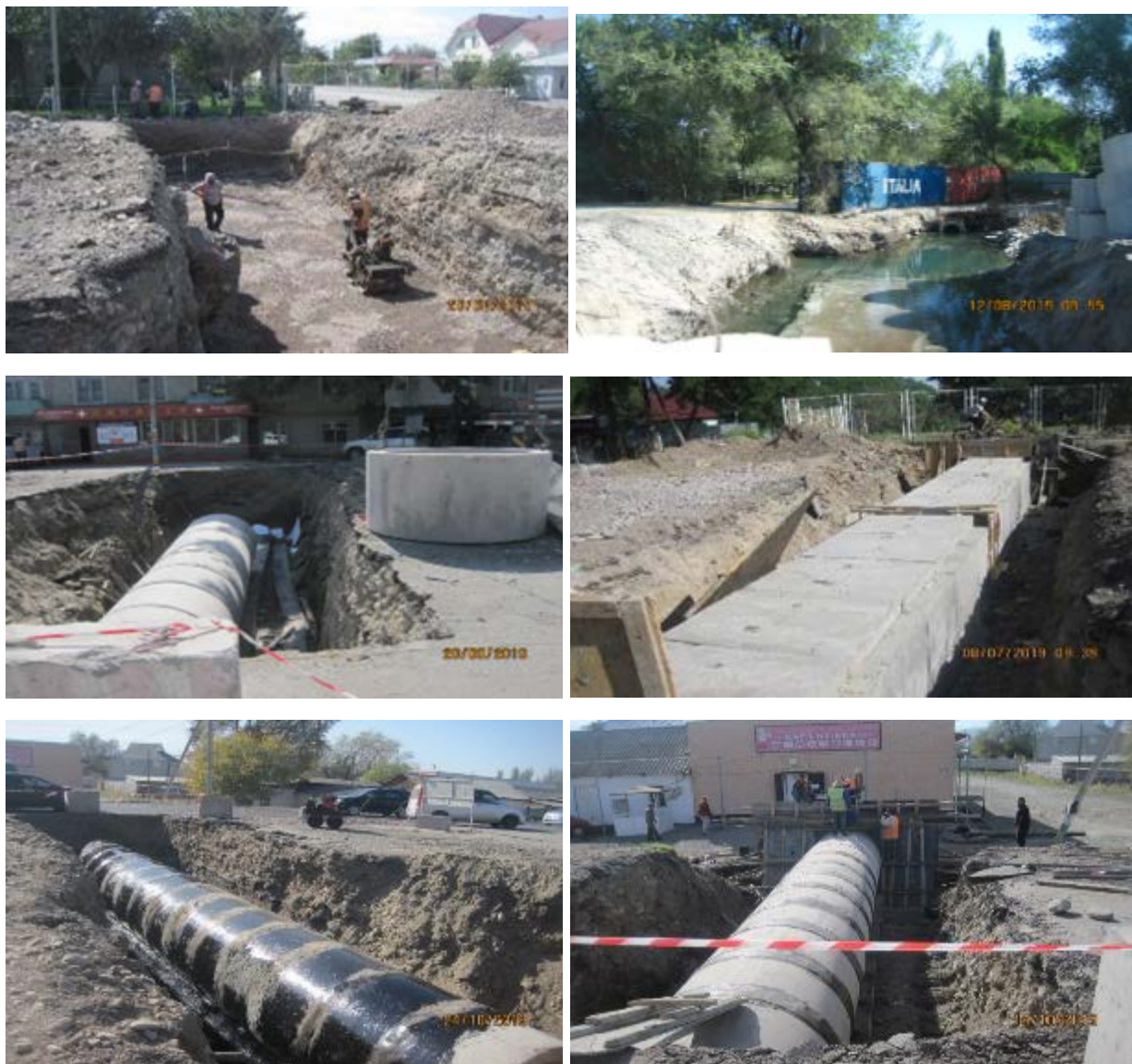
Рисунок 15 Строительство водопропускных труб
