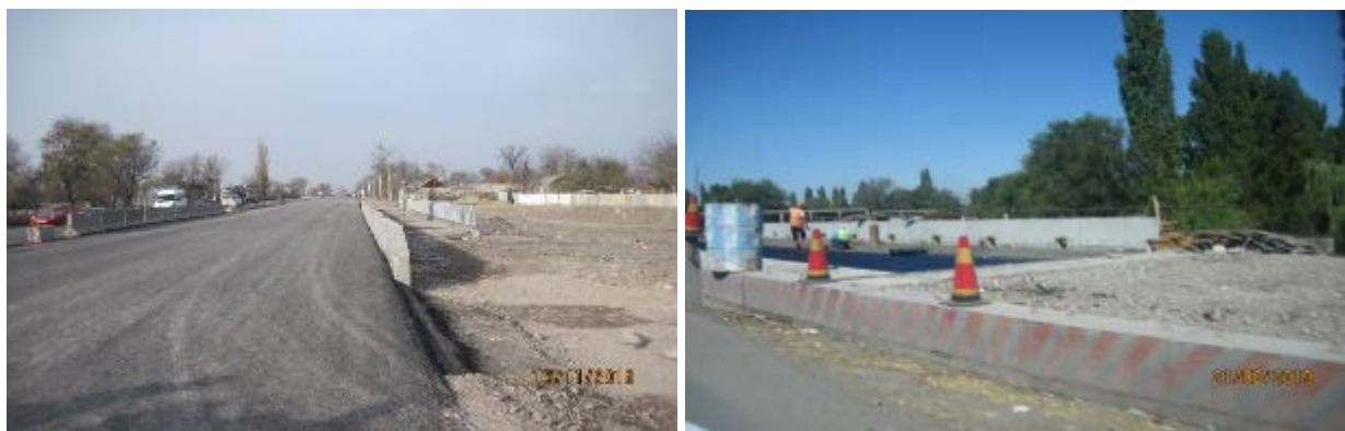
Рисунок 38 Строительство моста на р. Сокулук
