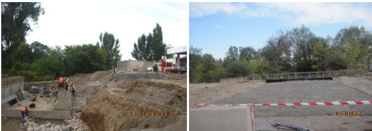
Рисунок 13 Строительство моста на канале Крепостной
