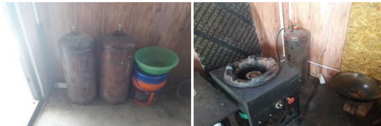
Рисунок 24 Газовые баллоны в помещении кухни
