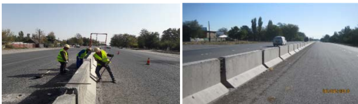
Рисунок 5 Установка разделительных ограждений типа «Нью Джерси»
