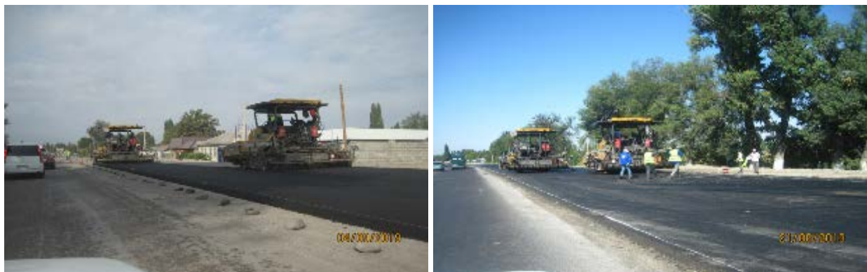
Рисунок 4 Укладка асфальта
