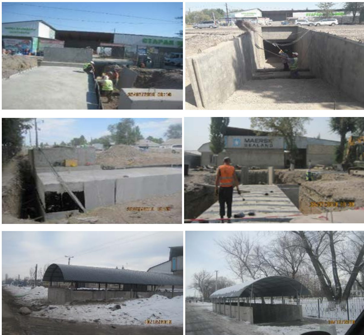
Рисунок 8 Строительство и реабилитация подземных переходов
