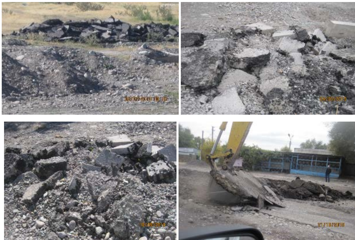
Рисунок 49 Снятие старого асфальта
