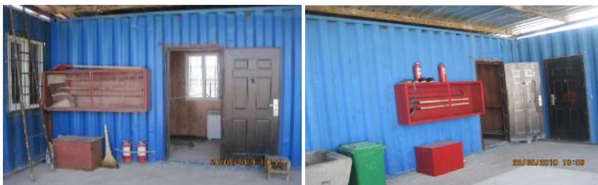
Рисунок 23 Противопожарные щиты на территории лагеря
