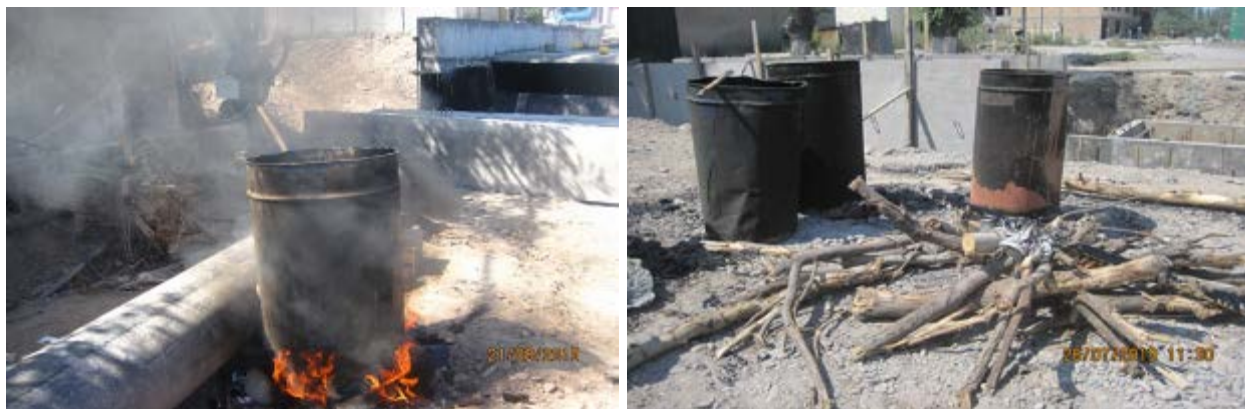
Рисунок 27 Плавление битума при проведении работ по гидроизоляции
