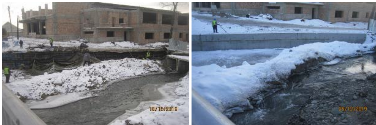
Рисунок 40 Берегоукрепительные работы на южной стороне русла реки Сокулук
