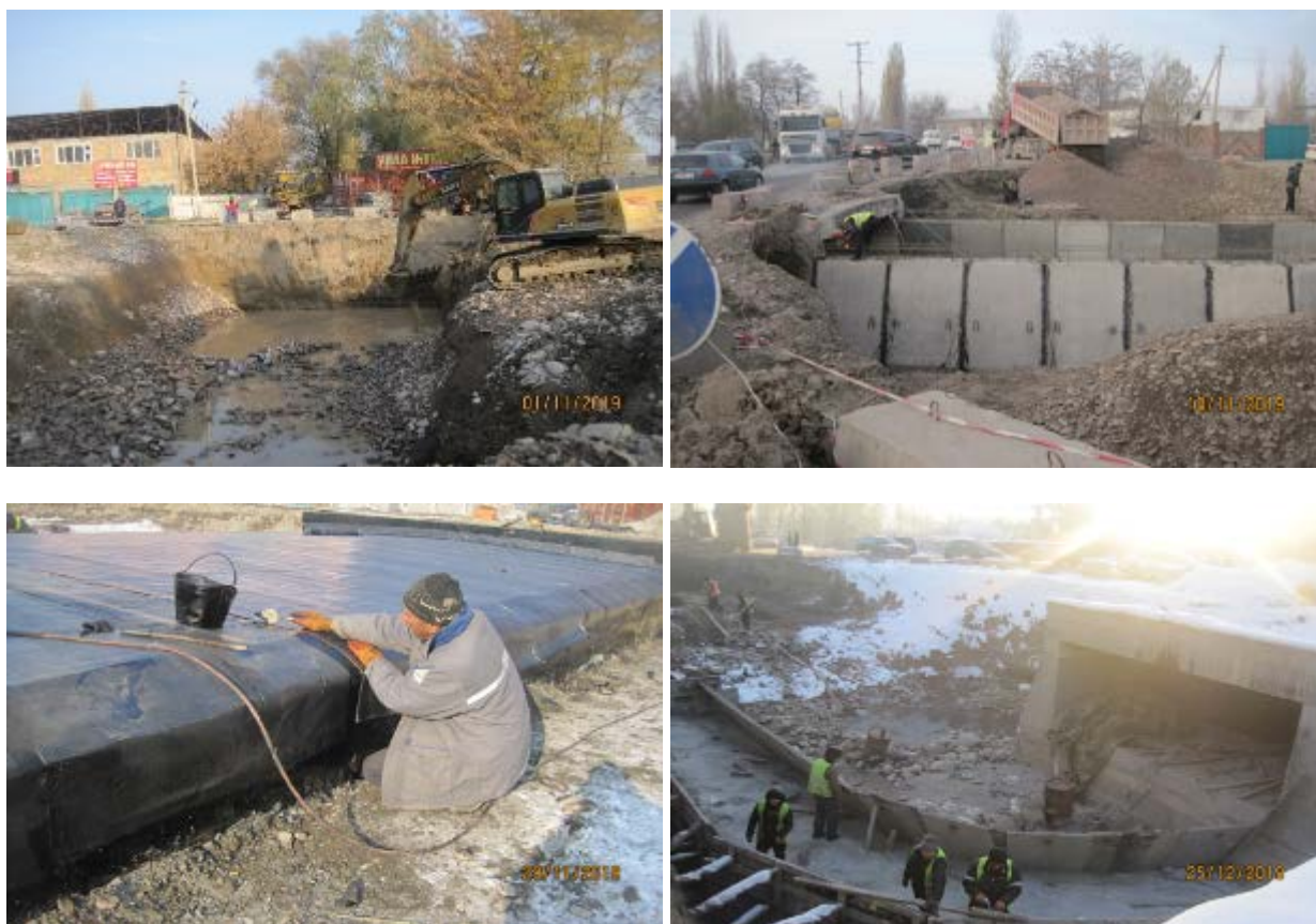
Рисунок 36 Строительство моста на канале Жантай
