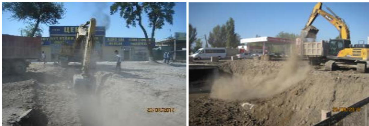
Рисунок 29 Пыление на строительных участках
