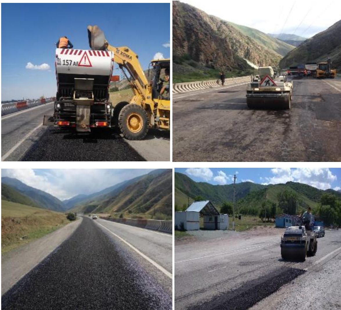
Рисунок -5. Текущий ремонт дорожной одежды
