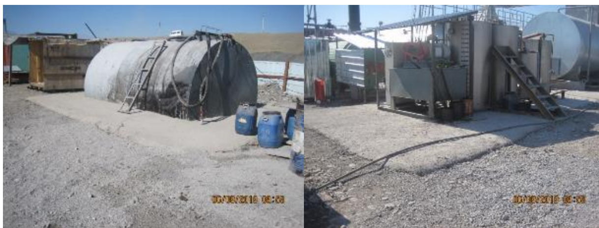
Рисунок 45 Непроницаемое защитное покрытие вокруг емкостей с химическими веществами
