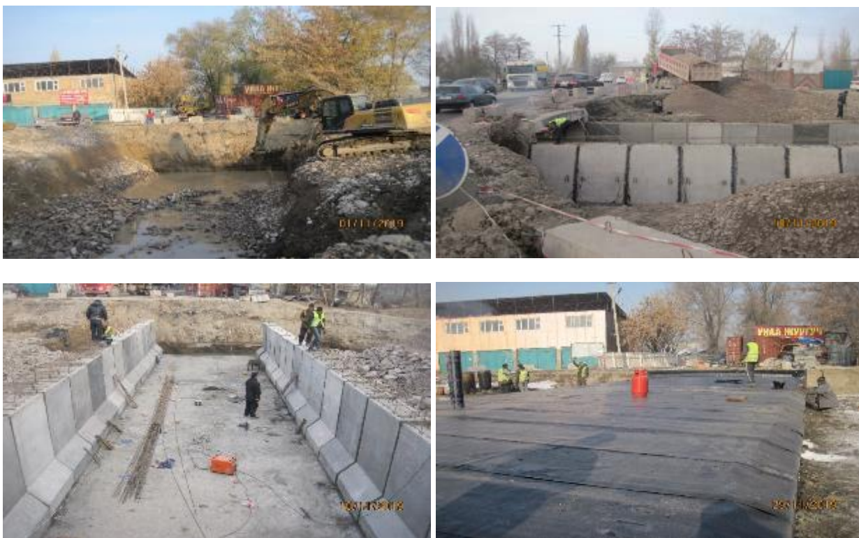
Рисунок 14 Строительство моста на канале Жантай
