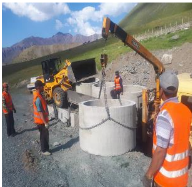
Рисунок – 6. Замена водопропускных труб
