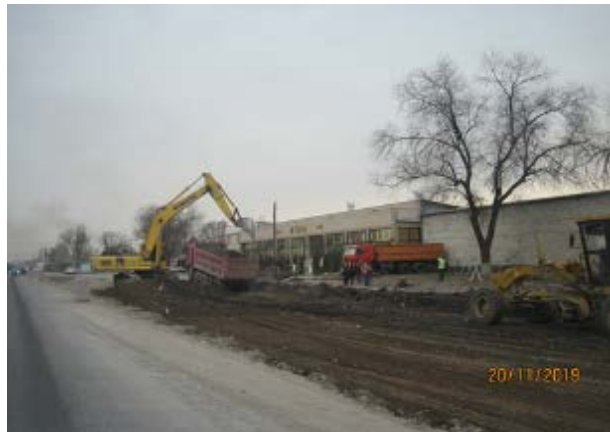
Рисунок 3 Снятие старого асфальта и непригодного грунта
