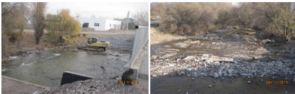
Рисунок 39 Очистка русла реки Сокулук от строительных отходов с северной стороны моста
