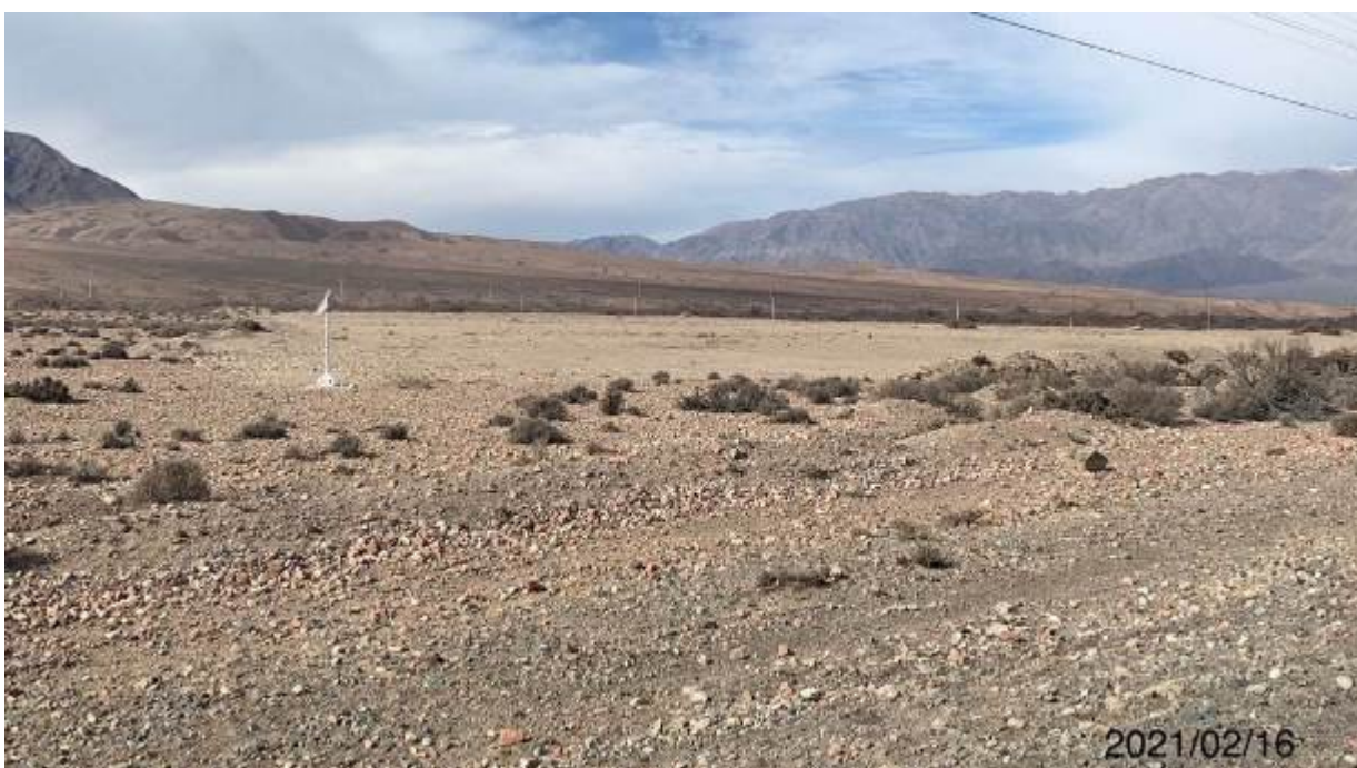
Фото 105. Лот 1. Карьер км. 9+000. Обеспечено снятие почвенно-растительного слоя и отмечены границы территории карьера, посредством установки белых стоек с флажками.
