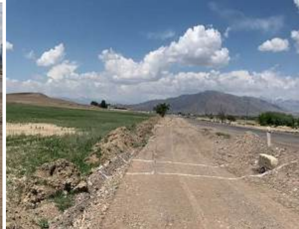
Фото 79. Территория после очистки деревьев на км 75.
