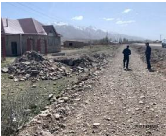
Фото 83. Нарушенный проезд к дому
