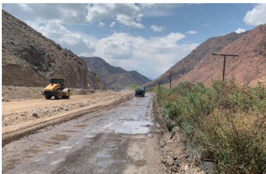
Фото 16. Уплотнение грунта на участке дороги км. 13+280
