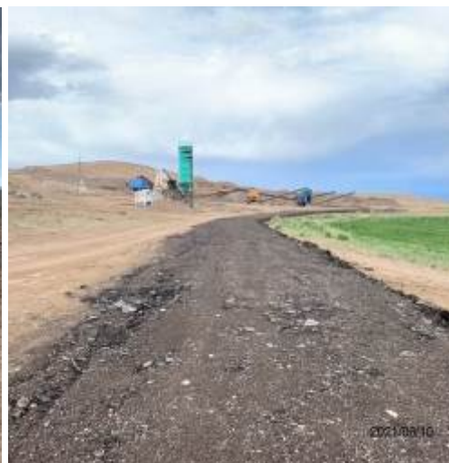
Фото 70, 71. Лот 2. Подсыпанная технологическая грунтовая дорога к ДСУ
