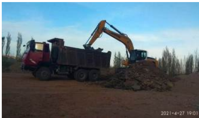
Фото 58. Лот 1. Вывоз отходов старого асфальтобетона
