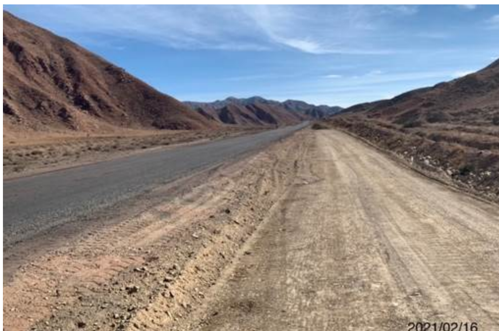
Фото 14. Уширение дороги на участке км. 14+050 – 16+500: после расчистки и корчевания.
