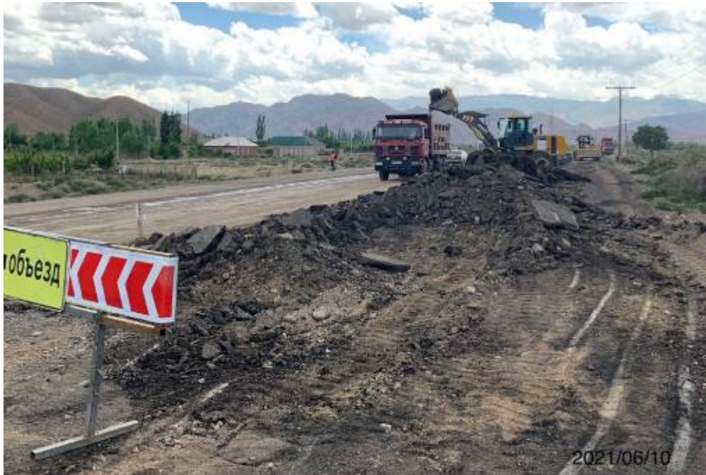
Фото 19. Лот 1. Кирковка и вывоз старого асфальтобетона на км.7+560
