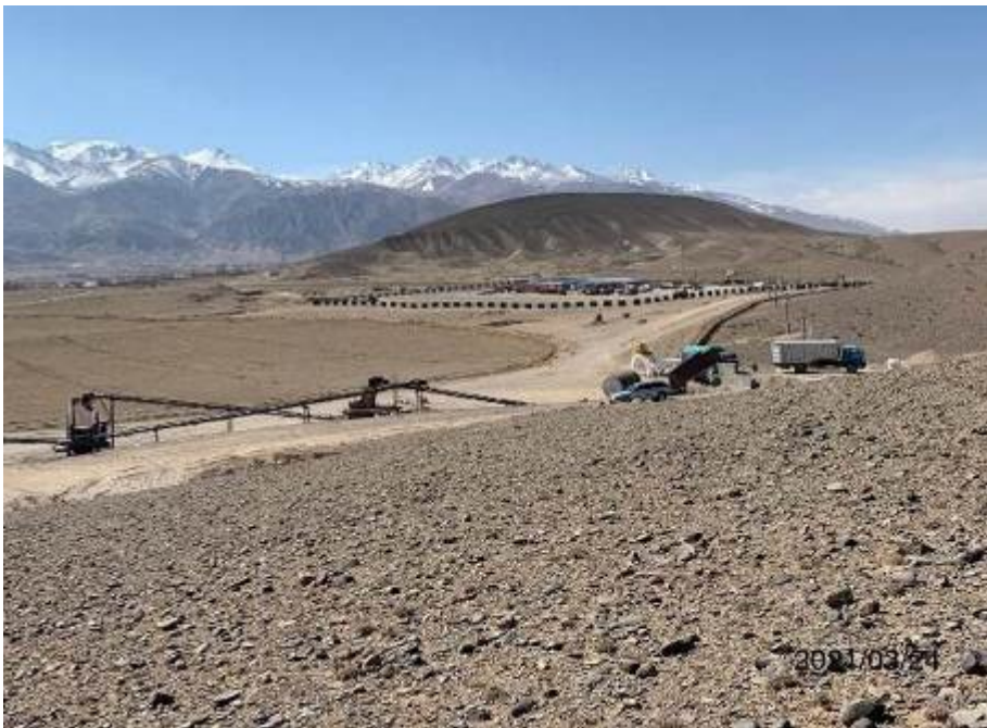
Фото 45. Лот 1. Месторасположение лагеря Подрядчика.
