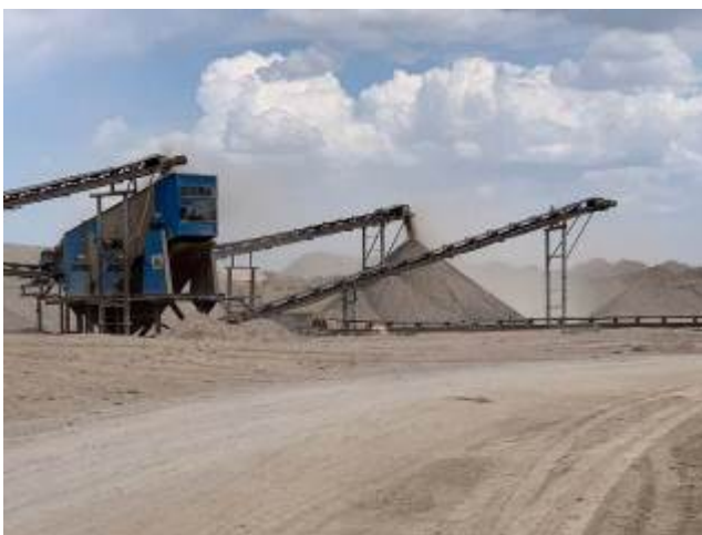
Фото 68. Лот 2. Работа ДСУ без орошения водой перерабатываемого материала.
