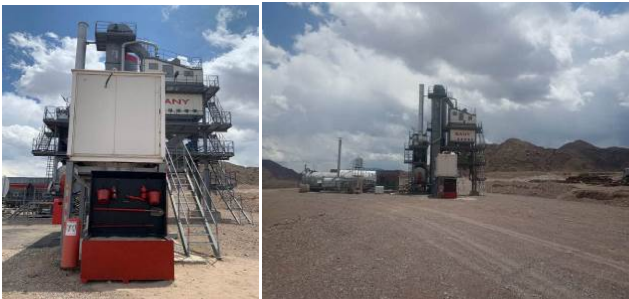
Фото 103–104. Состояние территории после завершения работ по монтажу АБЗ.
