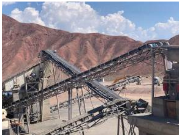
Фото 100. Лот 1. При работе ДСУ не наблюдается выделение пыли. К ДСУ подведена система гидроорошения
