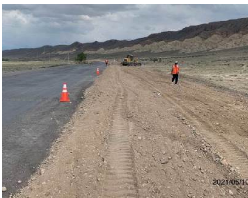
Фото. 25. Км 74+100. Планировка слоя зем.полотна.
