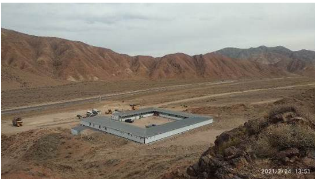
Фото 29. Месторасположение Лагеря строителей, км 16+100
