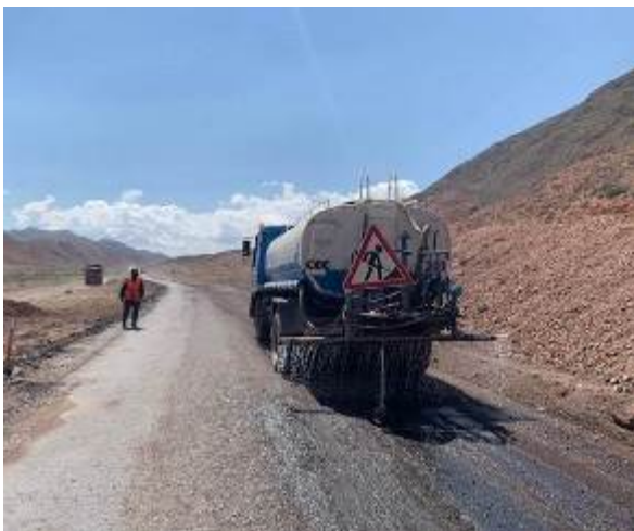
Фото 66. Безнапорная система орошения
