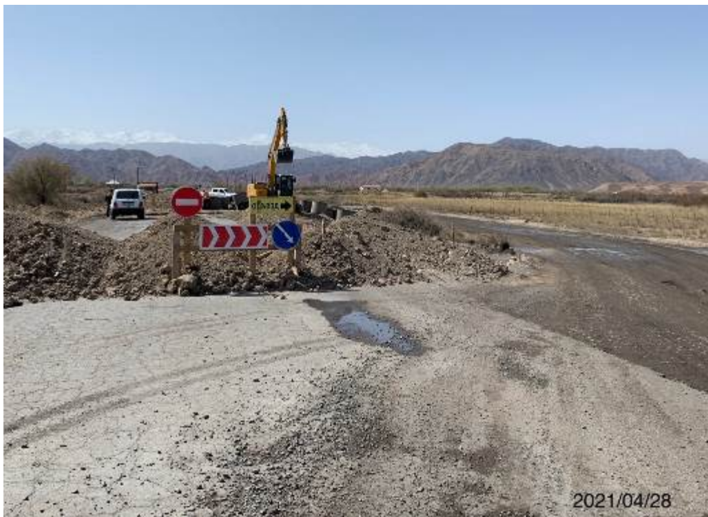
Фото 22. Лот 1. Работы по устройству в/пропускной трубы на км.8+159
