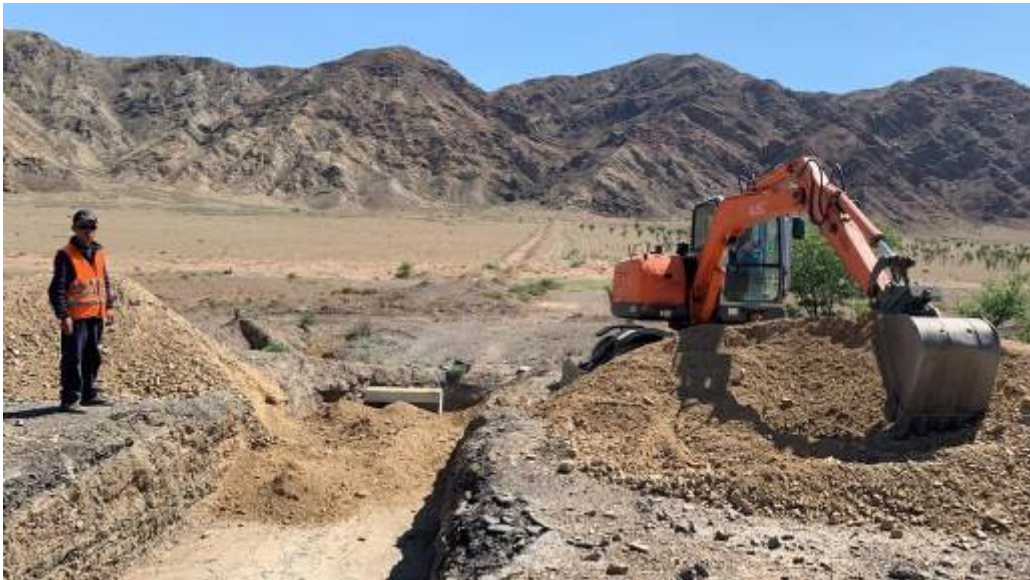
Фото 23. Обратная засыпка трубы на км.18+585
