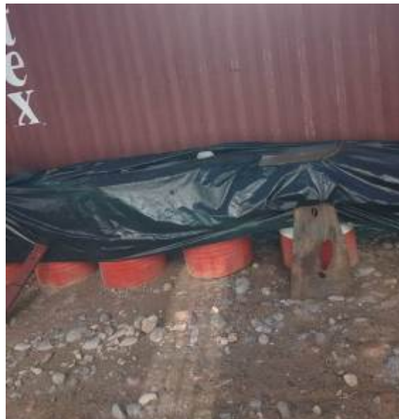
Фото 75. Лот 2. Обеспечена очистка территории и хранение емкостей с ГСМ под защитной пленкой
