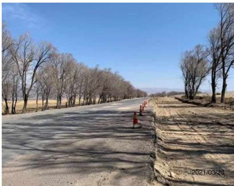
Фото 24. Уширение дороги на участке км. 14+050–16+500: после расчистки и корчевания.
