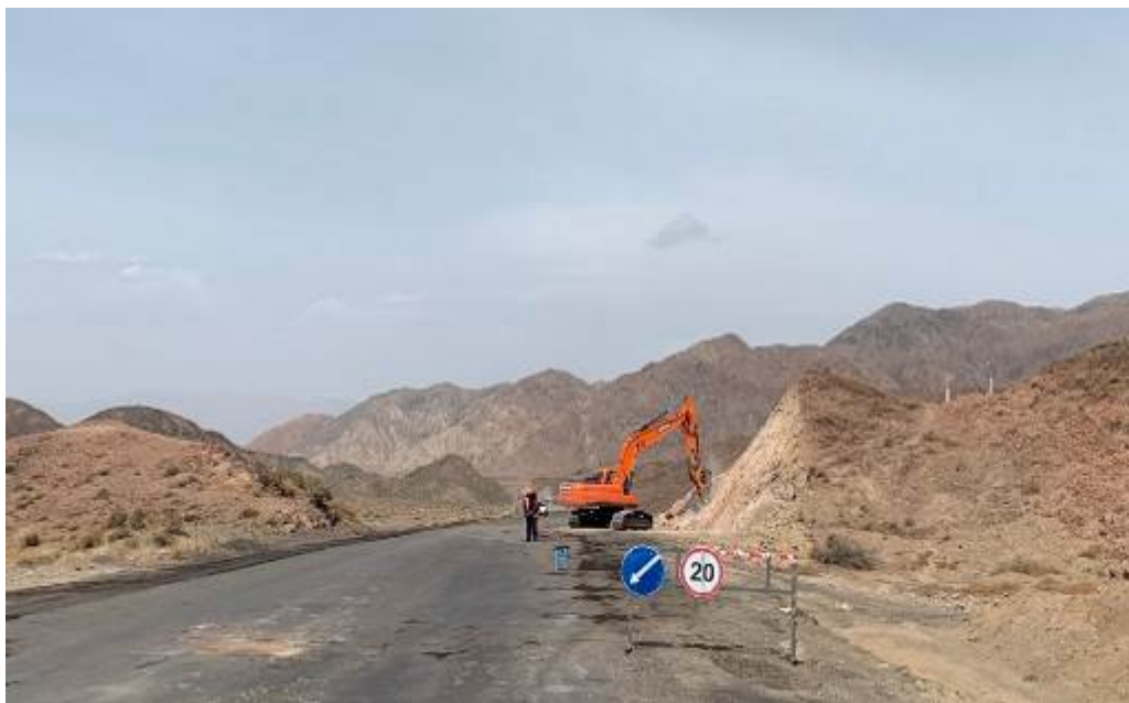
Фото 15. Лот 1. Выемка грунта на км 21+000
