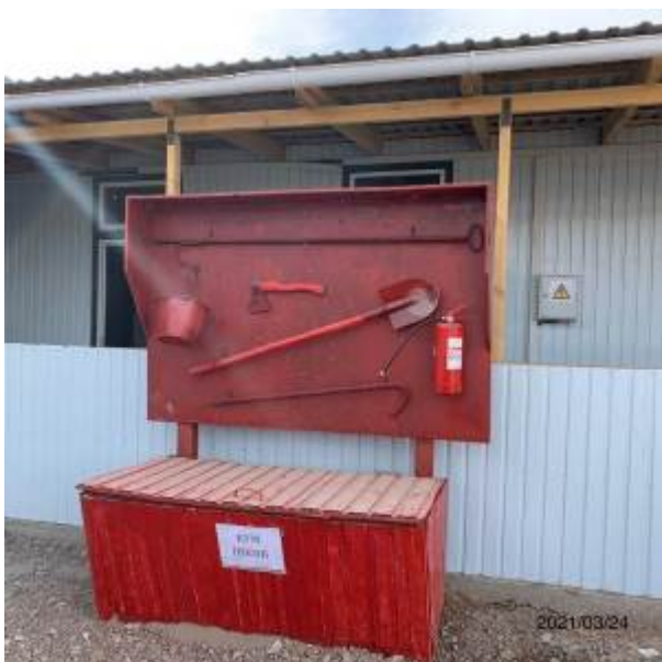
Фото 91. Лот 1 Щит с противопожарным инвентарем
