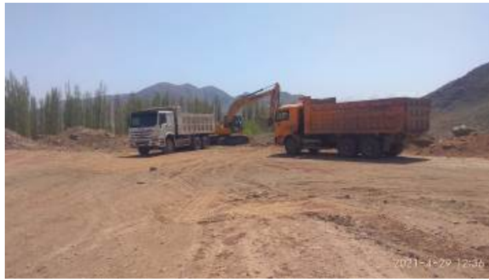
Фото 59. Лот 1. Работы по вывозу отходов старого асфальтобетона с отвала на км. 12+000
