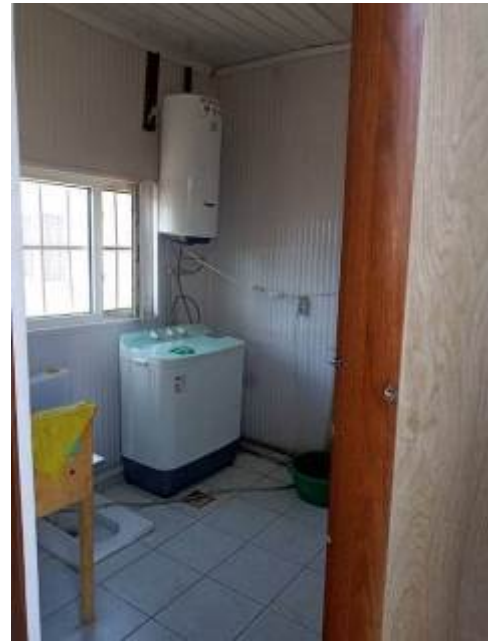
Фото 77. Санузел приведен в соответствие его назначению
