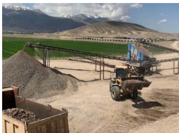
Фото 72. Лот 2. Работа ДСУ после установления системы орошения водой: отсутствует выделение пыли.
