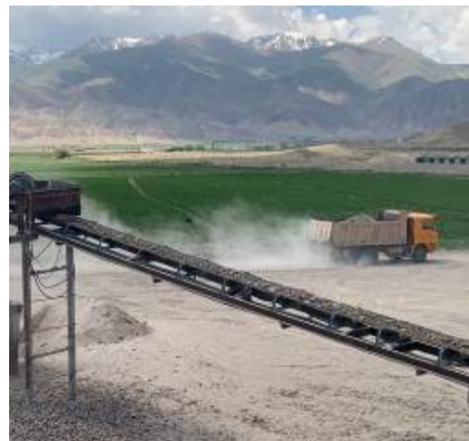
Фото 69. Лот 2. Отсутствие орошение водой грунтовых дорог.
