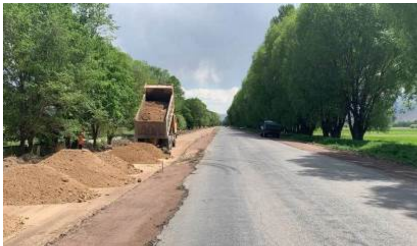
Фото 27. Устройство насыпи на км.64+300
