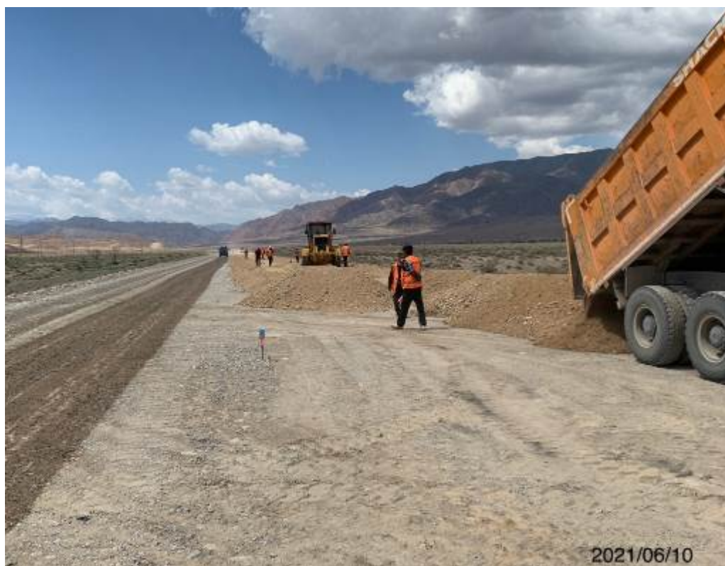
Фото 18. Лот 1. Земработы по устройству насыпи на км.4+200
