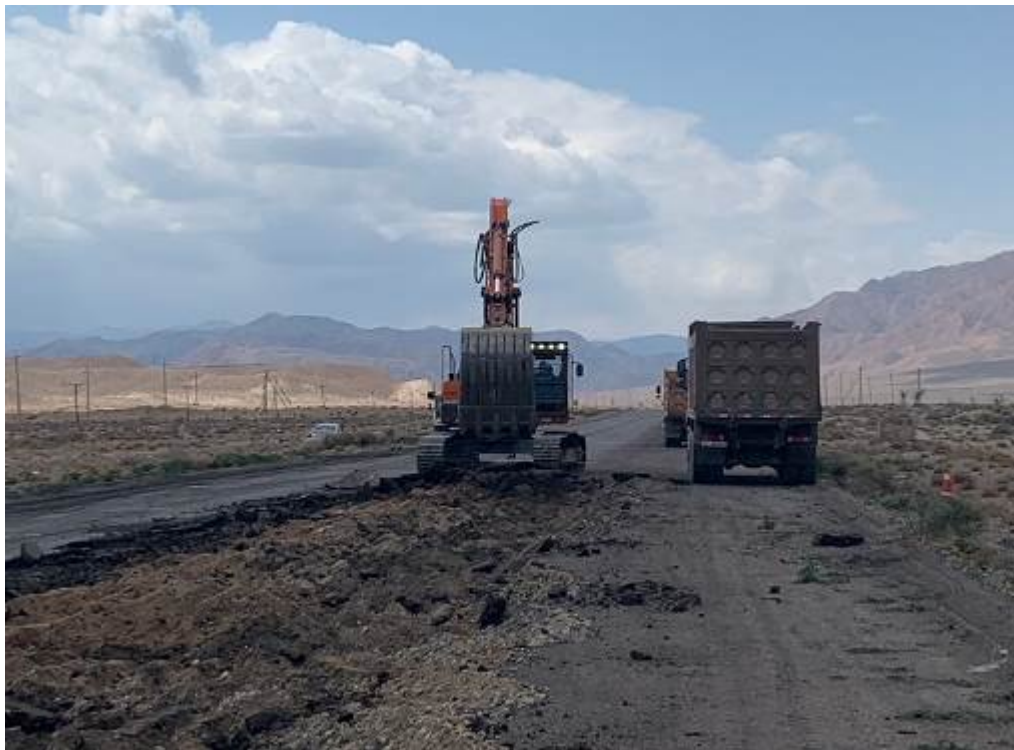
Фото 20. Лот 1. Снятие и вывоз старого асфальтобетона на км.4+800
