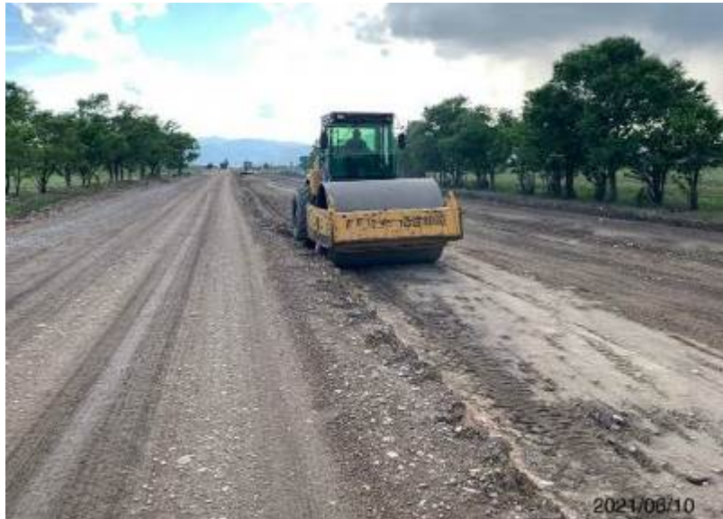
Фото 26. Уплотнение грунта земельного полотна с увлажнением км 79+300
