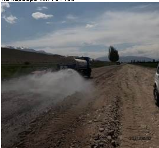
Фото 101. Лот 2. Гидроорошение дорожного полотна
