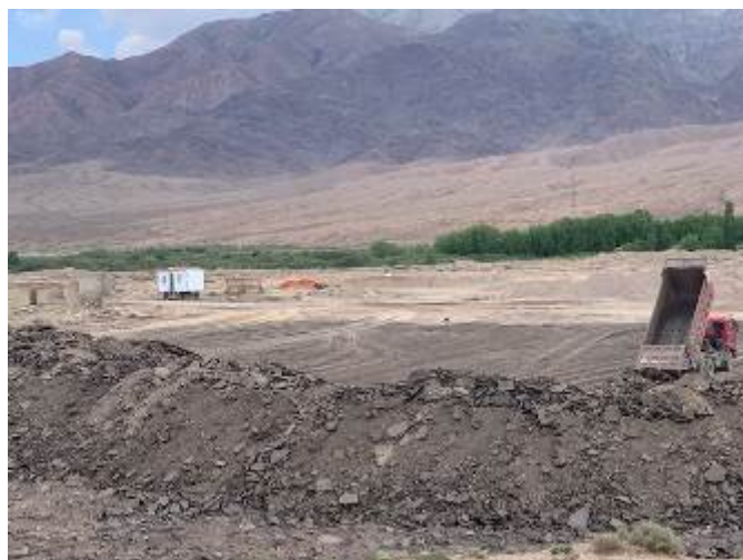
Фото 82. Отвал старого асфальтобетона на км. 7+100 слева до начала размещения, справа во время размещения.
