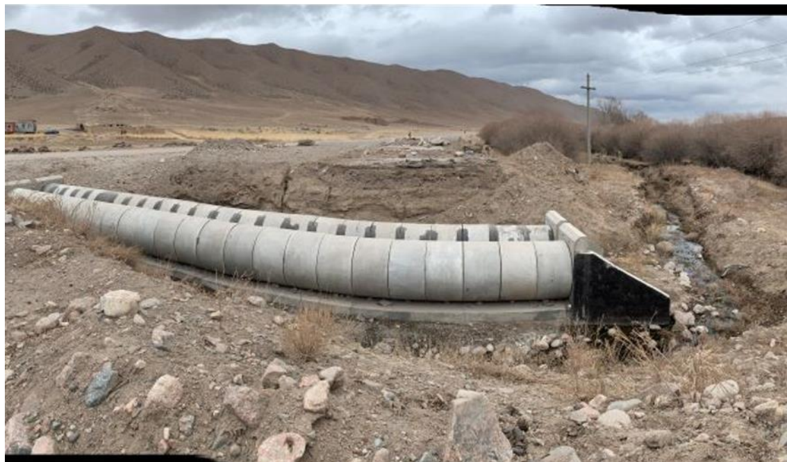
Фото 4. Водопропускная труба (непокрытая)
