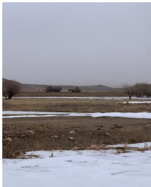
Фото 16. Выравнивание участка под производственную базу
