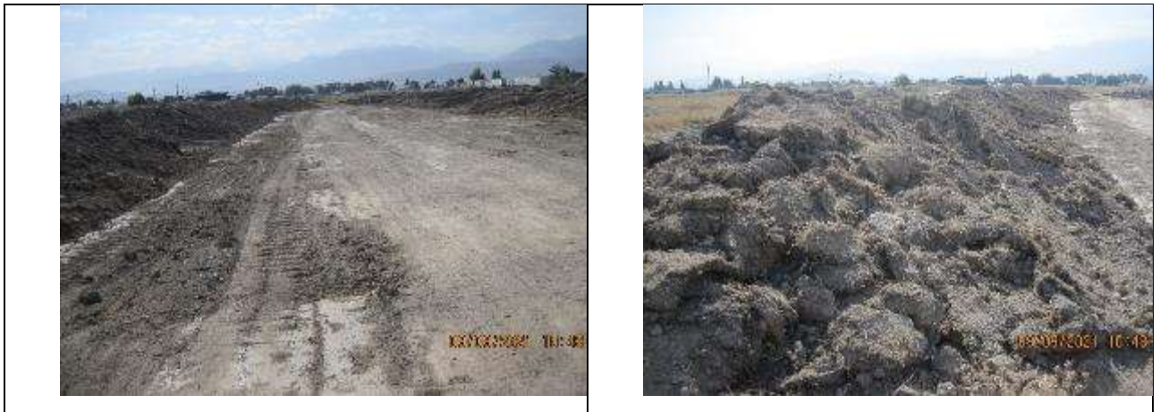
Рисунок 92 . Площадка для хранения непригодного грунта после снятия почвенного слоя. Заскладеированный почвенный грунт.
