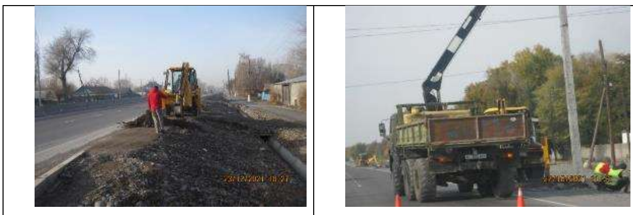
Рисунок 18 Подготовка ям и установка опор для освещения на проектной дороге.
