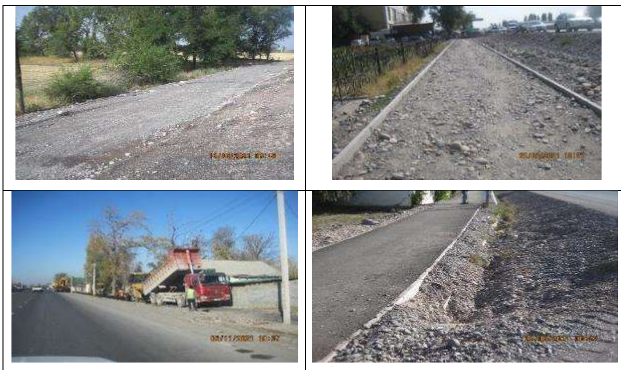
Рисунок 9 Строительство тротуаров.
