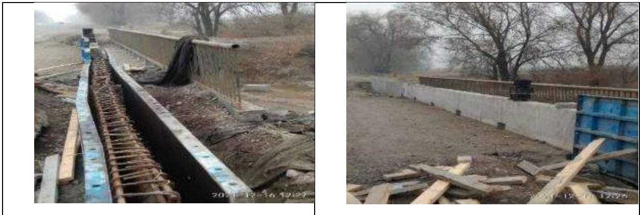
Рисунок 19 Строительство колесоотбойного парапета на р. Джеламыш
