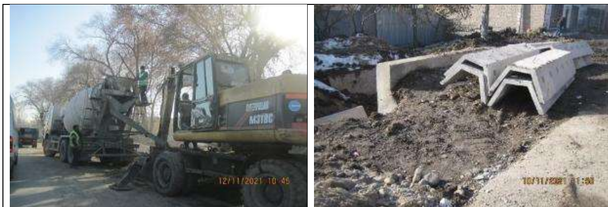
Рисунок 22 Установка придорожных водопропускных лотков на участке км 7,4.
