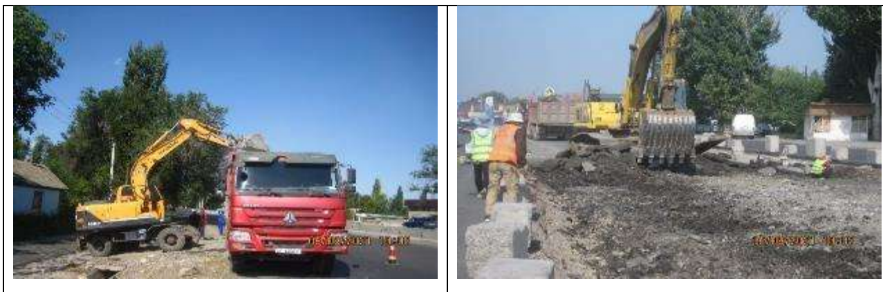
Рисунок 87 Вывоз снятого асфальта в с. Садовое и Новопавловка.
