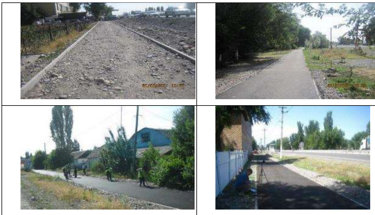
Рисунок 11 Строительство тротуаров в с. Петровка.
