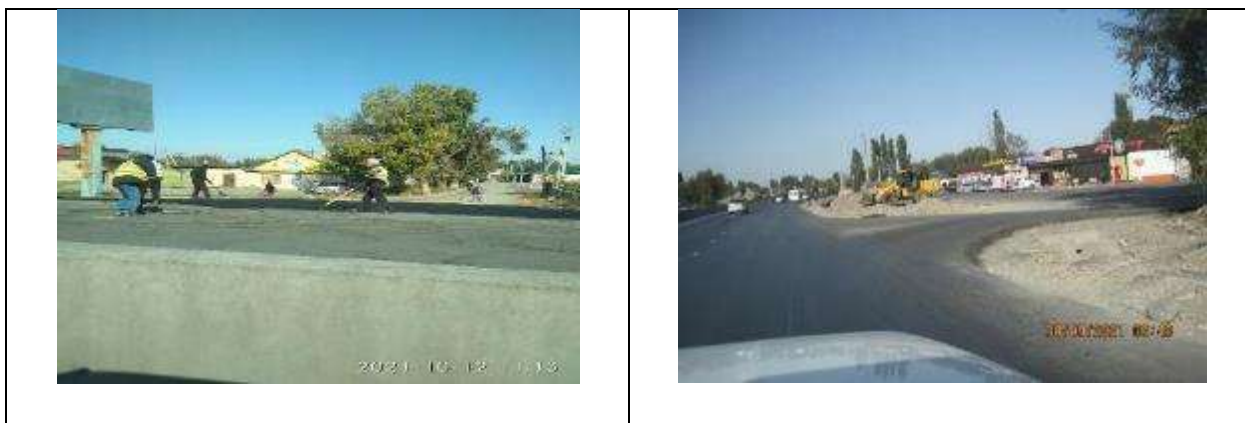
Рисунок 7 Укладка асфальта на съездах на примыкающие к трассе улицы в с. Александровка.
