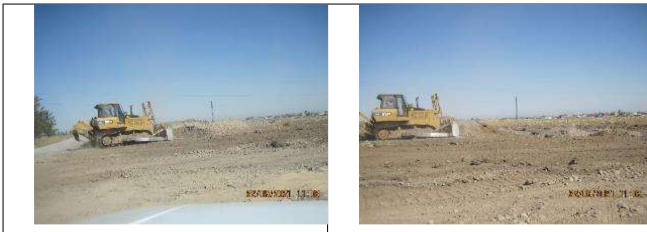
Рисунок 93 Перемещение непригодного грунта на подготовленную площадку.
