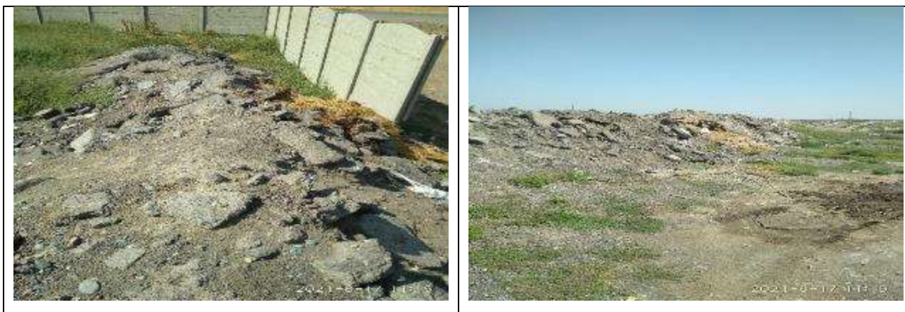
Рисунок 88 Отсыпка старого асфальта на выделенные площадки в с. Сокулук.
