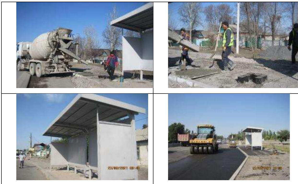
Рисунок 12 Строительство и установка остановок.
