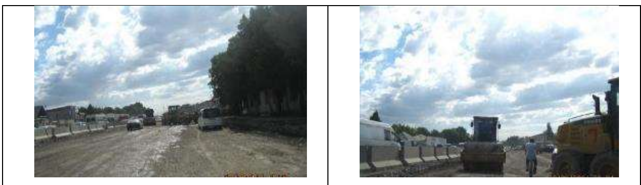
Рисунок 21 Укатка и уплотнение грунта участке 7.4 км.
