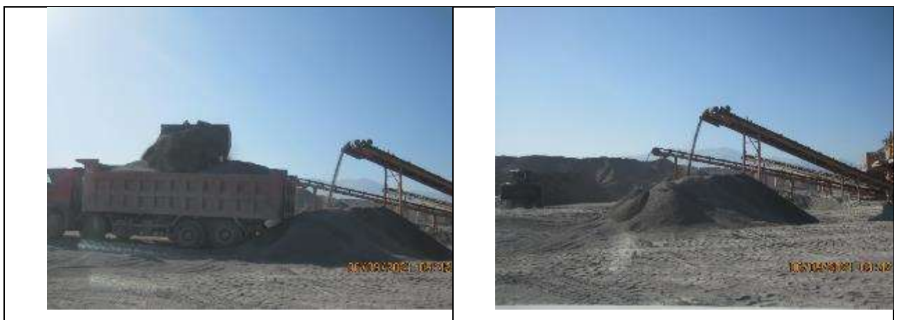
Рисунок 55 Работа камнедробильной установки на увлажненном сырье.
