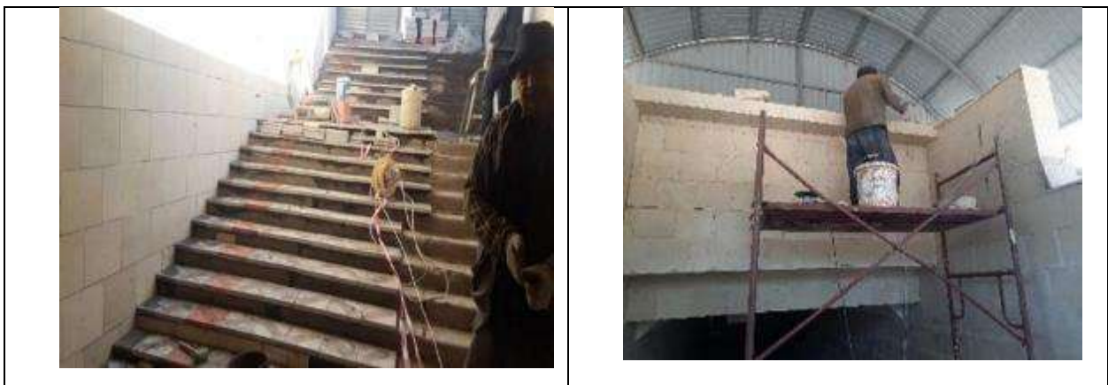
Рисунок 14 Работы по завершению строительства подземных переходов.
