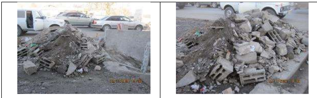
Рисунок 49 Строительные отходы возле строящегося подземного перехода центре с. Сокулук.
