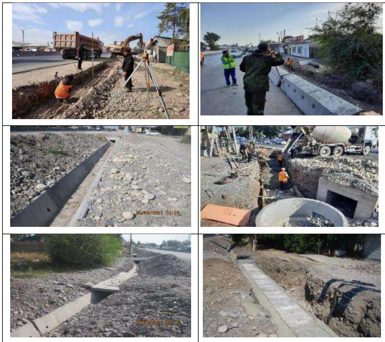
Рисунок 10 Установка придорожных водопропускных лотков и переездов к частным домам и на примыкающие к трассе улицы в с. Александровка.
