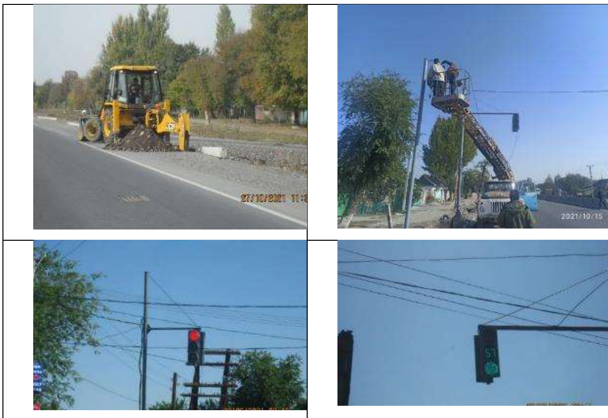
Рисунок 16 Установка новых светофоров на проектной дороге.
