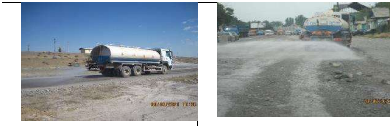
Рисунок 41 . Проведение работ по пылеподавлению (гидроорошение). Дорога на карьер Ак-Суу2 и на участке строительства дороги в с. Сокулук.
