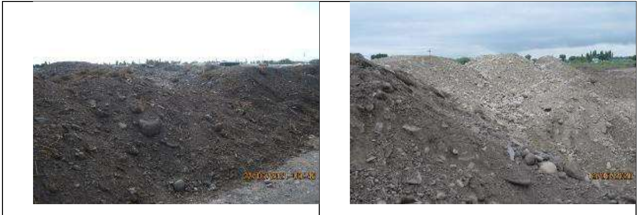
Рисунок 95 Складирование непригодного грунта для дальнейшего использования.
