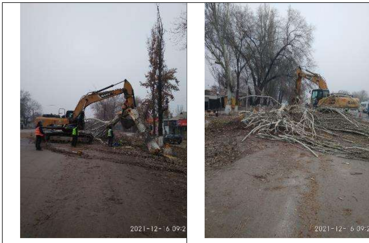
Рисунок 70 Вырубка деревьев на участке дороги км 8,5 – 15,9.
