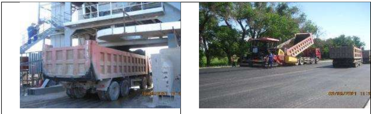
Рисунок 37 Загрузка асфальтовой смеси в самосвалы и выгрузка ее в асфальтоукладчики.
