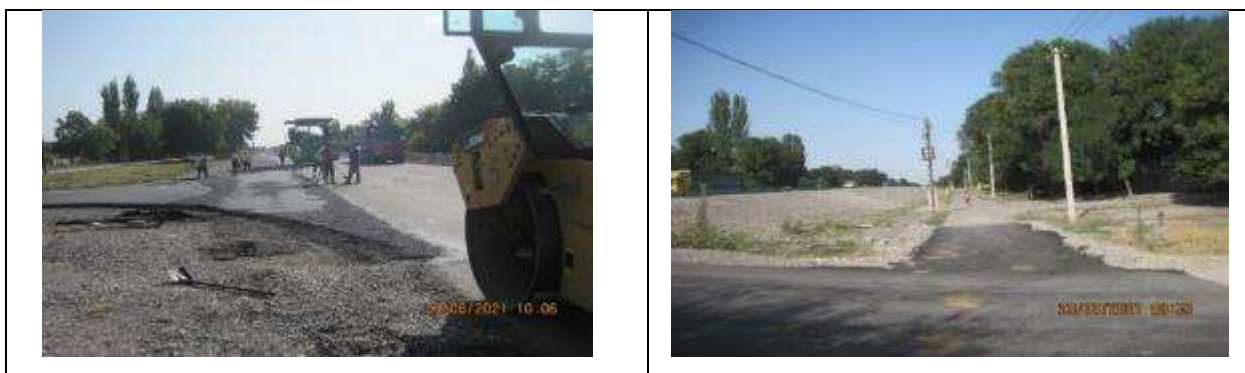
Рисунок 8 Укладка асфальта на съездах на примыкающие к трассе улицы в с. Петровка.
