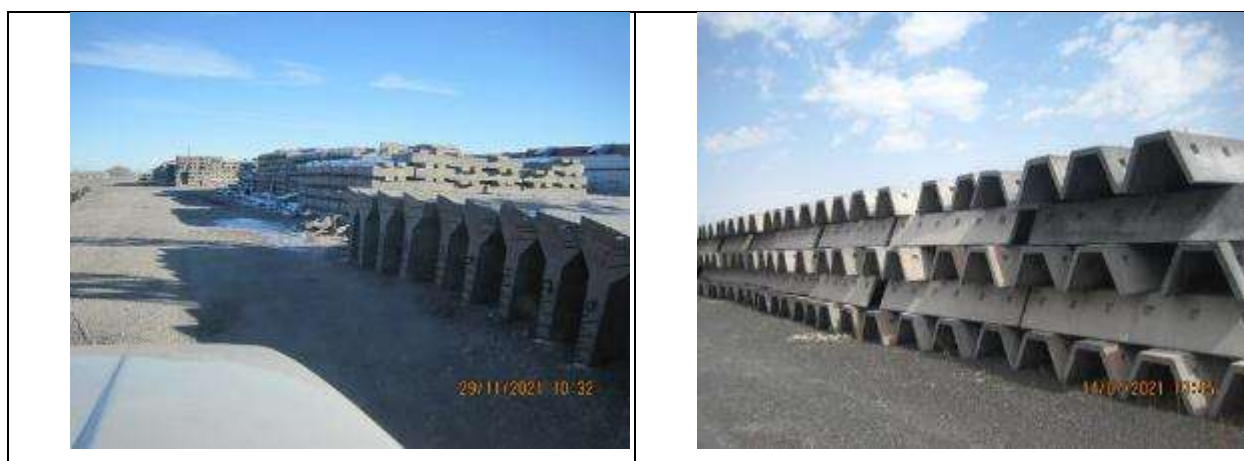
Рисунок 33 Заготовленные железобетонные конструкции.
