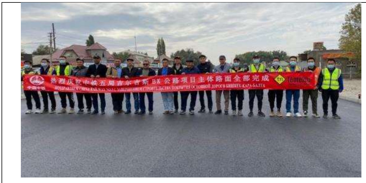
Рисунок 6 Завершение укладки асфальтового покрытия на основной дороге с км 15,9 по км 61.
