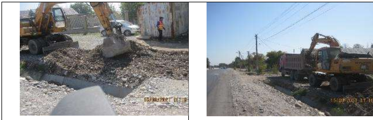
Рисунок 45 Вывоз лишнего грунта, образованного при строительстве водопропускных лотков.
