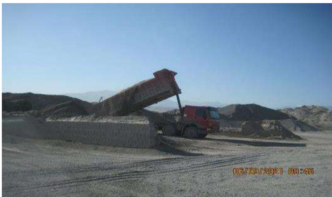
Рисунок 35 Заготовка гравийного материала для производства бетона и асфальта
