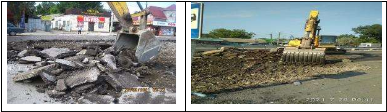
Рисунок 3 Снятие асфальта в с. Сокулук.
