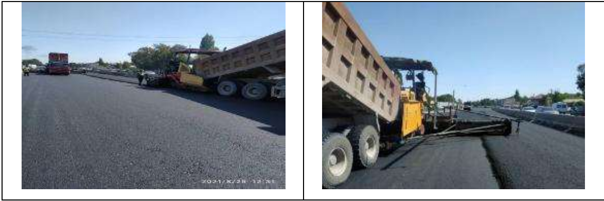
Рисунок 5 Укладка асфальта км 15,9 по км 61.
