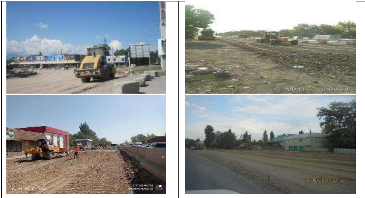
Рисунок 4 Планировка и уплотнение дорожного полотна в с. Сокулук.
