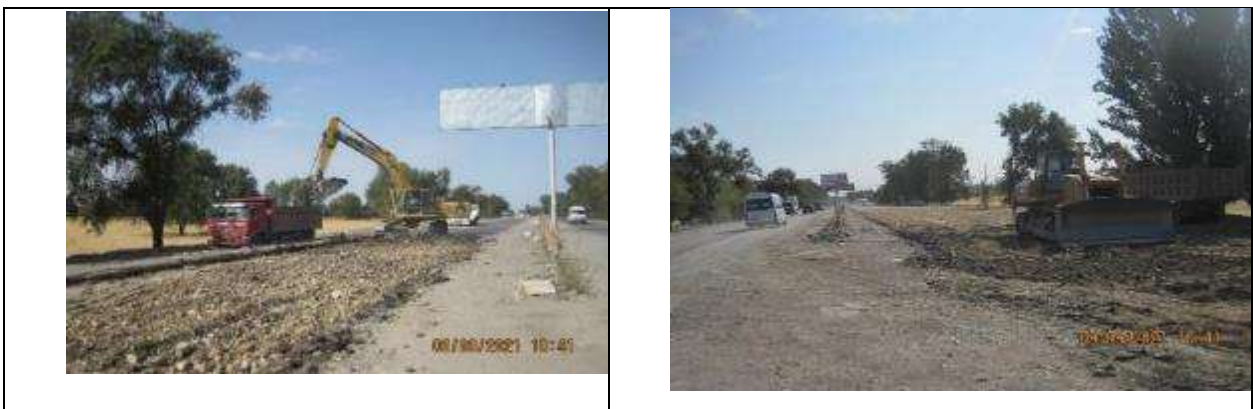
Рисунок 20 Планировка дорожного полотна и вывоз непригодного грунта.
