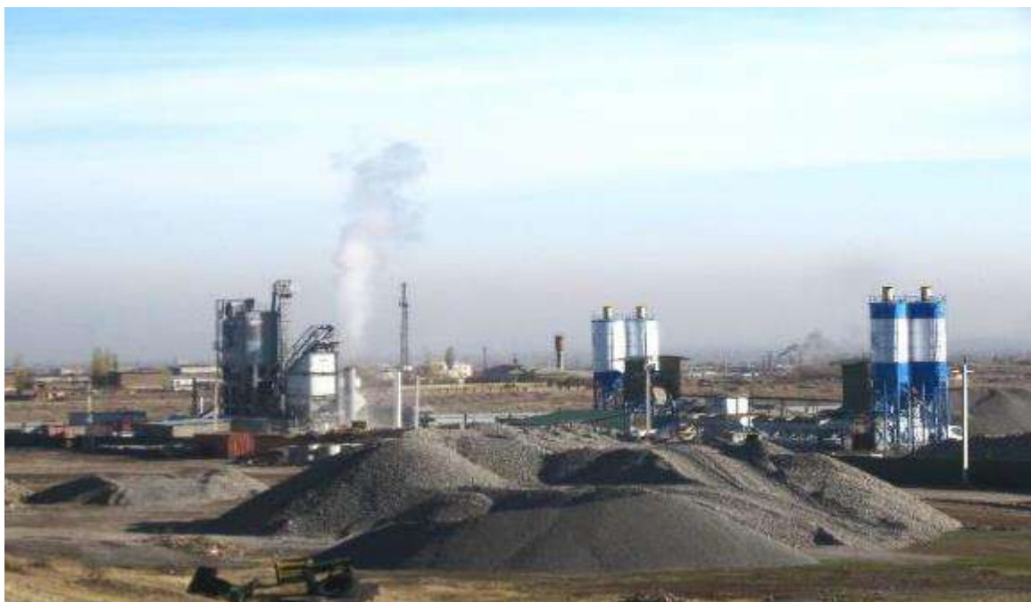
Рисунок 32 Производственная площадка. Бетонно-смесительный завод. Асфальто-битумный завод
