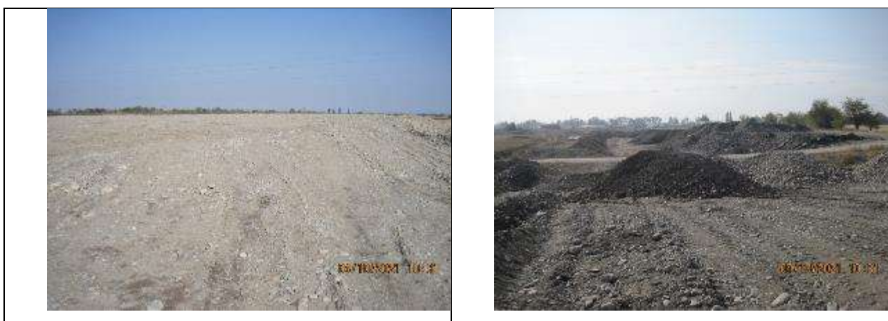
Рисунок 94 Площадка для хранения непригодного грунта после перемещения и планировки непригодного грунта.
