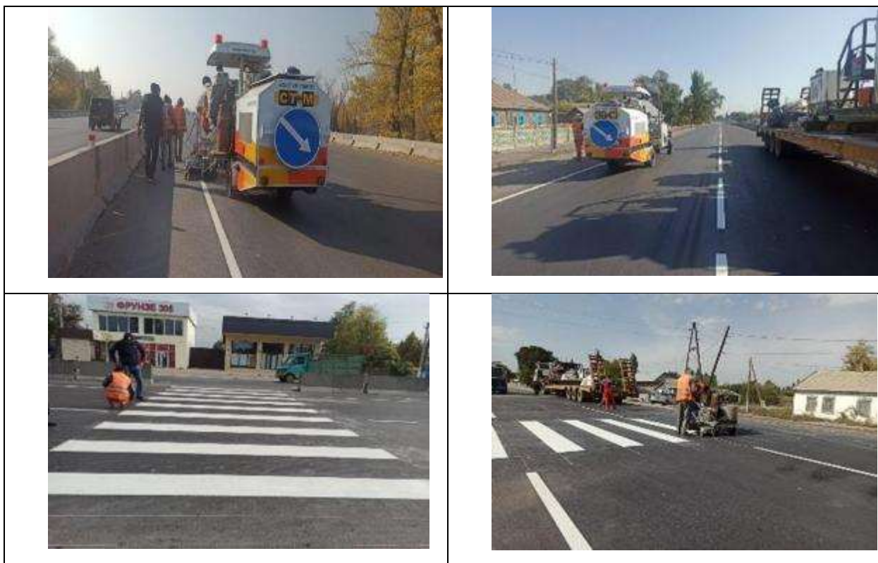
Рисунок 17. Нанесение горизонтальной разметки.
