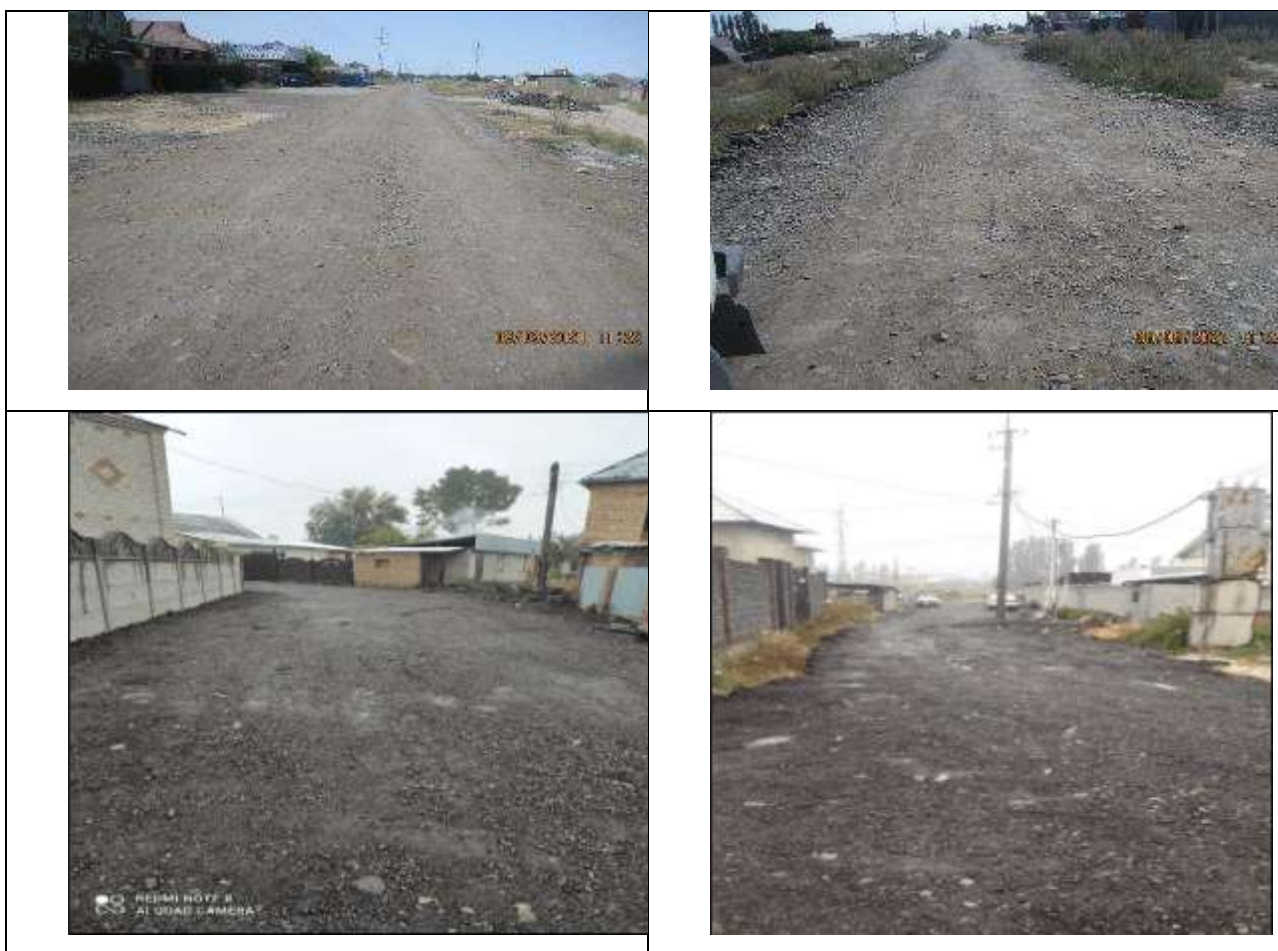
Рисунок 90 Отсыпка старого асфальта на внутренние дороги с. Новопавловка.
