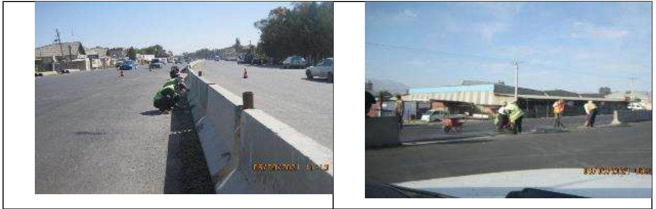
Рисунок 42 . Работы по бетонированию канав на проездах между парапетами.
