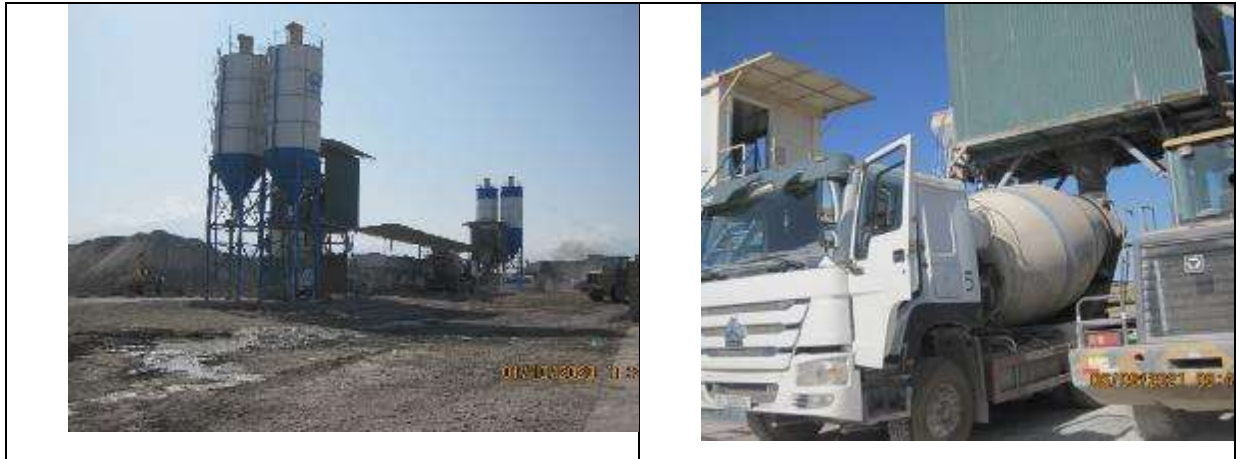
Рисунок 36 Заправка бетоном бетоносмесительной машины
