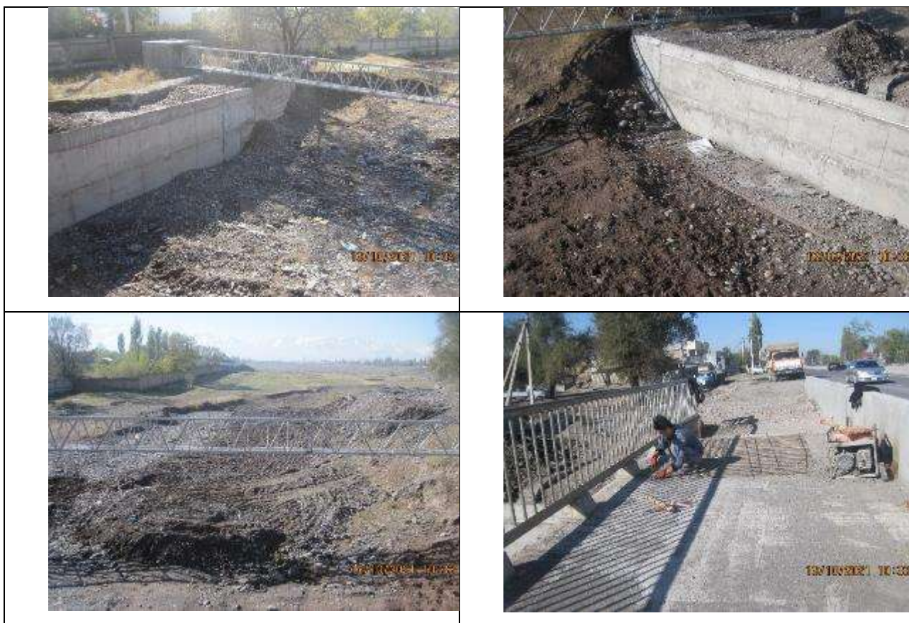
Рисунок 47 Река Ак-Суу после завершения строительства.
