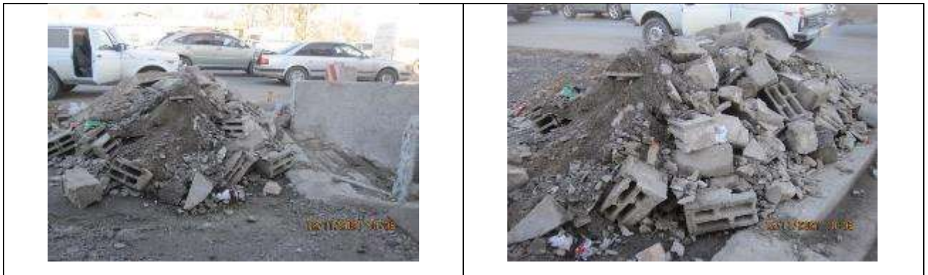
Рисунок 96. Строительные отходы возле строящегося подземного перехода центре с. Сокулук.
