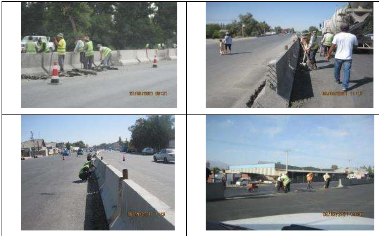
Рисунок 13 Работы по бетонированию канав на проездах между парапетами.
