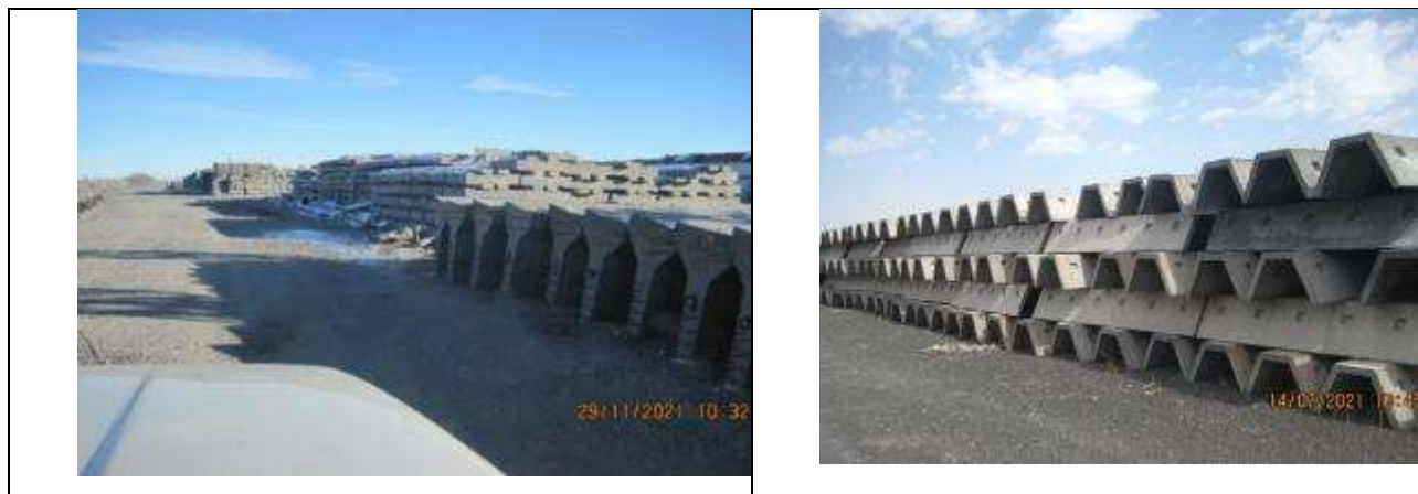
Рисунок 61 Полигон изготовления железобетонных изделий.
