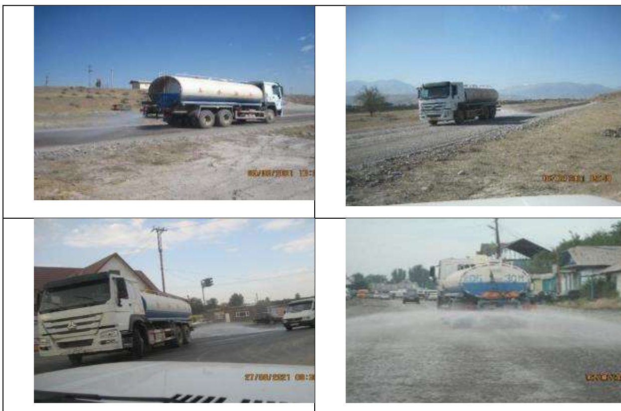
Рисунок 23 Проведение работ по пылеподавлению (гидроорошение). Дорога на карьер Ак-Суу2 и на участке строительства дороги в с. Сокулук.
