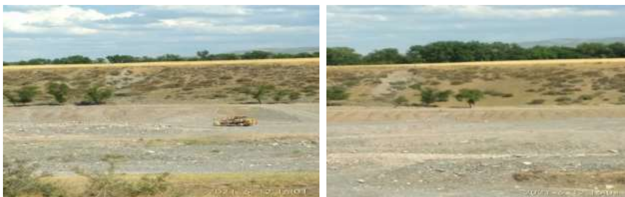
Рисунок 42 Проведение рекультивационных работ на карьере Ак-Суу 2
