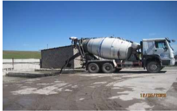
Рисунок 47 Промывка автобетоносмесителей
