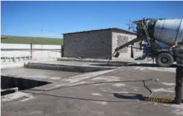
Рисунок 47 Промывка автобетоносмесителей
