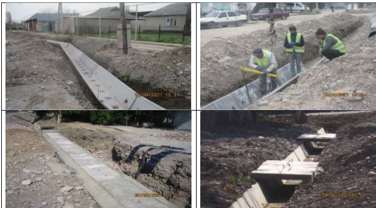
Рисунок 6 Установка придорожных водопропускных лотков и съездов на примыкающие к трассе улицы
