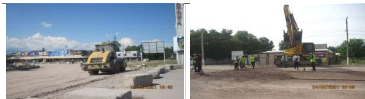
Рисунок 4 Планировка и уплотнение дорожного полотна
