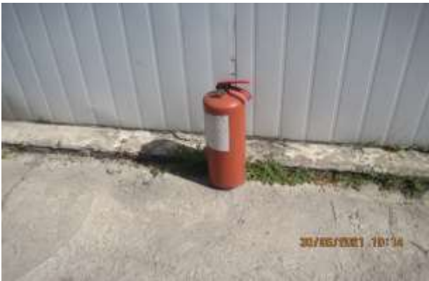
Рисунок 56 Огнетушители, установленные с нарушениями на территории на базе в с. Сокулук
