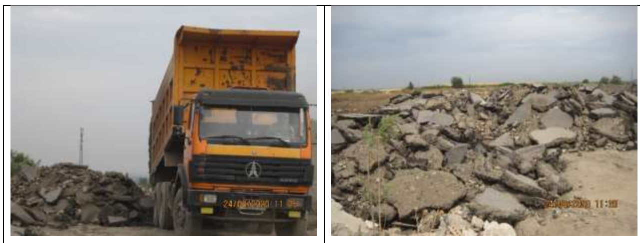
Рисунок 70 Отсыпка старого асфальта на выделенные площадки для дальнейшего использования в с. Романовка
