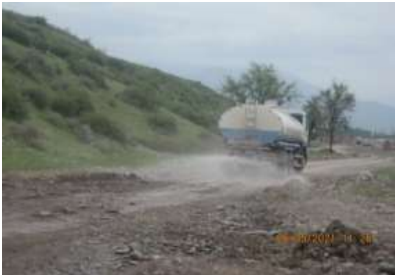
Рисунок 16 Орошение дороги на карьер Ак-Суу 2 для исключения пыления
