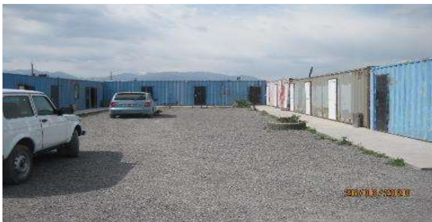
Рисунок 26 Лагерь проживания рабочих на территории промплощадки
