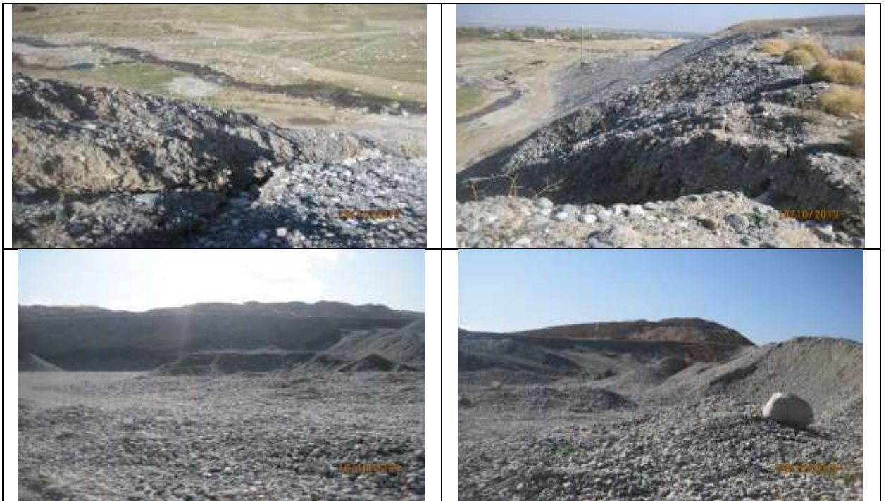
Рисунок 19 Карьер Джеламыш после завершения работ по разработке
