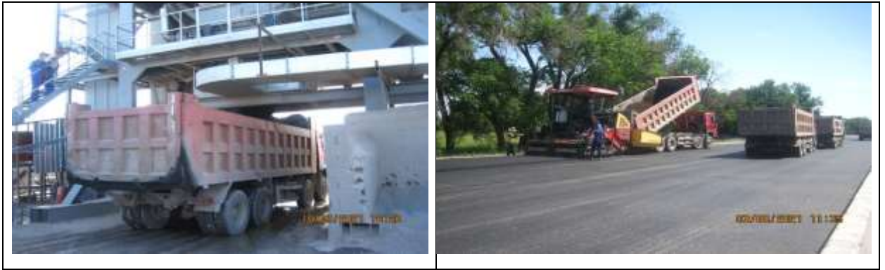
Рисунок 24 Загрузка асфальтовой смеси в самосвалы и выгрузка ее в асфальтоукладчики
