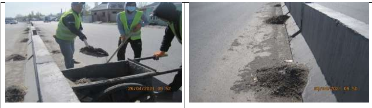
Рисунок 36 Очистка парапетов от накопившегося грунта
