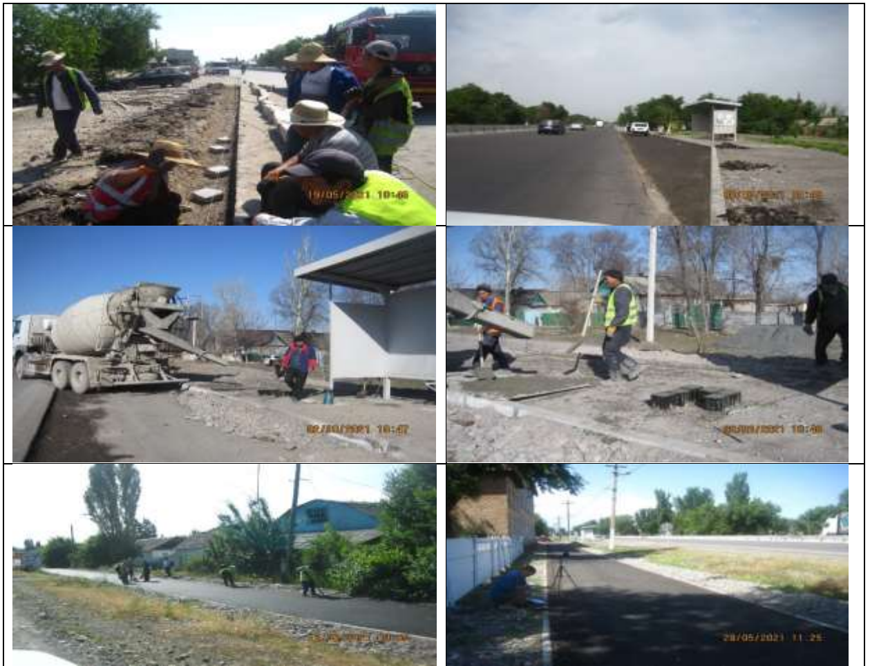
Рисунок 7 Строительство остановок и тротуаров
