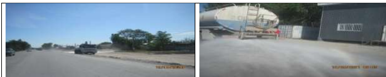
Рисунок 14 Проведение работ по пылеподавлению (гидроорошение)
