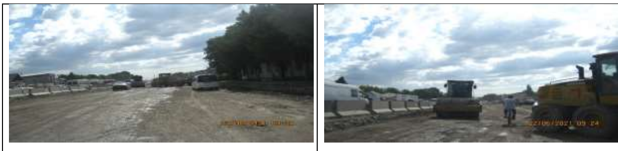
Рисунок 13 Укатка и уплотнение грунта участке км 8+511-8+800
