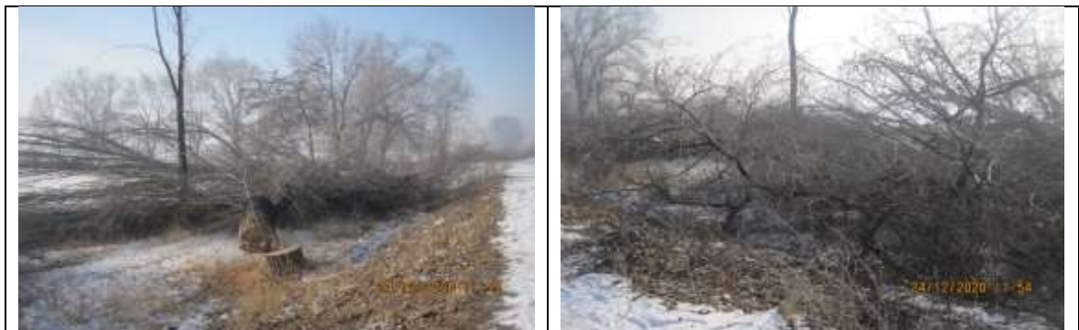
Рисунок 30 Вырубка деревьев на участке дороги км 8,5 – 15,9
