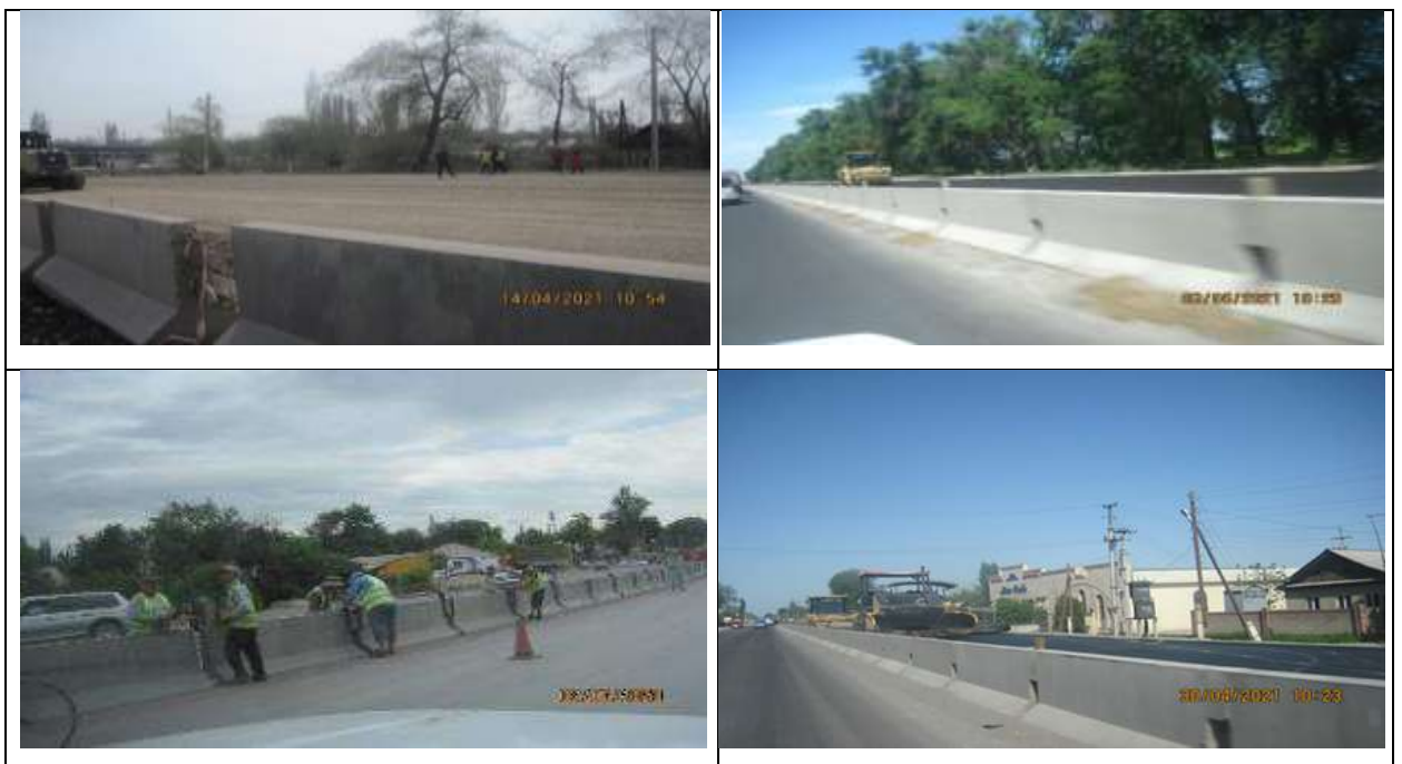
Рисунок 8 Установка и укрепление парапетов типа «Нью Джерси»
