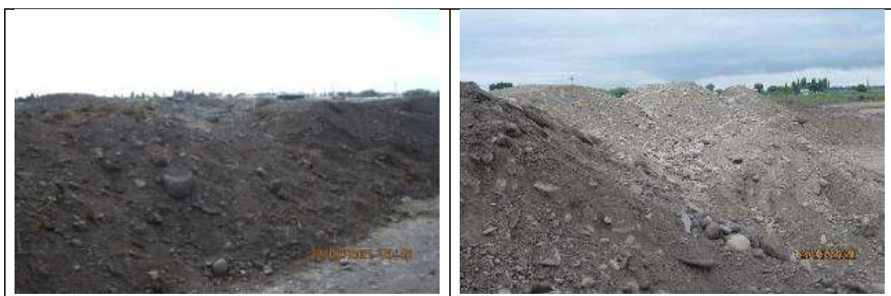
Рисунок 72 Складирование непригодного грунта для дальнейшего использования
