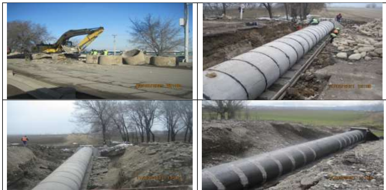
Рисунок 12 Строительство водопропускных труб
