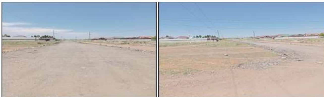
Рисунок 71 Вывоз старого асфальта на территорию жил массива «Алтын Ордо» по просьбе жителей и представителей местного самоуправления
