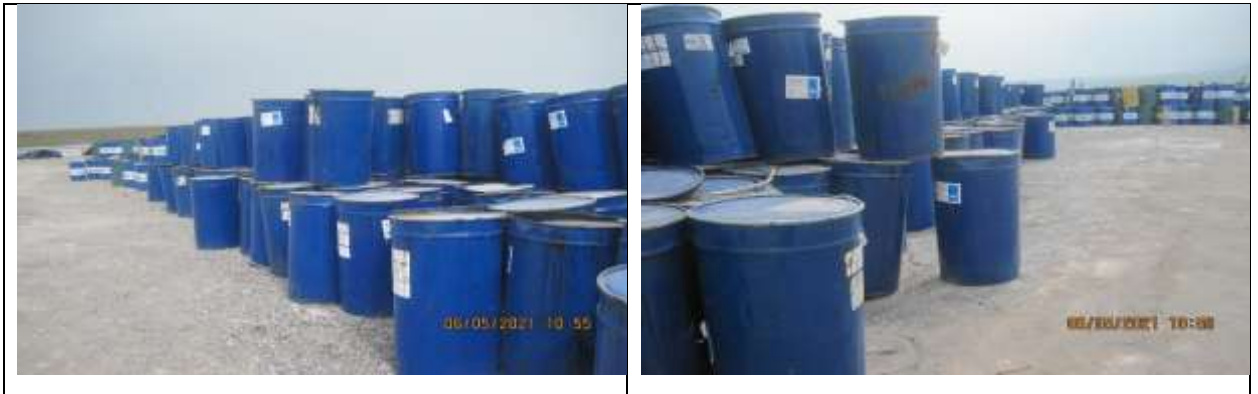
Рисунок 25 Бочки с битумом на специально подготовленной площадке
