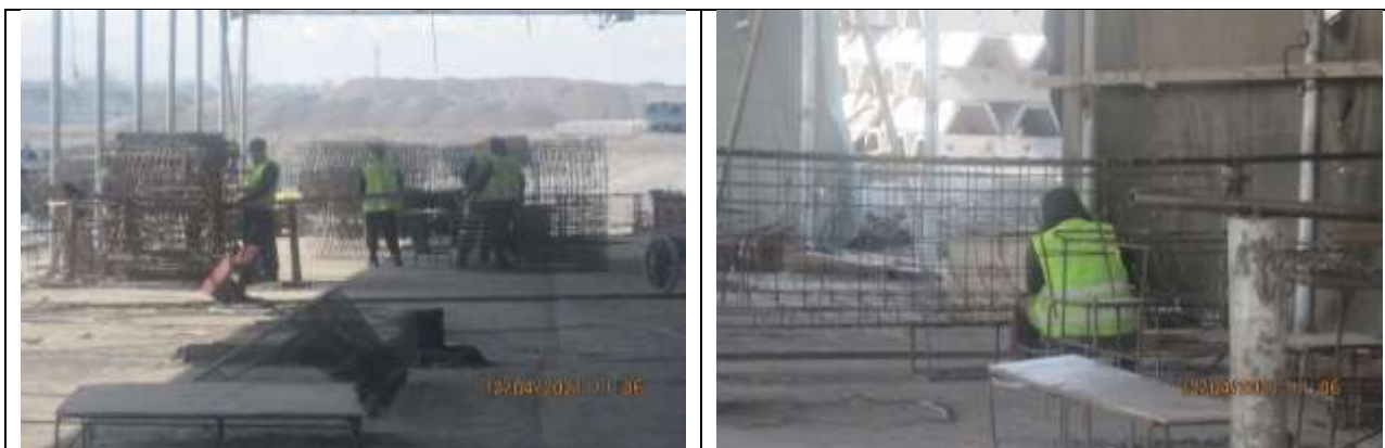
Рисунок 45 Работа арматурно-сварочного участка
