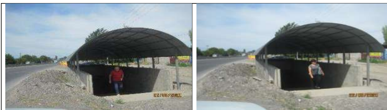
Рисунок 10 Строительство и реабилитация подземных переходов
