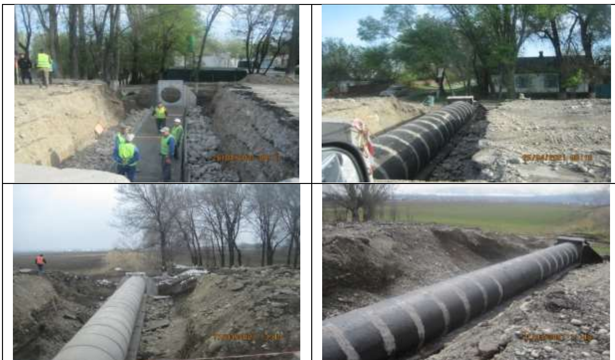
Рисунок 32 Укладка труб на участке 7.4
