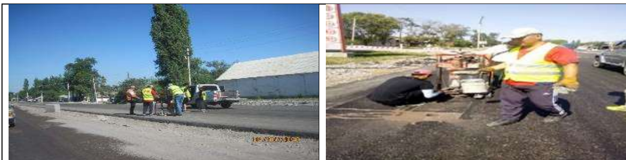
Рисунок 9 Проведение работ по отбору проб для контроля качества асфальта
