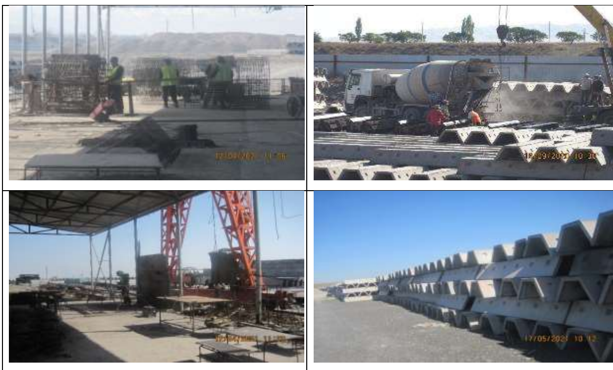
Рисунок 21 Изготовление железобетонных конструкций
