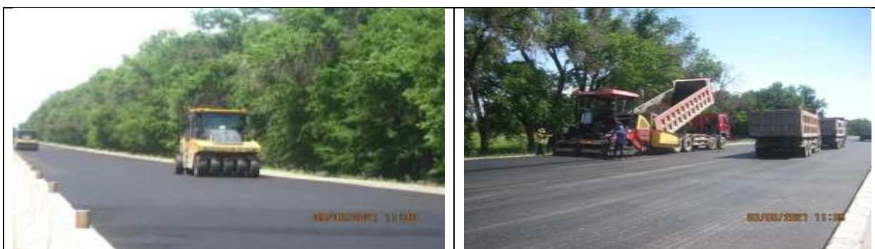
Рисунок 5 Укладка асфальта
