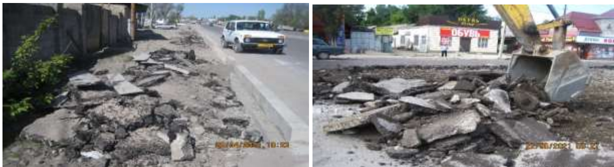
Рисунок 3 Снятие асфальта
