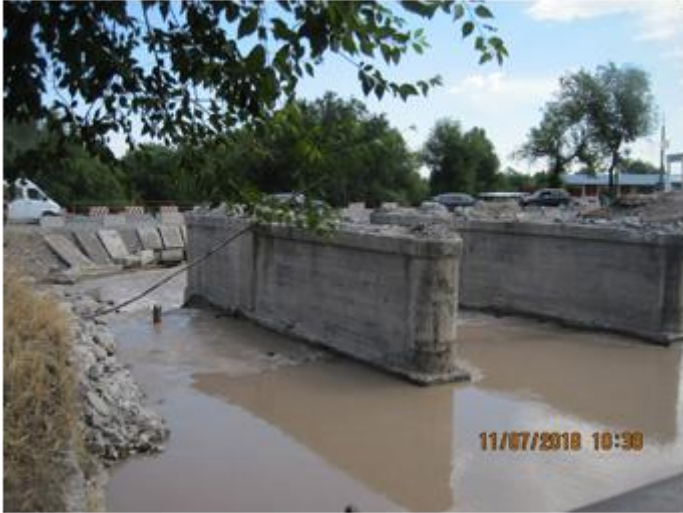
Ak Suu Bridge Site
