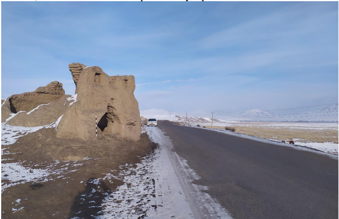
Рис.14. Алтын-Арык 1 Кумбоз у обочины дороги. Полотно дороги со стороны кумбеза рекомендуется выполнить без обочины с устройством заградительных блоков вдоль дороги, установить дорожный знак «остановка запрещена».
