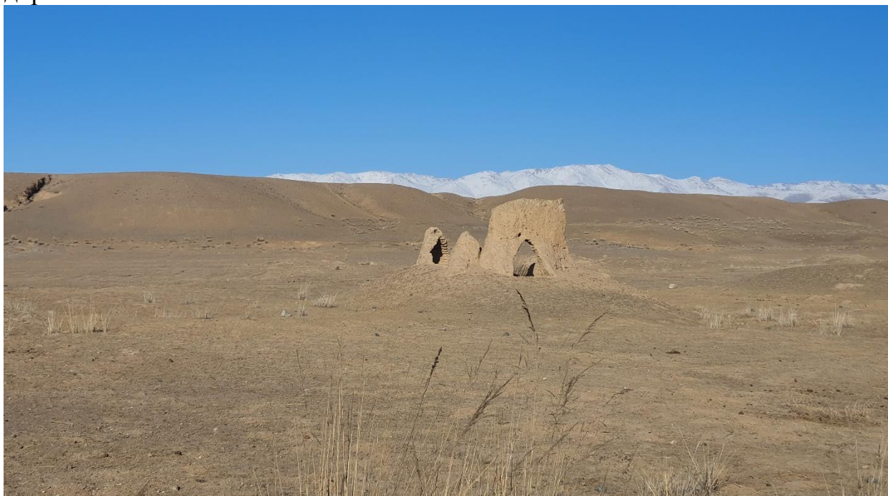
Рис.12. Алтын-Арык 1. Руины кумбеза над курганом оградки в пределах 50 метров от полотна дороги, сохраняется для будущей консервации.
