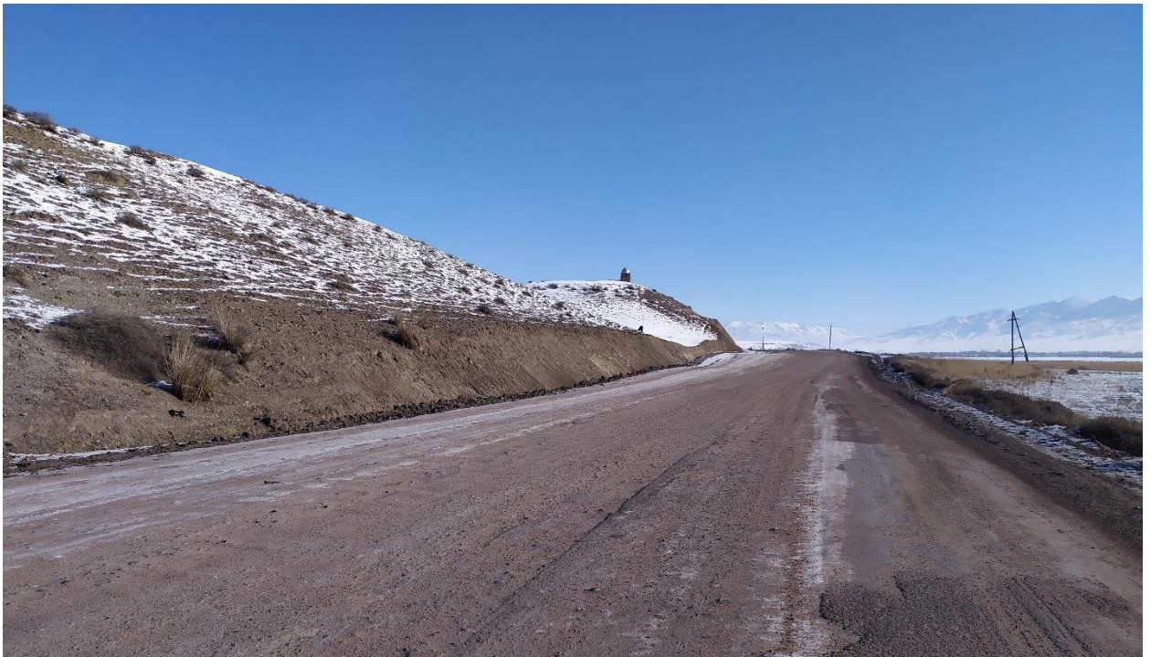
Рис.31. Тугол-Сай 1-2-3. Процесс строительства дороги. Слева возвышенность с курганами на вершине.
