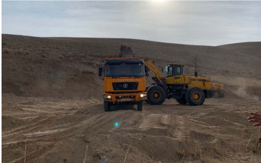
Рисунок 5-3 Работы на карьере заимствования км 75+400 (Лот 2А)
