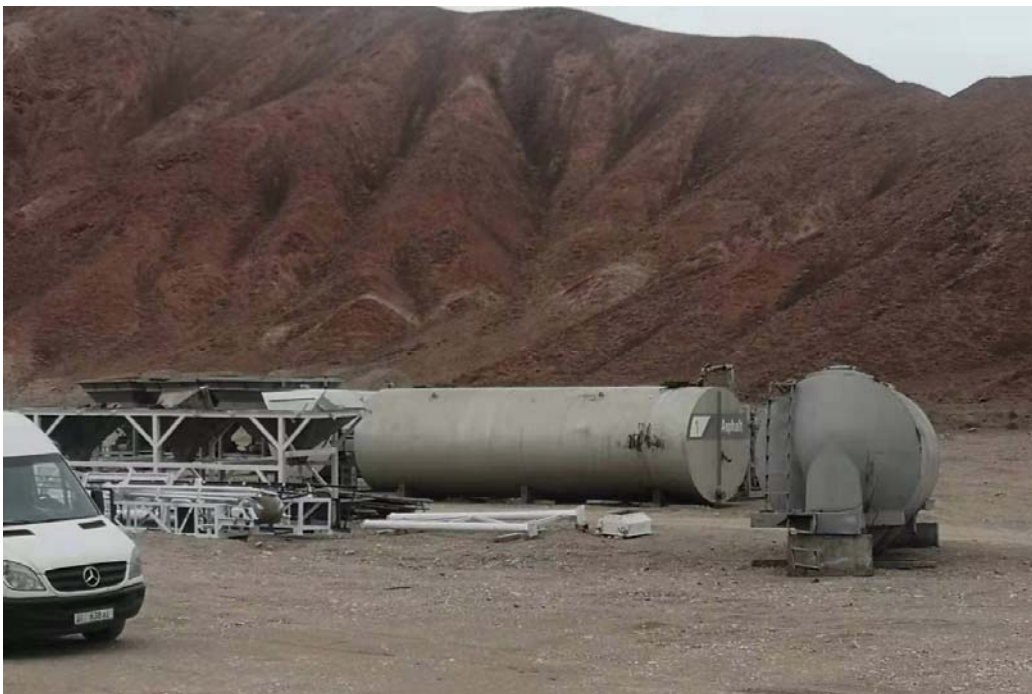
Фото № 6 Завод по производству асфальта, доставленный на Лот 1 (28 февраля 2021 г.).
