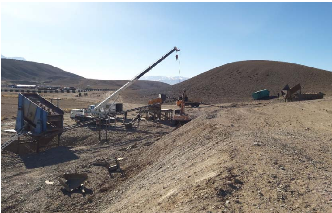
Фото № 4 Строительство камнедробилки на Лот 2 (28 февраля 2021 г.)
