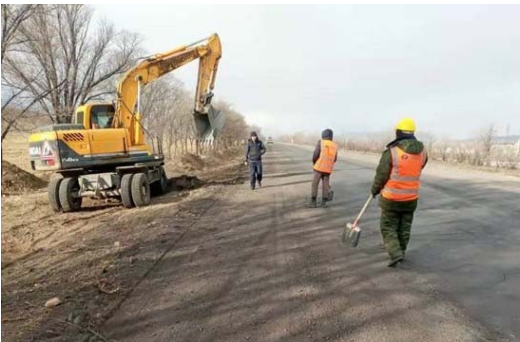
Фото № 10 Очистка верхнего слоя почвы на обочине дороги на Лот 2 (февраль 2021 г.)
