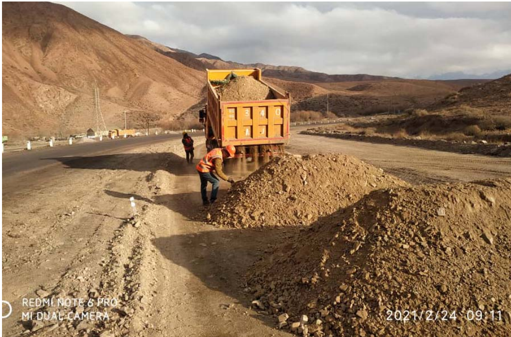
Фото № 11 Заполнение под-основания дороги на 1-ом Лоте (24 февраля 2021 г.)
