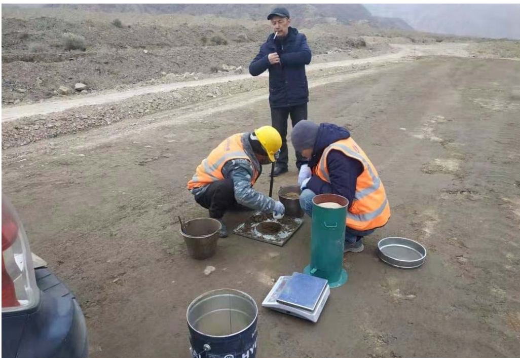
Фото № 12 Полевой тест плотности при строительстве под-основания дороги на Лот 1 (19 февраля 2021 года)
