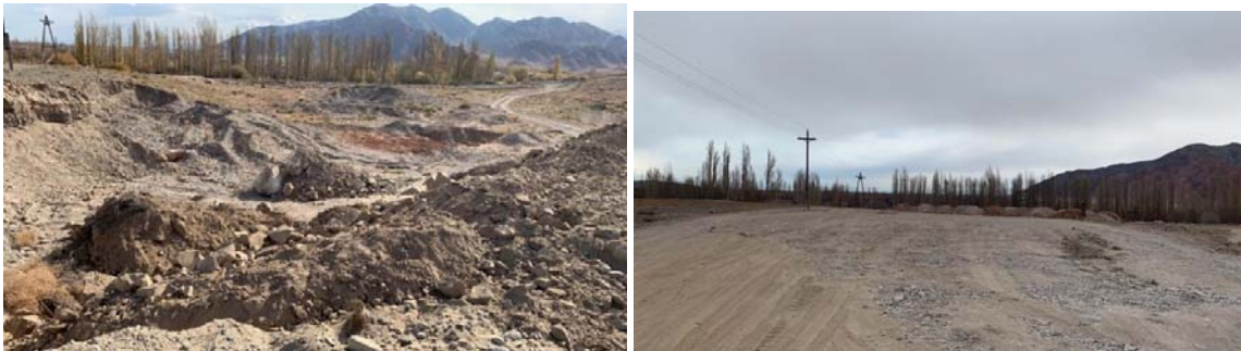
Рисунок 5-1 Территория под отвал непригодного грунта на км 12+060 (до складирования и после складирования)
