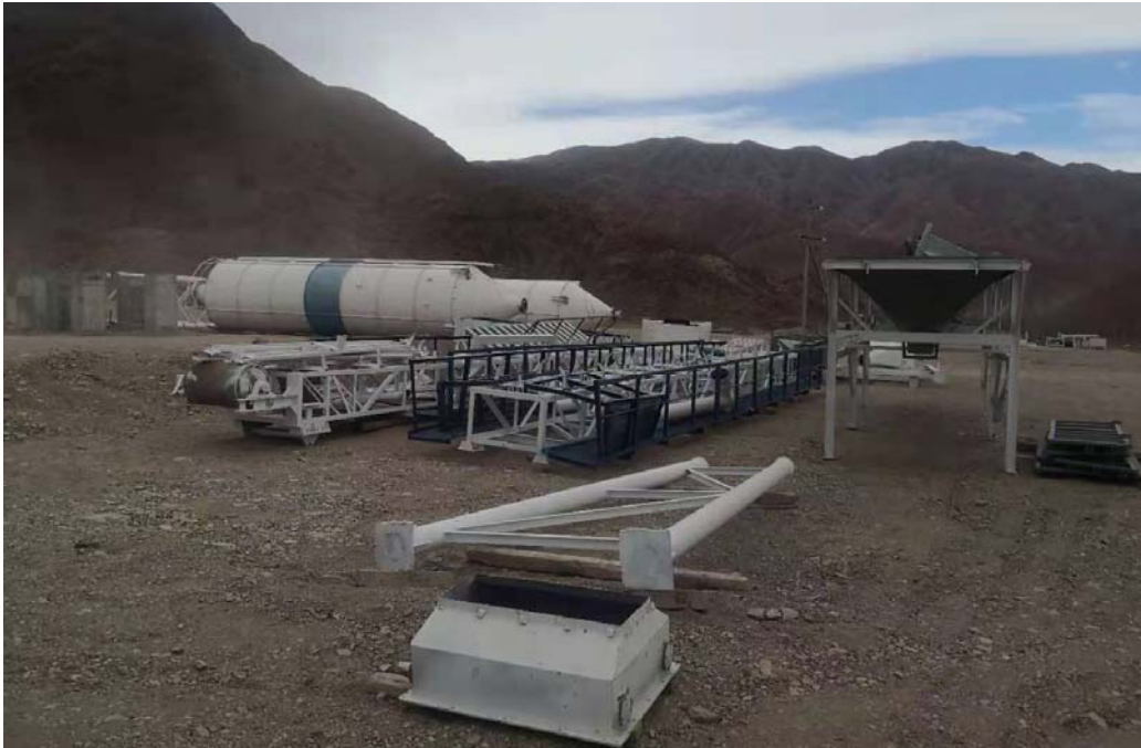
Фото № 5 Бетонный завод, доставленный на 1-й Лот (28 февраля 2021 г.).
