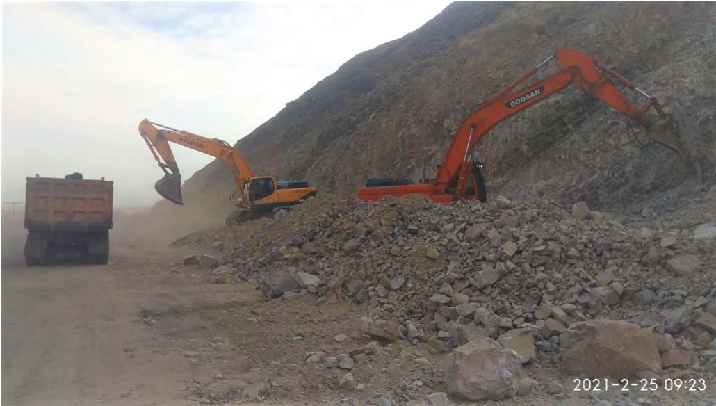
Фото № 9 Эскавация скального грунта на 1-м Лоте на км 13+500 (25 февраля 2021 г.)
