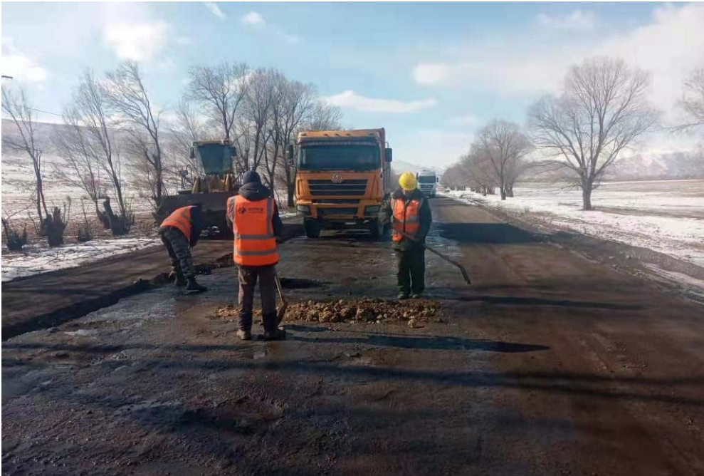
Фото № 7 Техническое обслуживание дорог (заполнение ямы) Лот 1 (28 февраля 2021 г.)
