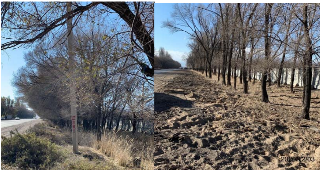
Рисунок 6-3 Лот 1. Участок дороги км 1+813 слева до рубки деревьев и после.
