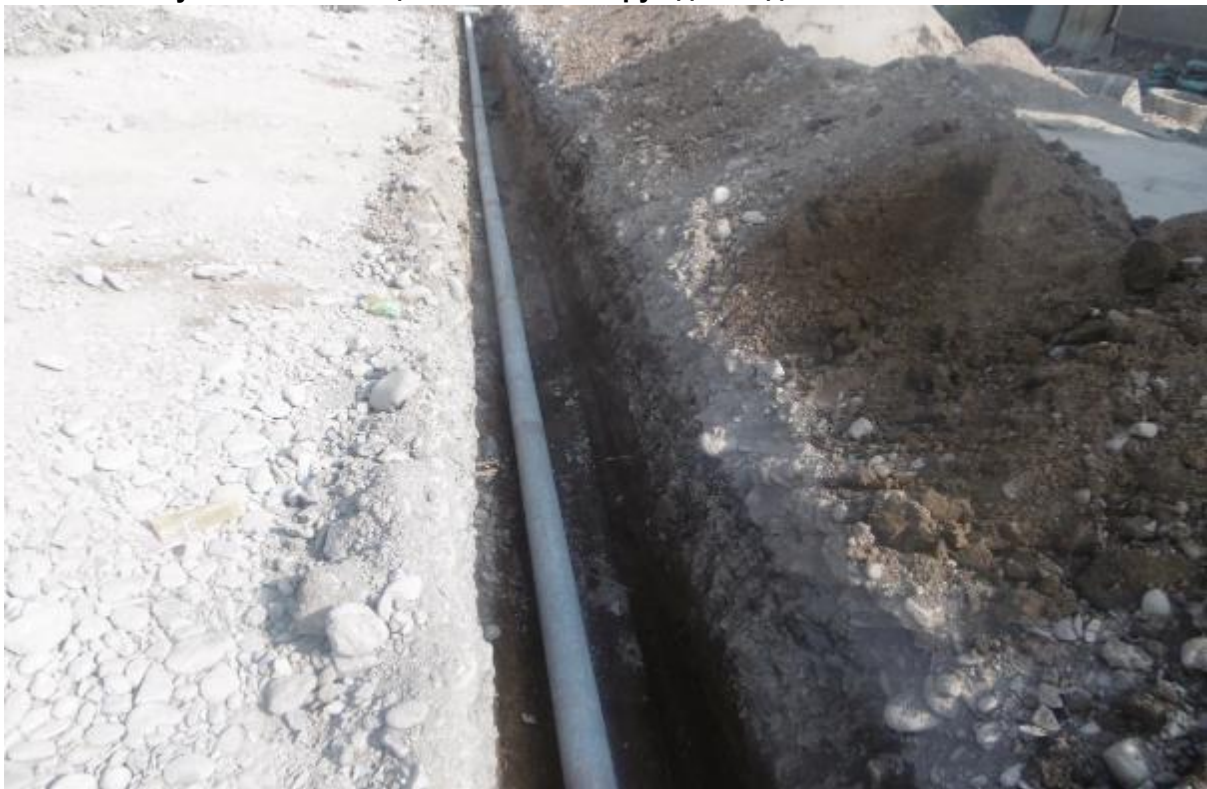
Рисунок 2-4: Размещение бетонных труб для подземных кабелей связи
